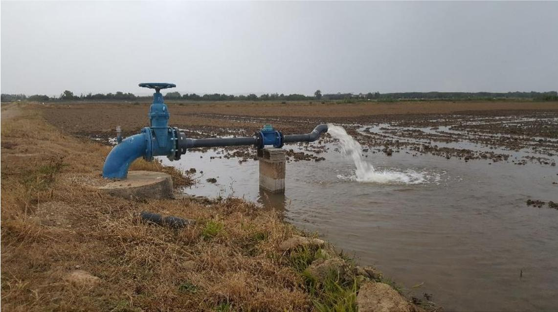
**Figura 22. Ilustración del hidrante y válvula de compuerta en la parcela RIC.**
