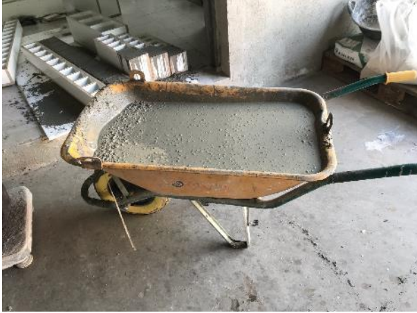
Imatge 61. Massa de formigó sense addició de fibra. Font: pròpia
