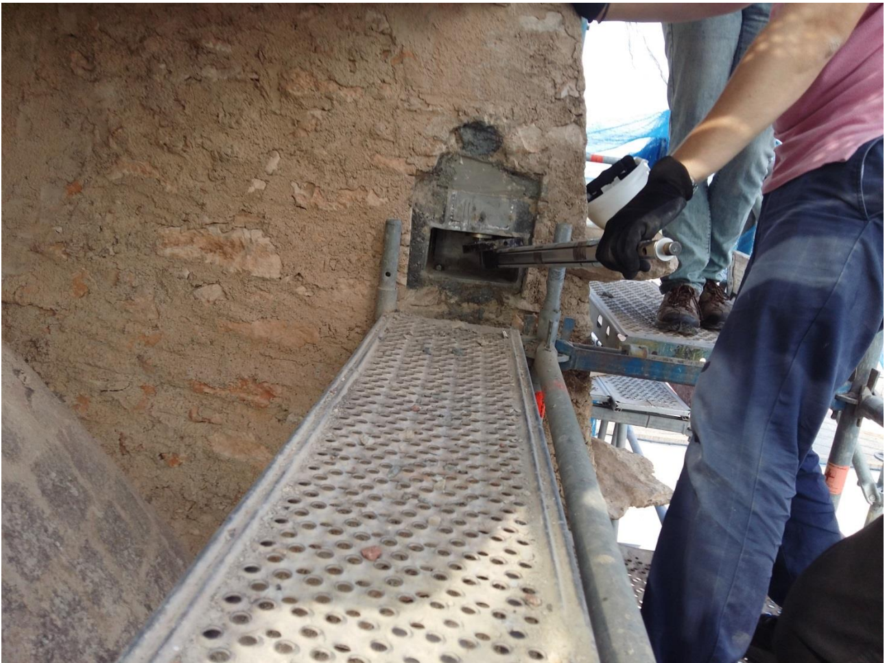
Figura 22: Execució del tesat mitjançant la clau dinamomètrica
