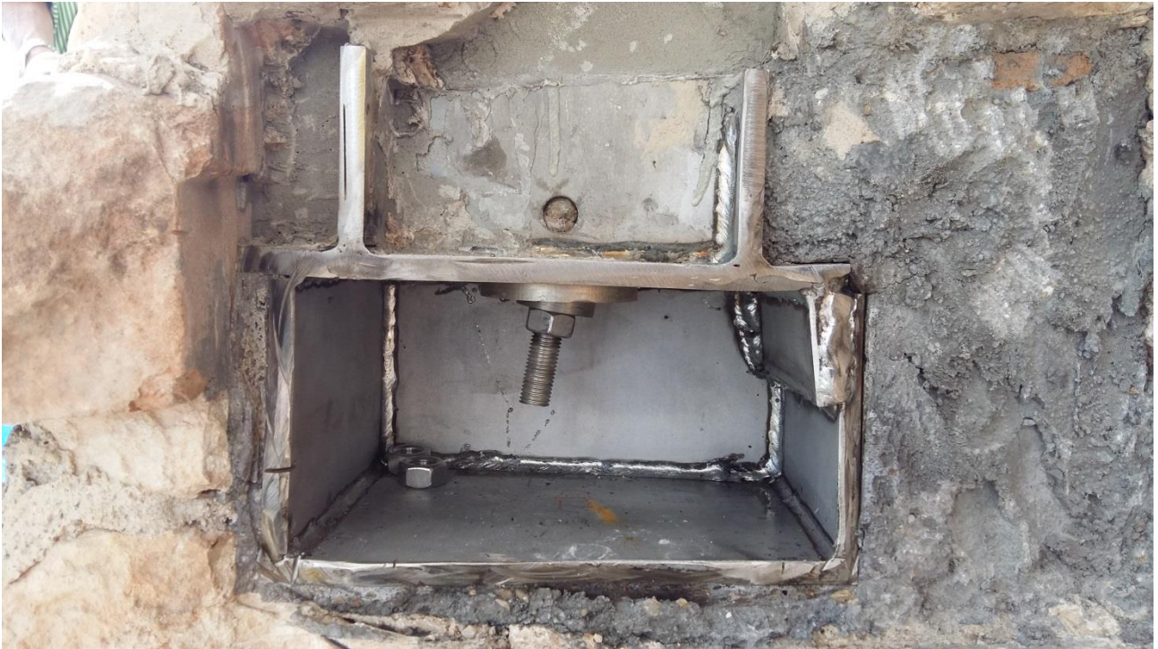
Figura 16: Calaix a la base del campanar, per a tensar les barres
