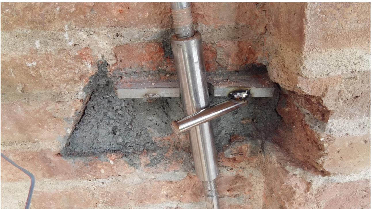
Figura 17: Platina de suport dels tirants a cada nivell
