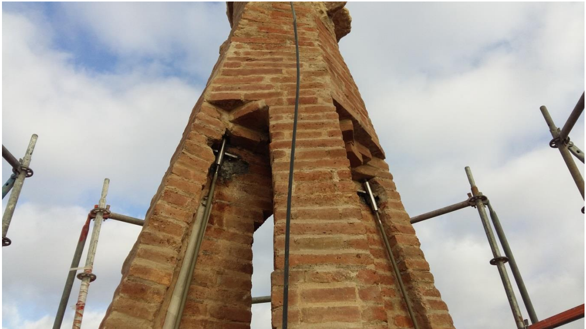
Figura 18: Unió dels tirants al coronament
