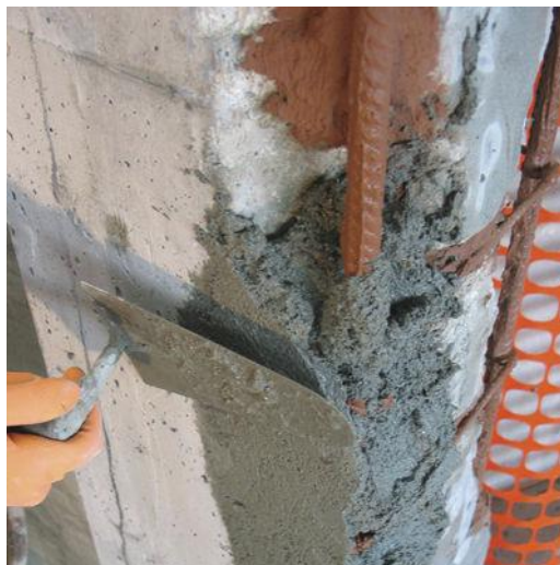
Fotografia 11 – Morter de reparació amb ciment CEM I
