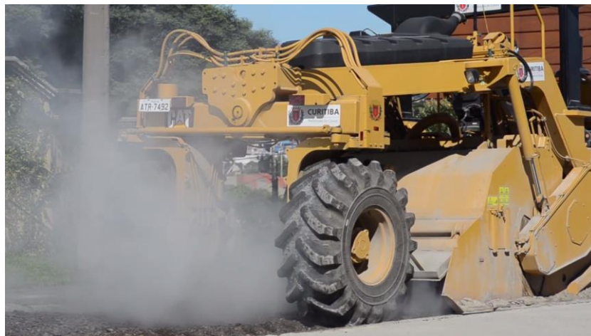
Figura 5. Despreniment de partícules durant la recuperació d'asfalt.
