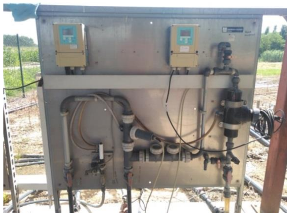
Figura 21. Panell de mesura de la qualitat de sortida on es pot veure la disposició dels sensors i els transmissors corresponents.
