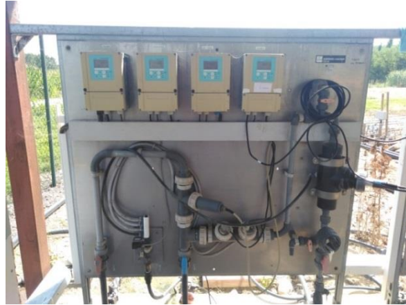
Figura 20. Panell de mesura de la qualitat d'entrada on es pot veure la disposició dels sensors i els transmissors corresponents.
