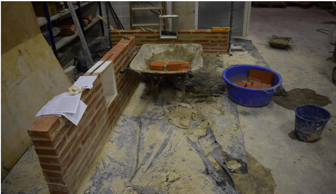
Imatge 066. Zona de treball a l'hora de construir la base del mur 03, fase 01 [mur posterior], al costat del mur 01 [mur davanter].
