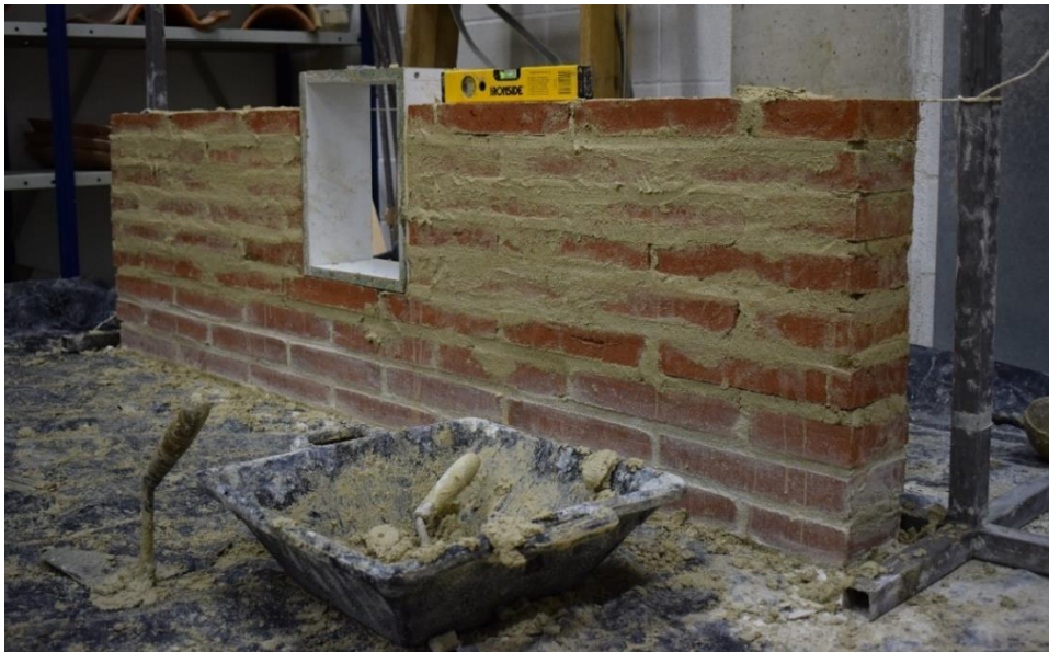
Imatge 070. Construcció de la base del mur 03, fase 1 (03).
