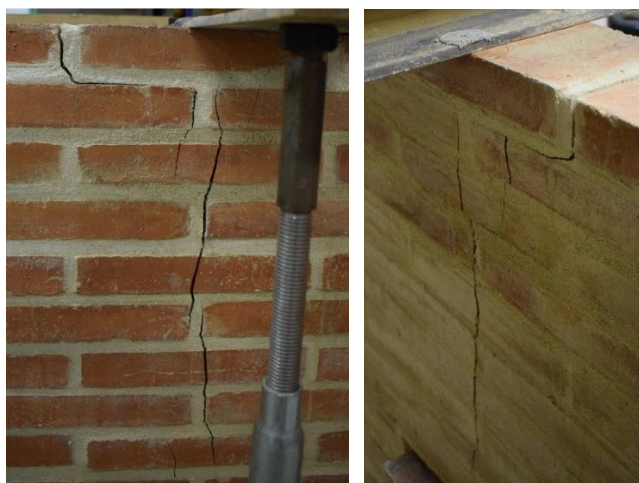
Imatges 166 i 167. 166- Detall de les esquerdes en el mur 01. 167- Detall de les esquerdes en la cara posterior del mur 01.
