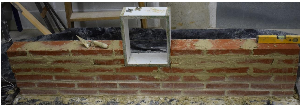
Imatge 067. Construcció de la base del mur 03, fase 1 (02).
