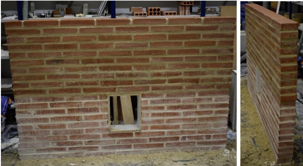
Imatges 078 i 079. 078- Construcció del mur 02, fase 2 (01). 079- Construcció de la base del mur 02, fase 2 (02).
