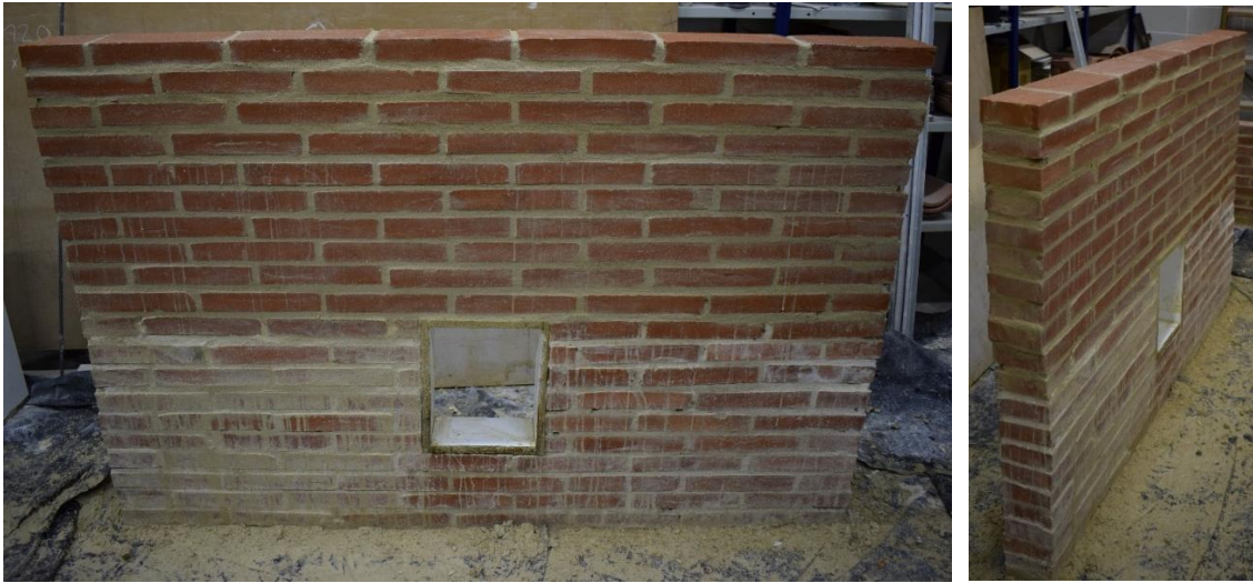
Imatges 073 i 074. 073- Construcció del mur 01, fase 2 (01). 074- Construcció de la base del mur 01, fase 2 (02).
