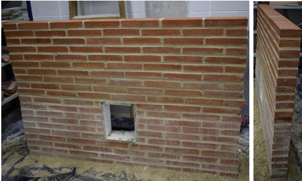
Imatges 082 i 083. 082- Construcció del mur 03, fase 2 (01). 083- Construcció de la base del mur 03, fase 2 (02).
