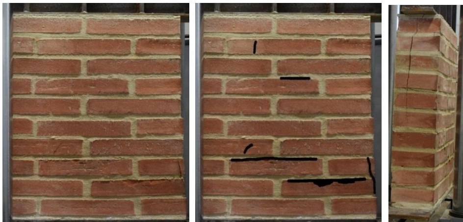
Imatges 125, 126 i 127. 125- Seguiment de les esquerdes que sorgeixen a la proveta d'obra de fàbrica 01 (02). 126- Remarcat de les esquerdes que sorgeixen a la proveta d'obra de fàbrica 01 (02). 127- Seguiment de les esquerdes que sorgeixen a la proveta d'obra de fàbrica 01, cantell (01).
