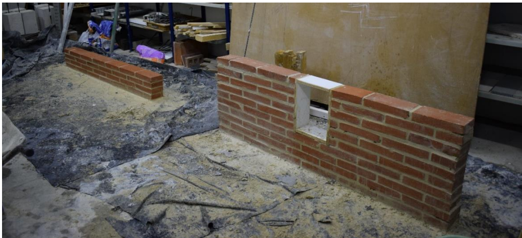
Imatge 061. Construcció de la base del mur 02, fase 1 (02) [esquerra], al costat de la base del mur 01 [dreta].
