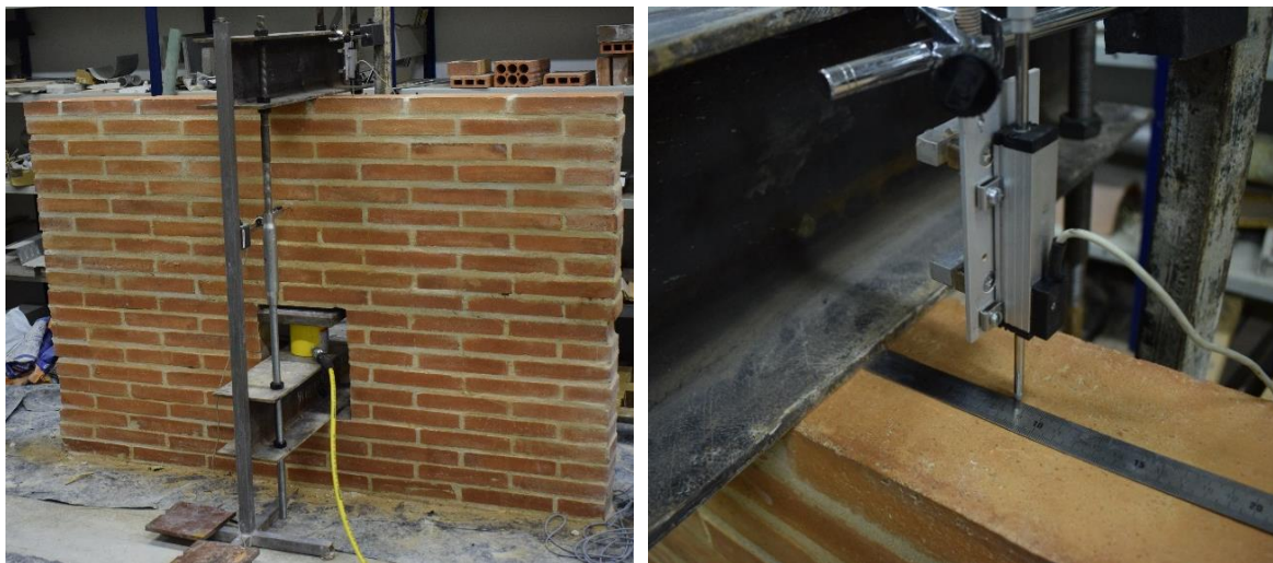
Imatges 111 i 112. 111- Col·locació dels elements en el mur 02. 112- Detall del transductor de desplaçament vertical.
