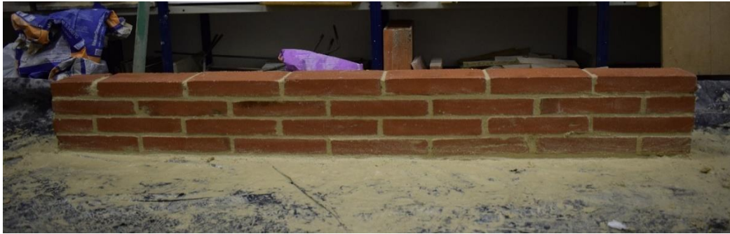
Imatge 060. Construcció de la base del mur 02, fase 1 (01).
