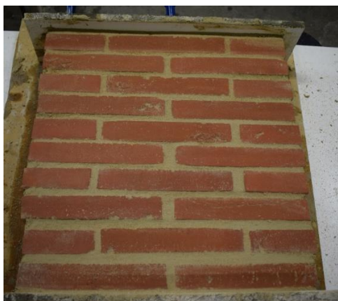
Imatge 081. Construcció de la proveta 02.
