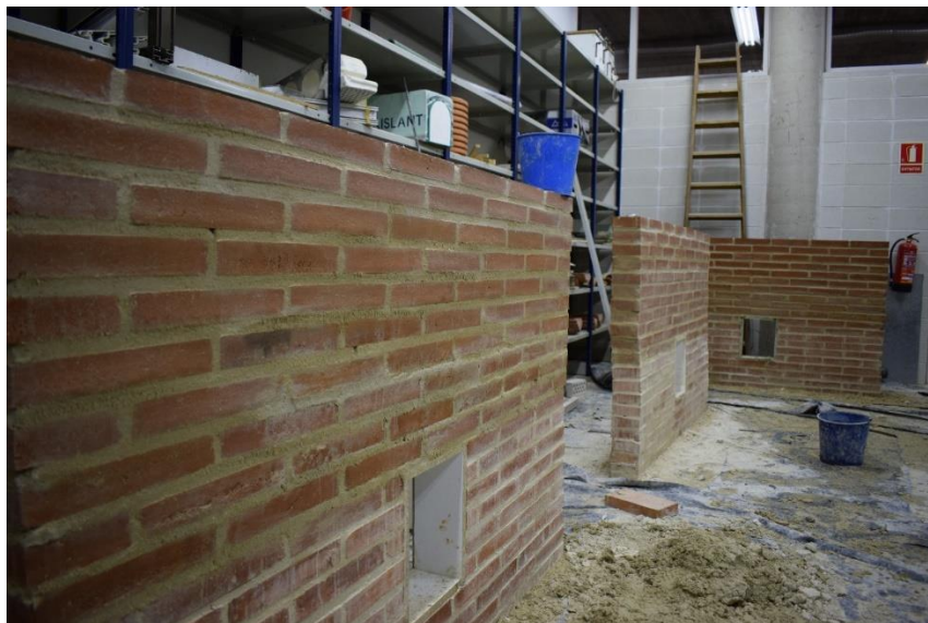
Imatge 084. Construcció acabada del mur 02 [davanter], mur 01 [centre] i mur 03 [posterior].
