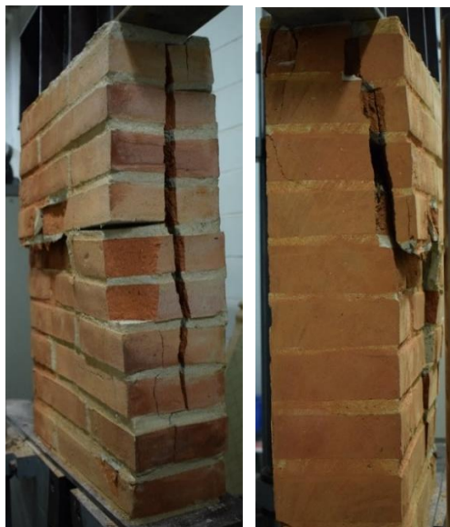
Imatges 148 i 149. 148- Estat final de la proveta 02 en la cantonada dreta. 149- Estat final de la proveta 02 en la cantonada esquerra.
