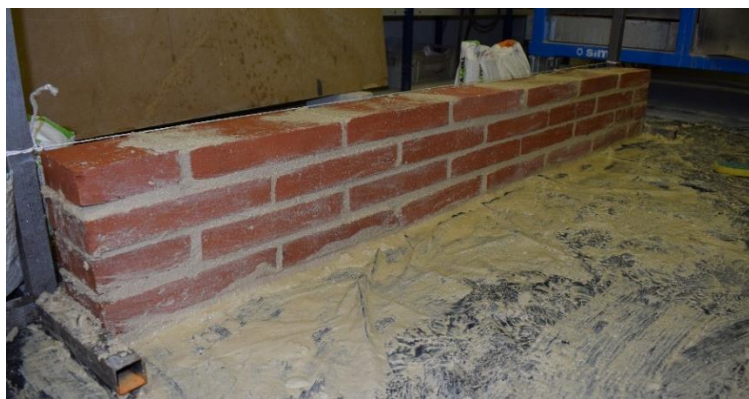
Imatge 058. Construcció de la base del mur 01, fase 1 (01).
