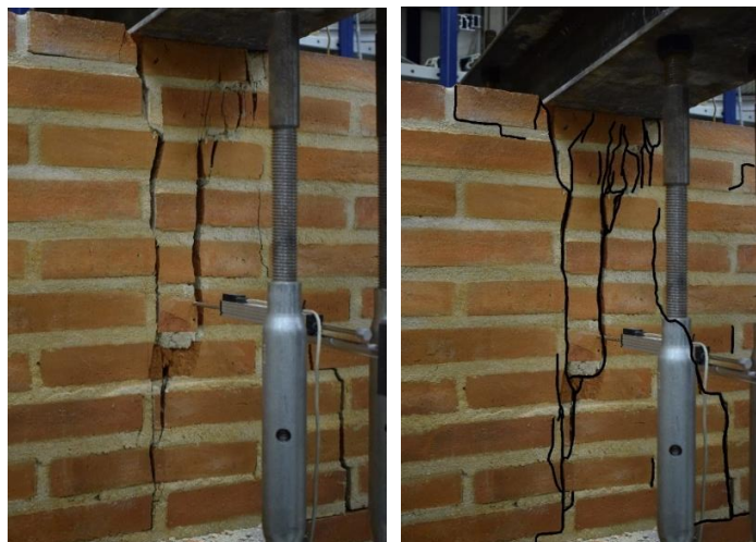
Imatges 174 i 175. 174- Seguiment de les esquerdes que sorgeixen en el mur 02. 175- Remarcat de les esquerdes que sorgeixen el mur 02.s
