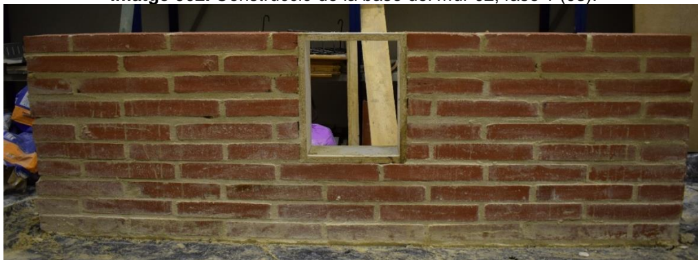
Imatge 063. Construcció de la base del mur 02, fase 1 (04).
