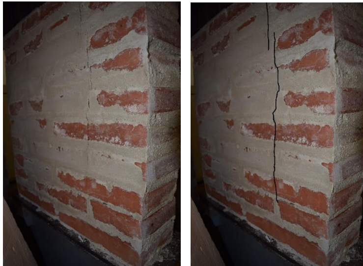
Imatges 029 i 030. 029- Seguiment de les esquerdes que sorgeixen en la proveta de fàbrica de prova (3). 030- Remarcats de les esquerdes que sorgeixen en la proveta de fàbrica de prova (3).
