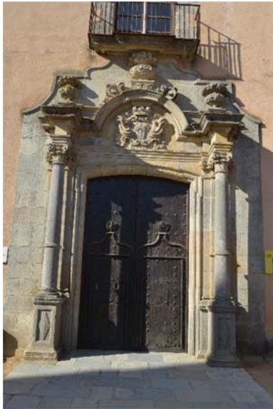
Fig. 6.26.3. Porta d'entrada a l'edifici. Font: Pròpia
