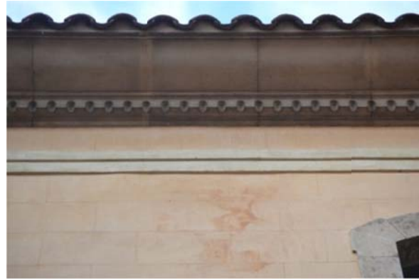
Fig. 6.11.5. Pre cornisa de pedra i cornisa dentada. Font: Pròpia
