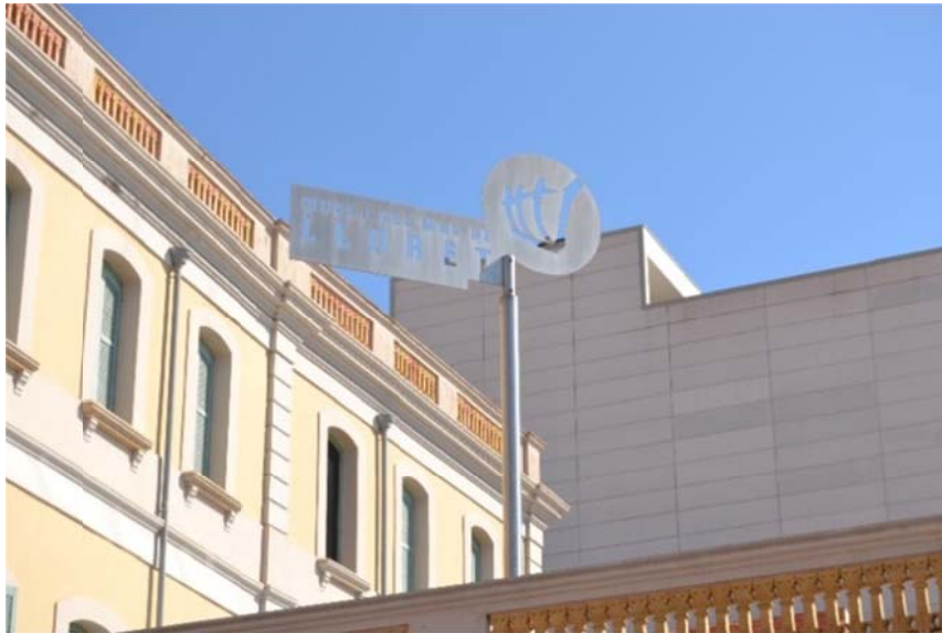
Fig. 6.19.4. Pal en terrassa de planta primera. Font: pròpia
