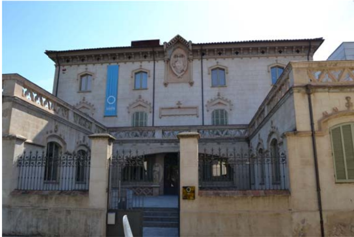
Fig. 6.22.1. Façana del museu. Font: Pròpia
