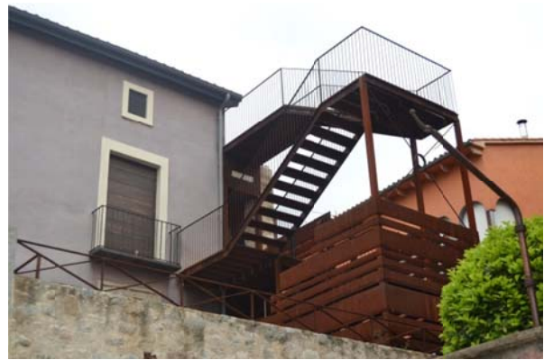
Fig. 6.25.6: Mòdul de planxa corten amb escala d'emergència. Font: pròpia.
