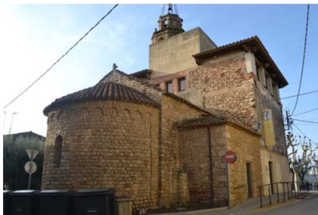
Fig. 6.5.1. Façana del museu. Font: Pròpia
