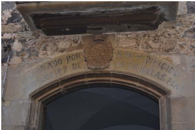
Fig. 6.20.2. Escut reial a la façana del museu. Font: Pròpia
