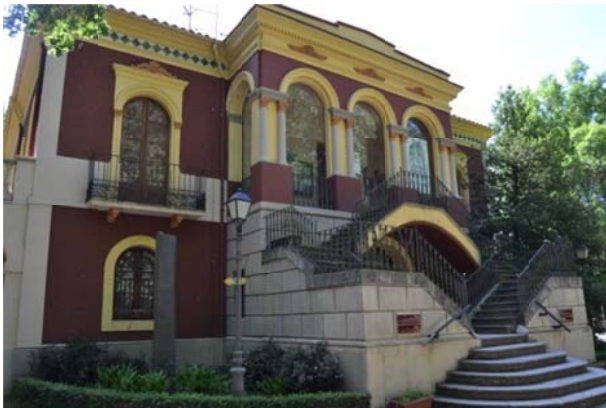
Fig. 6.21.1. Façana del museu. Font: pròpia
