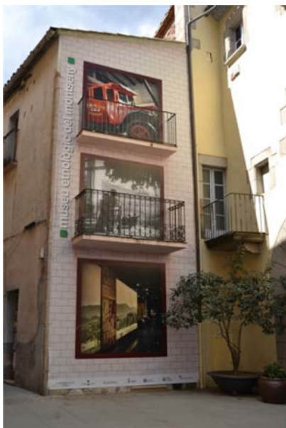
Fig. 6.1.2. Lona que cobreix façana annexa. Font: pròpia
