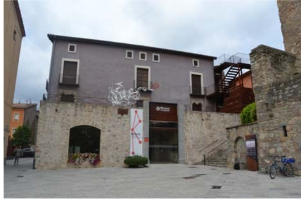
Fig. 6.25.2. Façana actual de Can Budallés. Font: pròpia.
