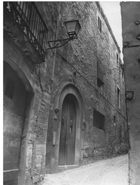
Fig. 6.14.4. Façana de l'edifici entre 1970-1981. Font: Ajuntament de Girona. CRDI.
