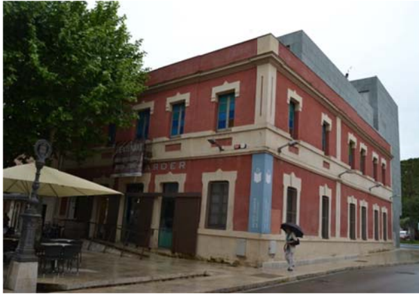
Fig. 6.3.1. Façana del museu. Font: Pròpia
