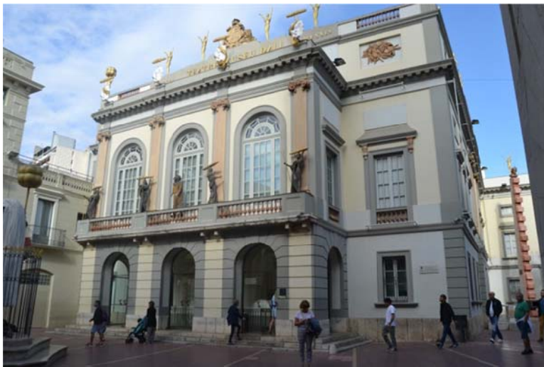
Fig. 6.9.1. Façana de l'antic teatre i actual accés al museu. Font: Pròpia
