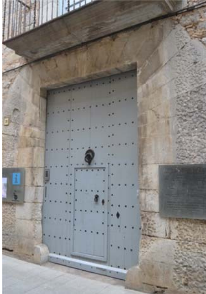
Fig. 6.27.2. Porta d'entrada a l'edifici. Font: Pròpia
