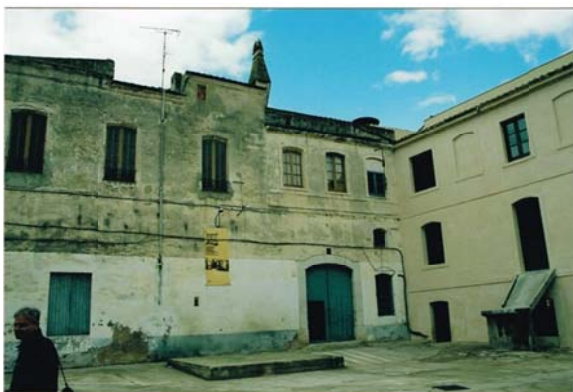
Fig. 6.6.3. Façana abans intervenció. Font: Eco-Museu Farinera de Castelló d'Empúries
