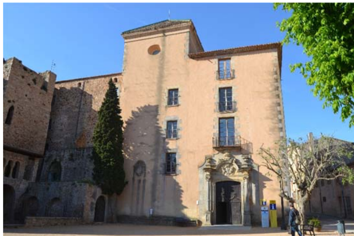
Fig. 6.26.1. Façana del museu. Font: Pròpia
