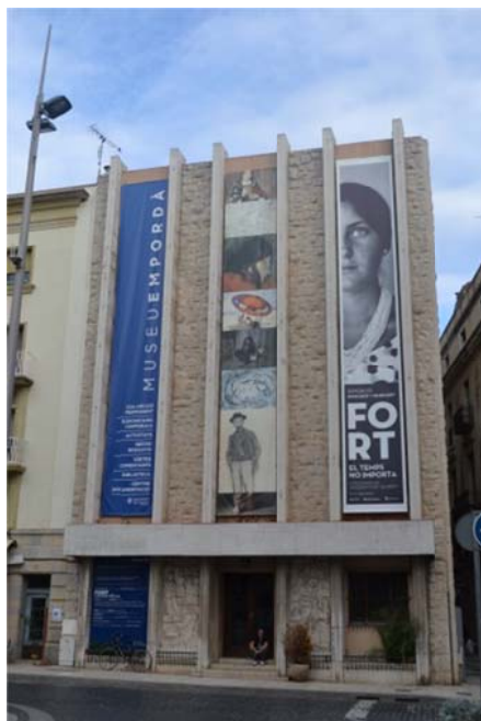
Fig. 6.10.1. Façana del museu. Font: Pròpia
