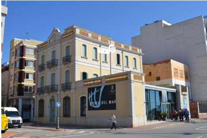
Fig. 6.19.1. Façana del Museu del Mar. Font: Pròpia
