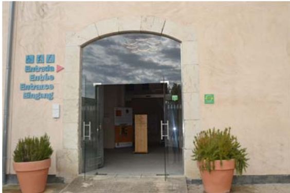
Fig. 6.6.6. Parament de vidre en porta d'entrada. Font: Pròpia
