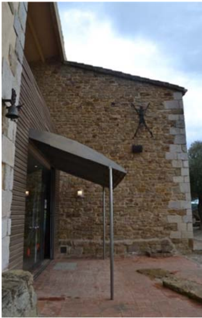
Fig. 6.28.4. Parament de fusta envernissada i pèrgola d'entrada. Font: Pròpia
