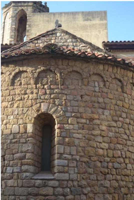
Fig. 6.5.2. Finestra de doble esqueixada i arcuacions llombardes. Font: Pròpia
