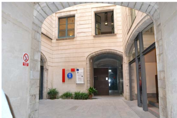
Fig. 6.17.12. Visualització del pati interior des del carrer de la Força. Font: Pròpia
