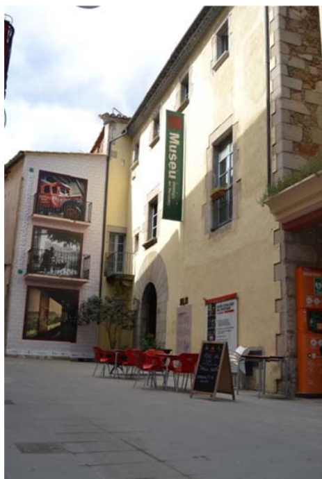
Fig. 6.1.1. Façana del museu. Font: Pròpia
