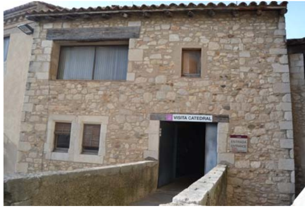
Fig. 6.15.3. Façana que dona accés al museu. Font: Pròpia
