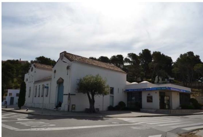
Fig. 6.8.1. Façana del museu. Font: Pròpia
