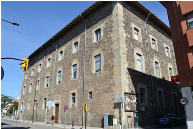
Fig. 6.20.1. Façana del museu. Font: Pròpia
