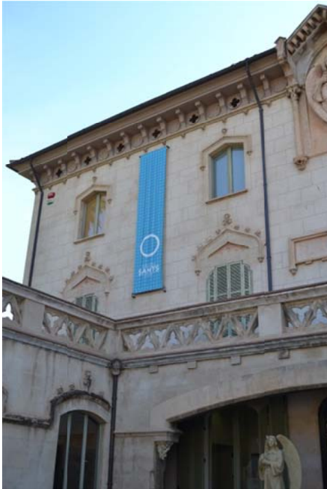
Fig. 6.22.6. Lona en façana. Font: Pròpia
