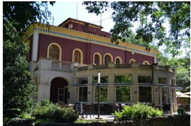
Fig. 6.21.2. Annex a l'edifici del museu. Font: pròpia
