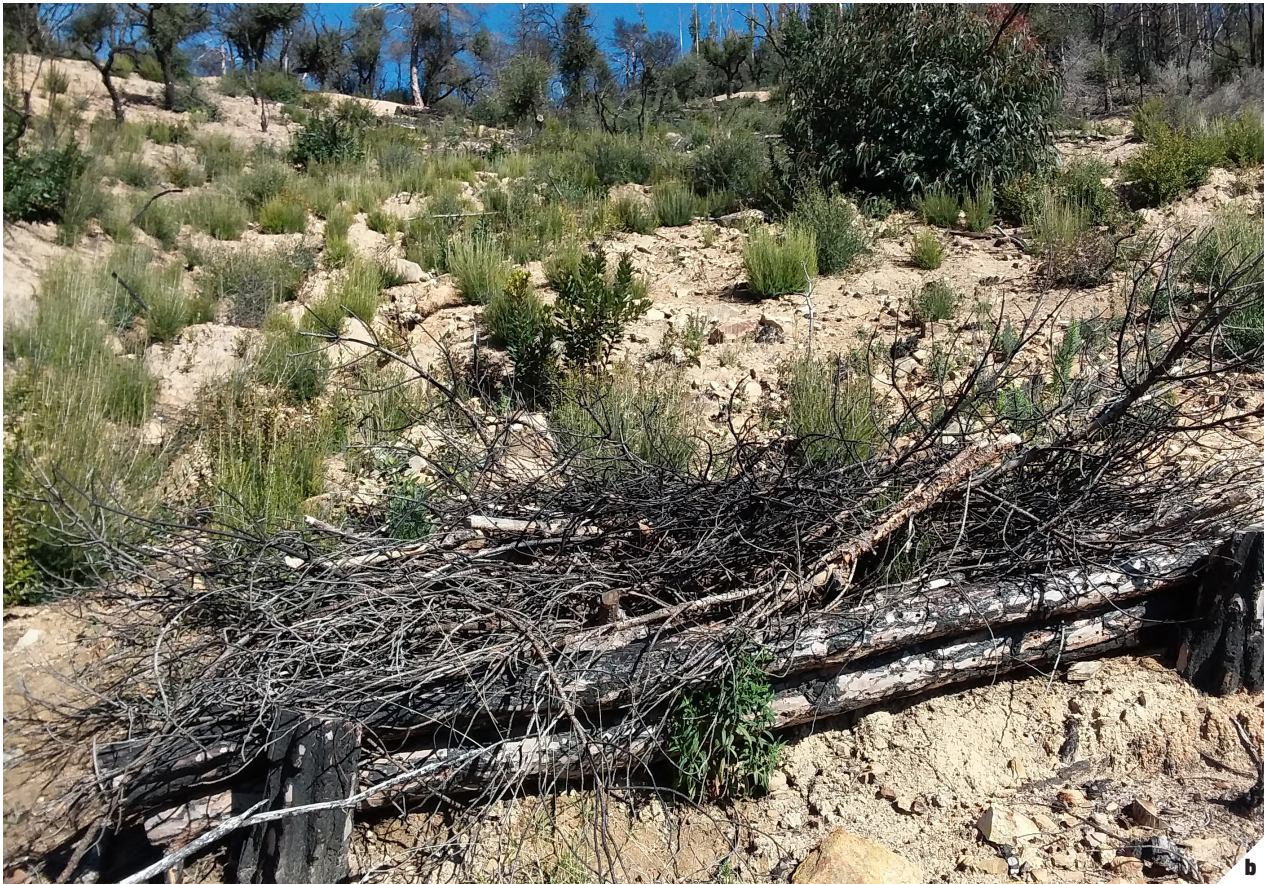
FIGURA 1. Pilsos multifuncionals (antierosió, retenció de biomassa i protecció de la biodiversitat) a les zones de pendent, el maig de 2017 (a) i el febrer de 2018 (b), en una pineda de pi pinyer amb alzines sureres incendiada el juliol de 2016. Imatges: P. Pons.
