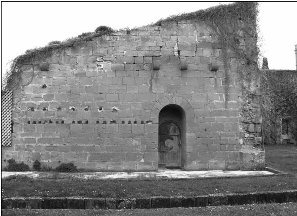
Figura 4. Vista exterior del testero septentrional de la sala de monjes.
