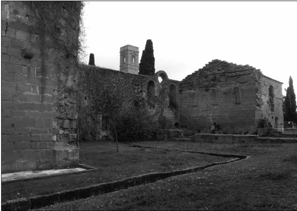
Figura 6. Canalización hidráulica del monasterio. Giro de 90° en la panda claustral del rectorio.
