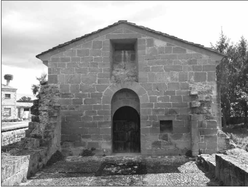
Figura 1. Fachada occidental de la capilla de San Jesucristo.
