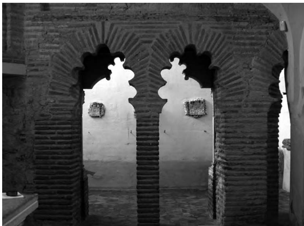
Fig. 2. Muro meridional de la capilla de Asunción, con la puerta original cegada parcialmente al instalarse las trompas occidentales para crear un espacio centralizado (© Patrimonio Nacional).
