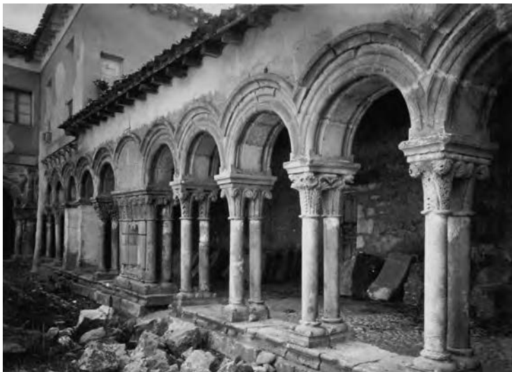
Fig. 7. Fotografía de Jean Laurent (ca. 1872) de la panda sur de las Claustrellas, con los dos pilares que sustituyeron a las columnas originales (Archivo General de Palacio, Madrid. © Patrimonio Nacional).
