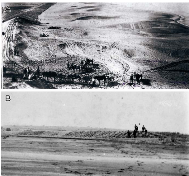
FIGURA 20. Elaboración de la contraduna (A) y trabajos de fijación con borrón (B) cerca de St. Martí d'Empúries en algún momento entre 1896 y 1910. Autor: Josep Esquirol.
