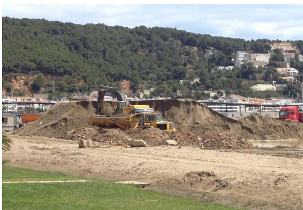
FIGURA 13. Obras de dragado del puerto de l'Estartit en 2015
