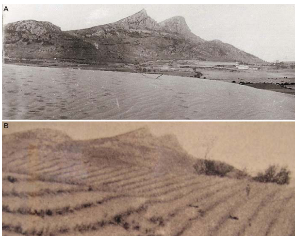
FIGURA 24. Campos dunares de la vertiente sur del Montgrí antes (A) y después (B) de los trabajos de fijación dunar con borron. Autor y fechas desconocidos.
