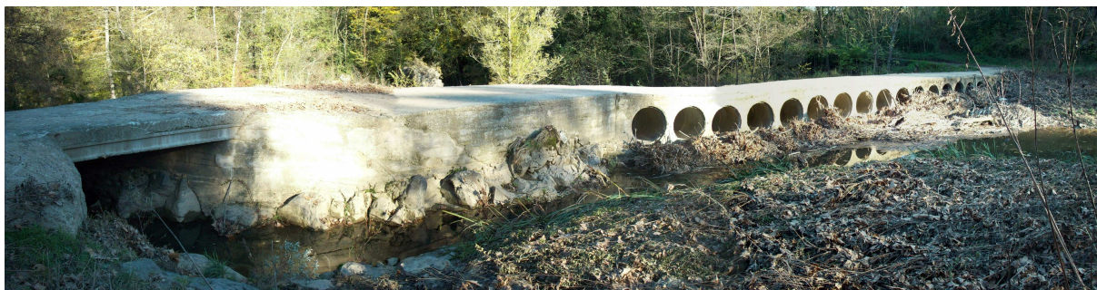
Figura 6.7. Exemple d'infraestructura complexa, constituïda per un pont i un gual.
