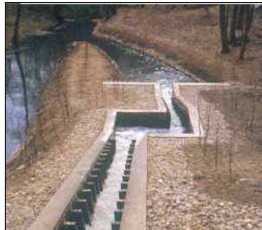
Figura 4.13. Pas de Denil amb dipòsit intermediari. Strom at Prenzlau (Brandenburg). Font: From sea to source,2006.
