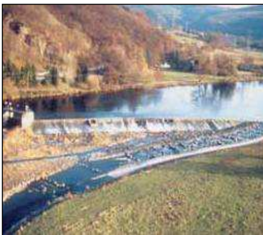
Figura 4.6. Rampa per a peixos sobre el Sieg a Eitorf (Nord del Rin a Westphalia).
