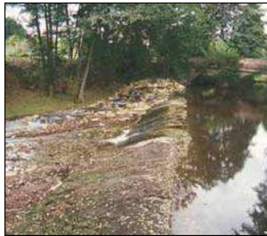
Figura 4.7. Rampa per a peixos en el riu Elz, Baden-Württemberg.
