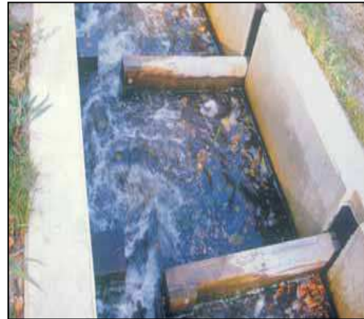
Figura 4.11. Pas de peixos amb obertura vertical. Font: From sea to source ,2006.
