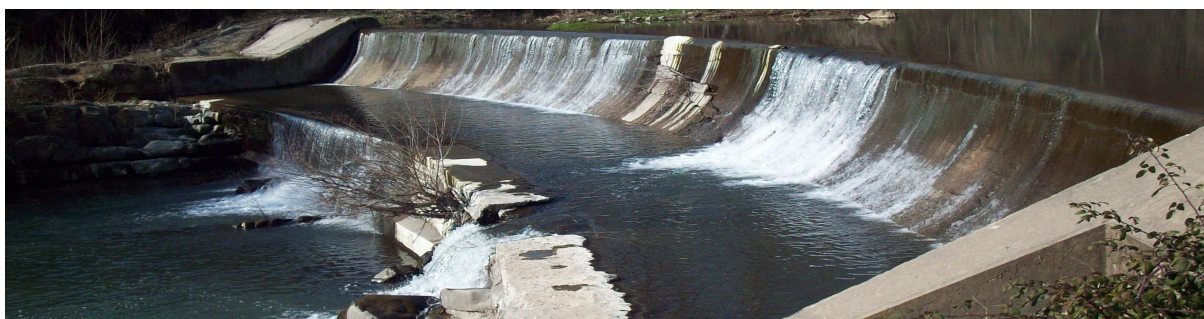
Figura 6.8. Resclosa formada per dos salts entenent com a estructura principal la part superior.
