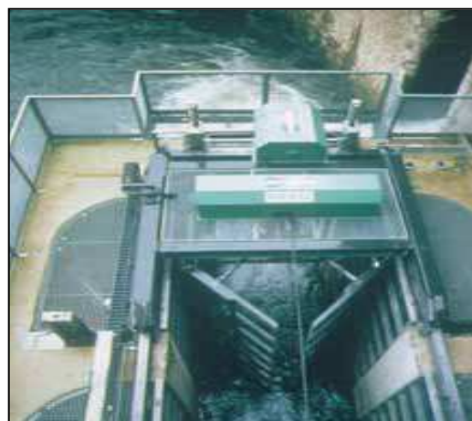
Figura 4.17. Ascensor de peixos de Dordogne (França). Font: From sea to source ,2006.
