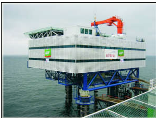
Figura. 4 Subestació elèctrica en alta mar. Font: www.windpower.org
