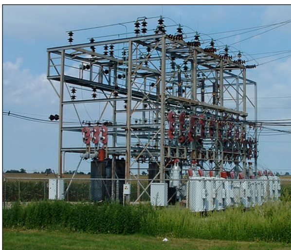
Figura. 20 Subestació elèctrica. Font: www.viquipèdia.com
