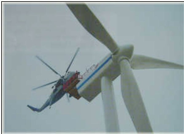
Figura. 5 Manteniment d'un parc eòlic marí. Font: www.windpower.org
