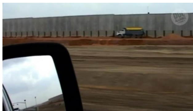
FIG. 5 EL MUR EN CONSTRUCCIÓ EN UN FOTOGRAMA DE ROUTE 181
