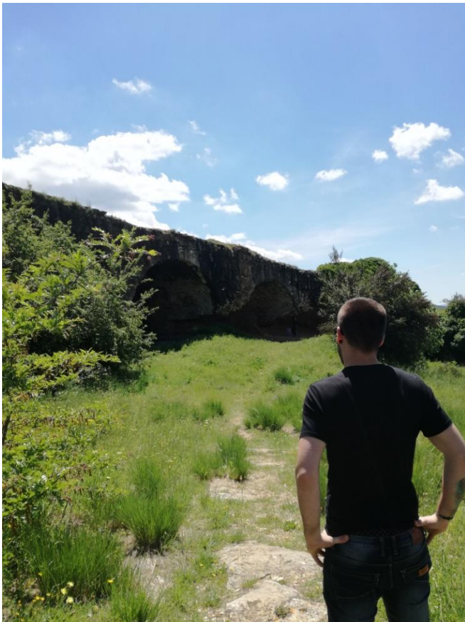
Figura 46. Vista del mur interior ubicat a l'est sense la recreació gràfica. Font: NOGUÉ, J. (2019).
