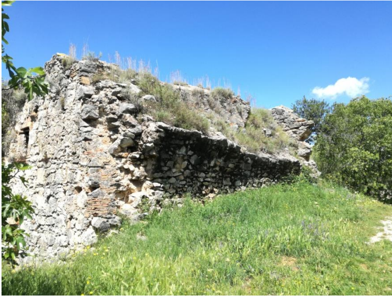
Figura 51. Imatge de l'enderroc de la cortina nord, deixant al descobert la volta. Font: NOGUÉ, J. (2019).
