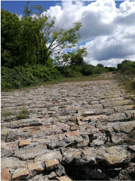
Figura 10. Restes de la teulada construïda per el pare de la Rosario encara visibles a la part superior de la cortina sud. Font: NOGUÉ, J. (2019).
