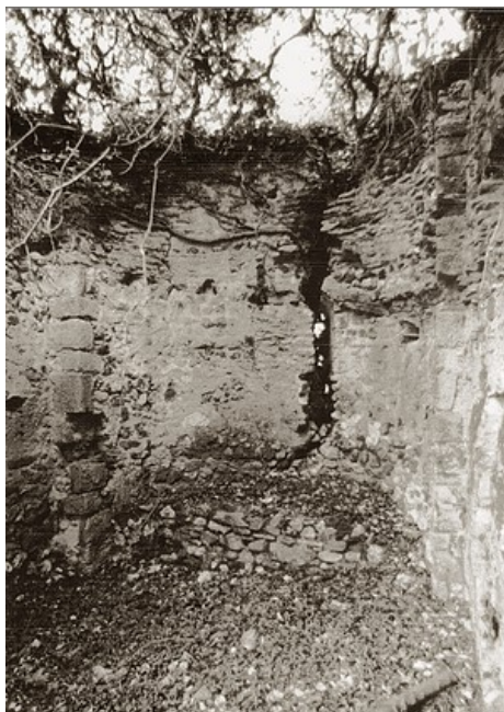
Figura 7. Interior de l'absis de l'ermita. Actualment aquesta esquerra ha estat reparada. Font: Grup de Recerca de Fornells de la Selva, 2015.
