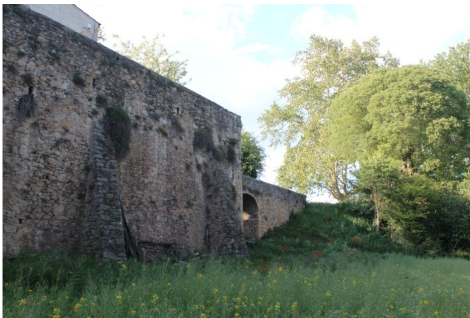
Figura 5. Castell de Fornells de la Selva. Vista des de la part inferior, des d'on veiem el talús i una part del pont. Font: pròpia.
