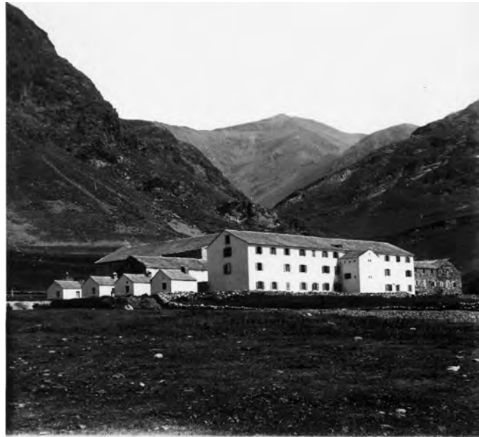
Vista general del conjunt d'edificis que envolten el santuari de Núria, abans de la reforma i ampliació de Josep Danés. Anterior a 1920. (Rafael Masó. AHCOAC-Girona. R. 22978)
