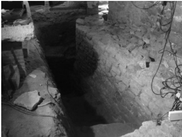
Figura 5. Fotografia de l'àmbit 20 on s'observen les dimensions de la cala i la potència de M-96, a la dreta, i M-104, al nord del sondeig.
