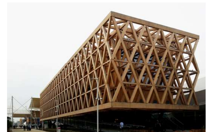
Façana estructural de fusta laminada
