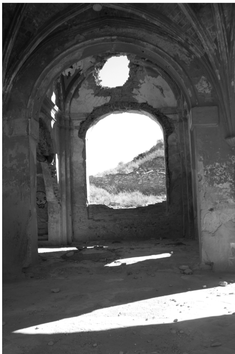
Interior Església de Sant Agutí, Belchite Vell Octubre 2017
