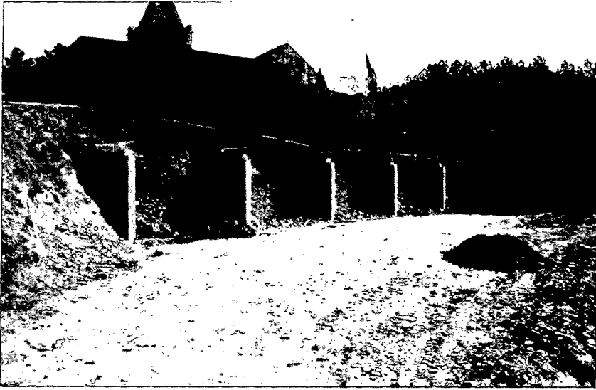
Fig. 1. Vista general de la zona d'excavació. Al fons l'església dels Sants Metges.
