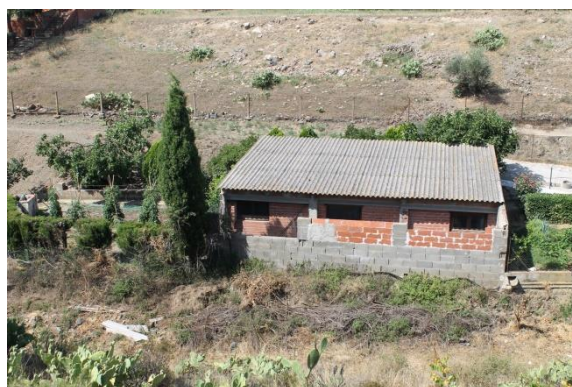
Imatge 7. Parcel·la situada al marge dret del còrrec. S'aprecia la morfologia de l'edificació, totalment residencial. Aquest emplaçament rep un baix perill d'inundació. Font: elaboració pròpia.
