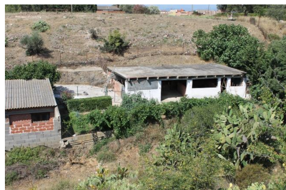
Imatge 5. Parcel·la situada al marge dret del còrrec. Aquest emplaçament rep un baix perill d'inundació. Font: elaboració pròpia.
