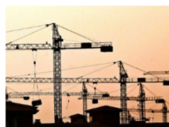
Grúas en una urbanización en construcción en Mallorca. TOLO RAMÓN
