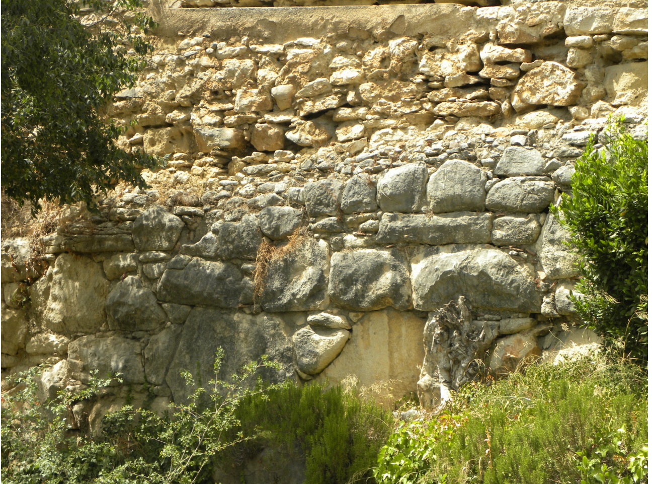
Figura 17: Vista del parament d'opus siliceum que conforma el sòcol de les muralles fundacionals de Gerunda. Font: autor.
