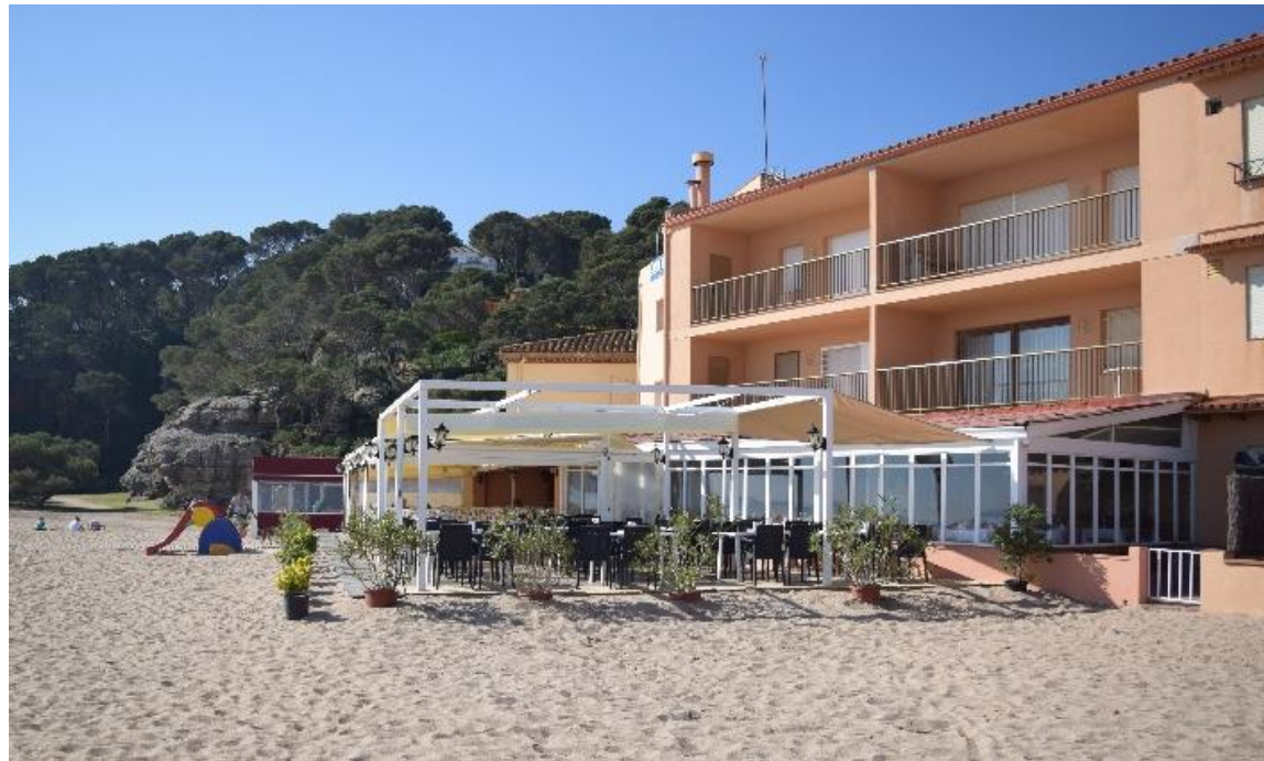
Imatge 3.8.: Terrassa del Restaurant Mar Blau que incompleix la normativa.
