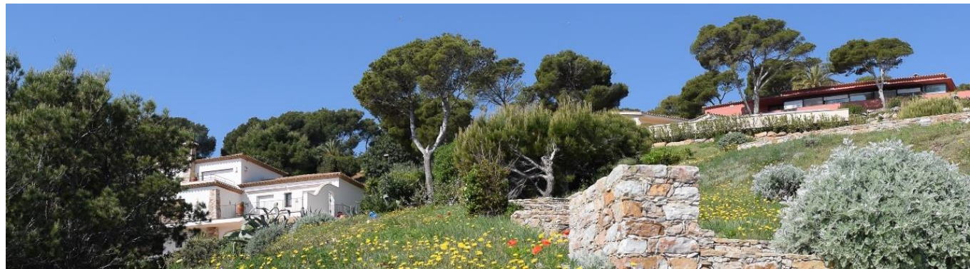
Imatge 3.15.: Els dos habitatges que es veuen des del camí de ronda i que es troben més a prop de la costa incomplint la normativa de no poder haver-hi habitatge en la servitud de protecció.
