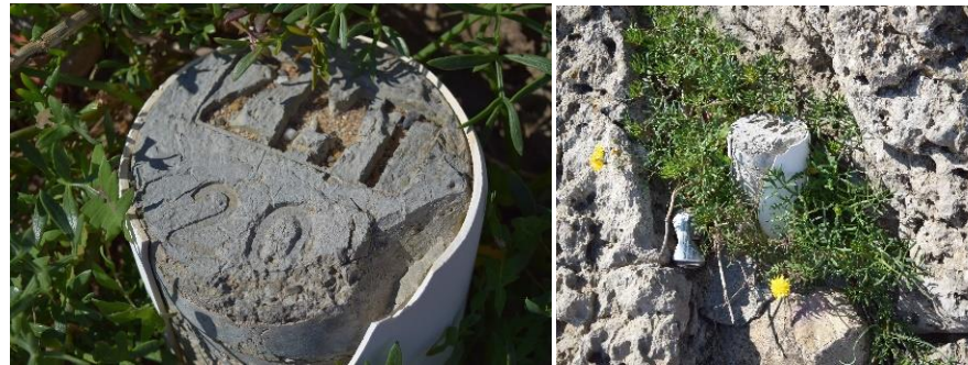
Imatge 3.9. i 3.10.: Estat actual de les pilones del DPMT.
