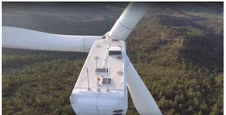
Il·lustració 21- Inspecció d'un molí d'energia eòlica. Font pròpia.
