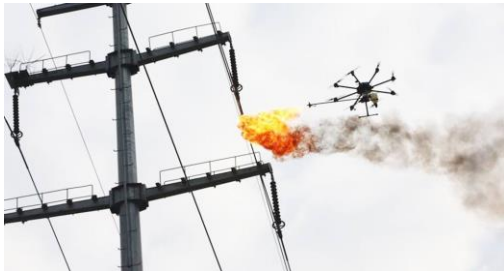
Il·lustració 14- Dron que s'utilitza per la neteja de torres elèctriques. Font: https://i0.wp.com/conectica.com/wp-content/uploads/2017/02/drone-que-escupen-fuego.jpg?fit=1010%2C537&ssl=
