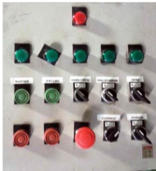
Fotografía 6: Botonera armario principal
