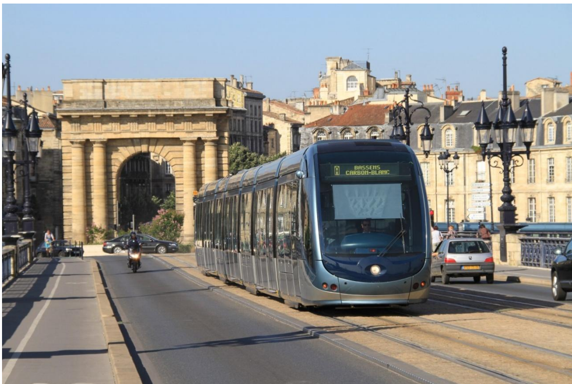
Figura 4.4. Tramvia de Bordeus de l'empresa Alstom, on s'observa que la via consta de 3 rails.
