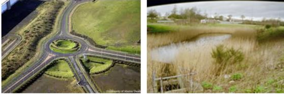
Figura 1.14 Exemple de dipòsit i estany de retenció, respectivament. Font: http://drenajesostenible.com/referencias .
