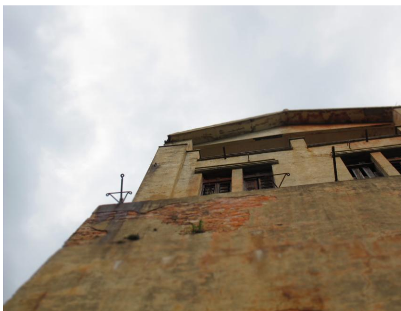
Imatge 31: Vista frontal de l'edifici, on es poden apreciar els ganxos que sostenien les xarxes de camuflatge (2016). Font: Elaboració pròpia
