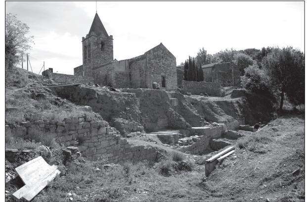
Figura 4. Aspecte del sector de l'antic cementiri parroquial i l'esplanada situada a ponent un cop sanejada durant la campanya de 2015.
