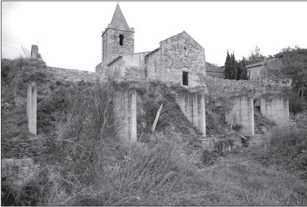
Figura 3. Aspecte del sector de l'antic cementiri parroquial i l'esplanada situada a ponent just abans d'iniciar l'eliminació dels pilars de formigó construïts el 1993.
