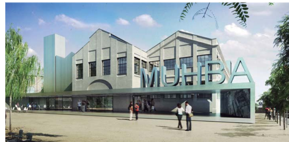
FÀBRICA OLIVA ARTÉS _BAAS Arquitectes Rehabilitació de la antiga fàbrica per convertir-la en la nova seu del MUHBA (Museu d'Història de Barcelona). Utilització d'un únic i nou material per diferenciar la nova intervenció.
