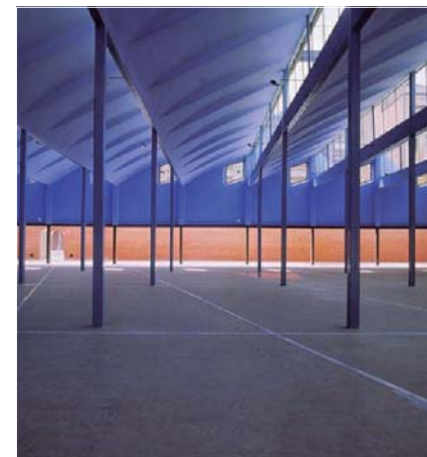
TALLERS MANYACHS _Jaume Bach Rehabilitació d'una obra de Josep Maria Jujol. Intervenció en la peça de coberta en serra, tractada com a espai lliure exterior.
