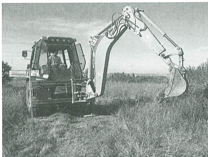
Figura 3. Realització de la cala C-1
