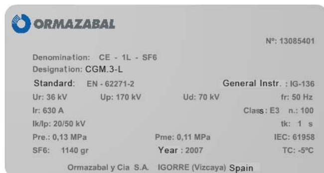
Figura 1.22: Detalle de placa de características en celda cgm.3-l
