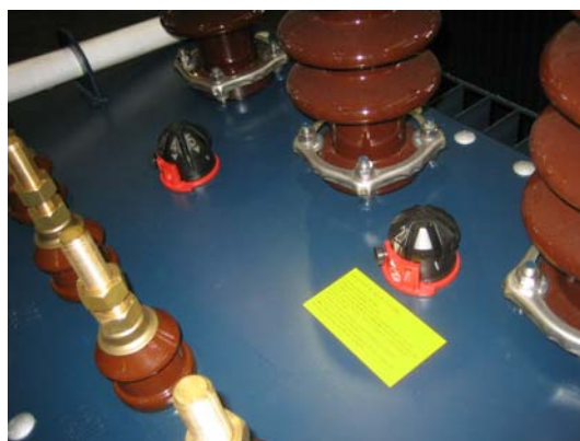
Figura 5.1: Detalle de conmutador en transformador
