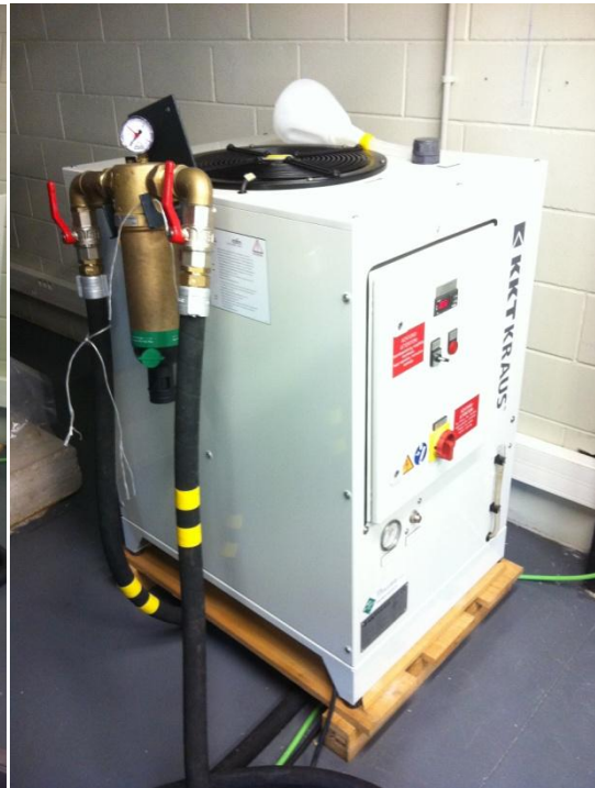
Figura 13: Sistema de refrigeració
