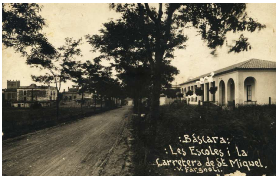
A la dreta observem l' Escola recent construïda, als anys trenta, en la ubicació actual (actualment Av. Alt Empordà,41).
