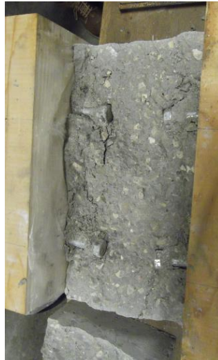
Il·lustració 5.4. Interpretació falla formigó PT4.02
