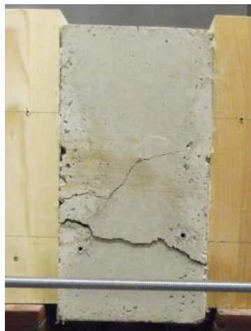
Il·lustració 5.40. Interpretació falla formigó PT1.03
