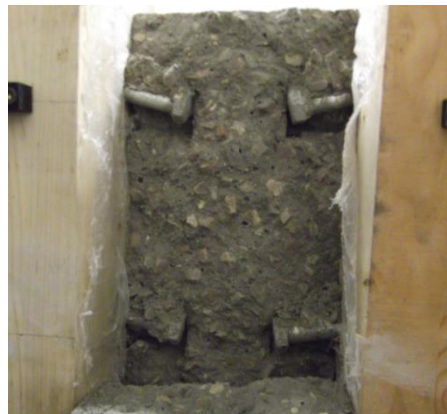
Il·lustració 5.1. Interpretació falla formigó PT4.01
