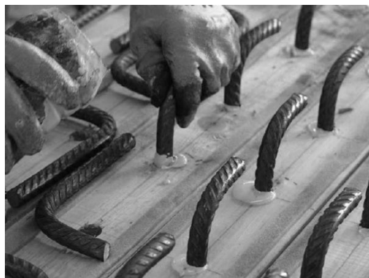
Il·lustració 3.23. Representació col·locació de barra d'acer corrugada
