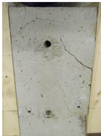
Il·lustració 5.36. Interpretació falla formigó PT1.02
