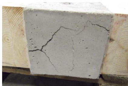
Il·lustració 5.7. Interpretació falla formigó PT4.03
