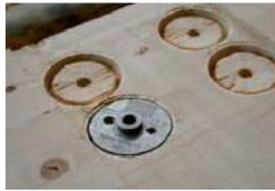
Il·lustració 3.26. Representació col·locació de connector de placa
