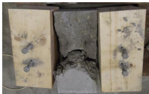
II-lustració 5.24. Interpretació falla formigó PT2.01
