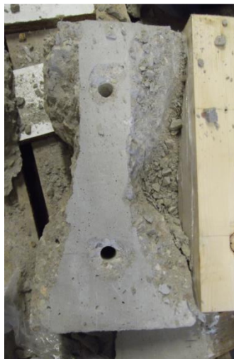
Il·lustració 5.35. Interpretació falla formigó PT1.01
