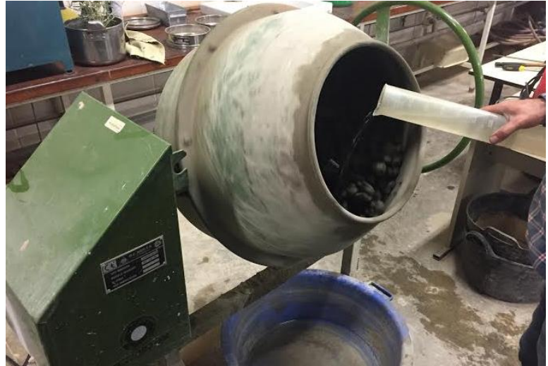
Il·lustració 4.88. Preparació del formigó
