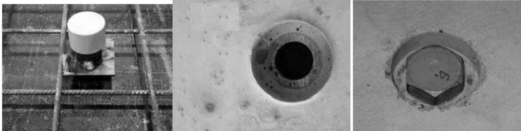
Il·lustració 3.21. Procés de col·locació del tirafons dins tub metàl·lic
