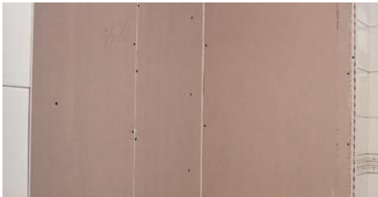
Figura 16: Col·locació dels panells sense massillar
