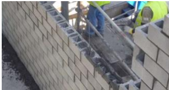
Figura 3: Separació vertical de bloc de formigó ("Pared bloques hormigón," 2009)
