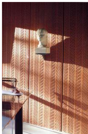
Figura 8: Separació vertical amb panell ceràmic
