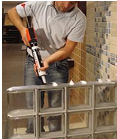
Figura 6: Construcció amb "pavés" (“Tabique con pavés,” 2007)
