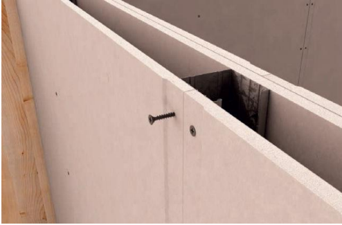
Figura 50: Fixació cartró-guix amb tirafons ("Agarre PLADUR," 2016)
