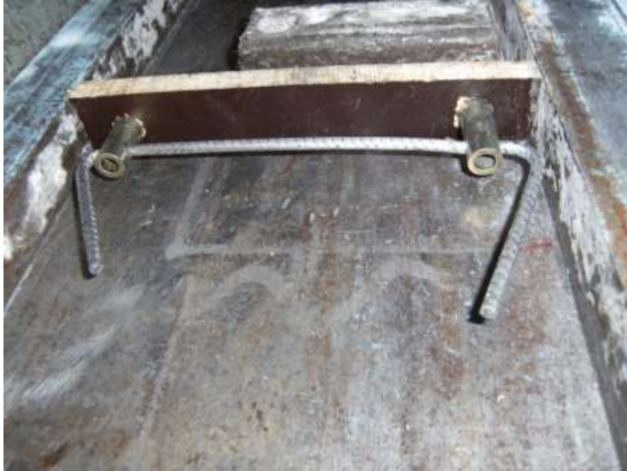
Figura 4.4.2d – Encofrat de les peces de formigó UHPC (vista 4)
