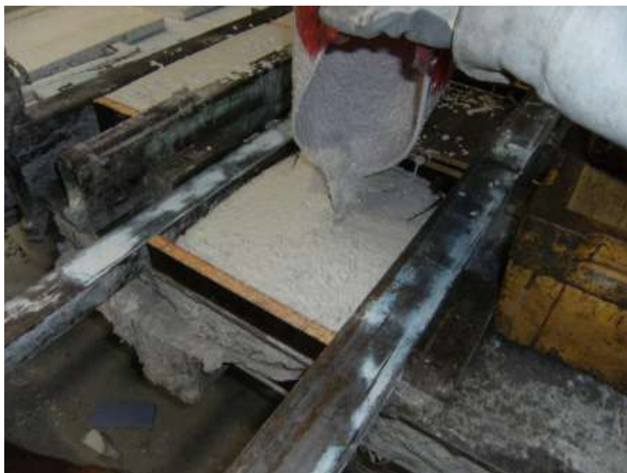
Figura 4.4.2r – Abocat de formigó als encofrats (vista 2)
