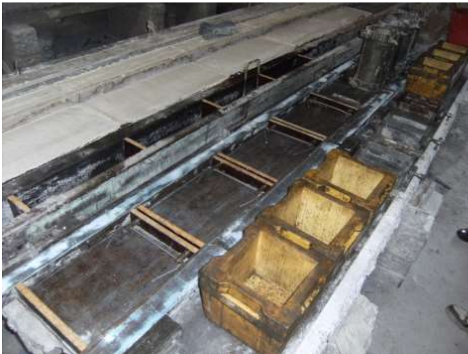
Figura 4.4.2a – Encofrat de les peces de formigó UHPC (vista 1)
