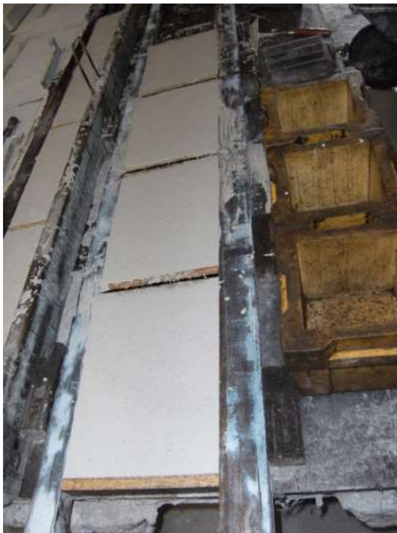
Figura 4.4.2u – Encofrats formigonats (vista 1)
