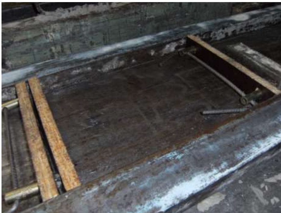
Figura 4.4.2b – Encofrat de les peces de formigó UHPC (vista 2)
