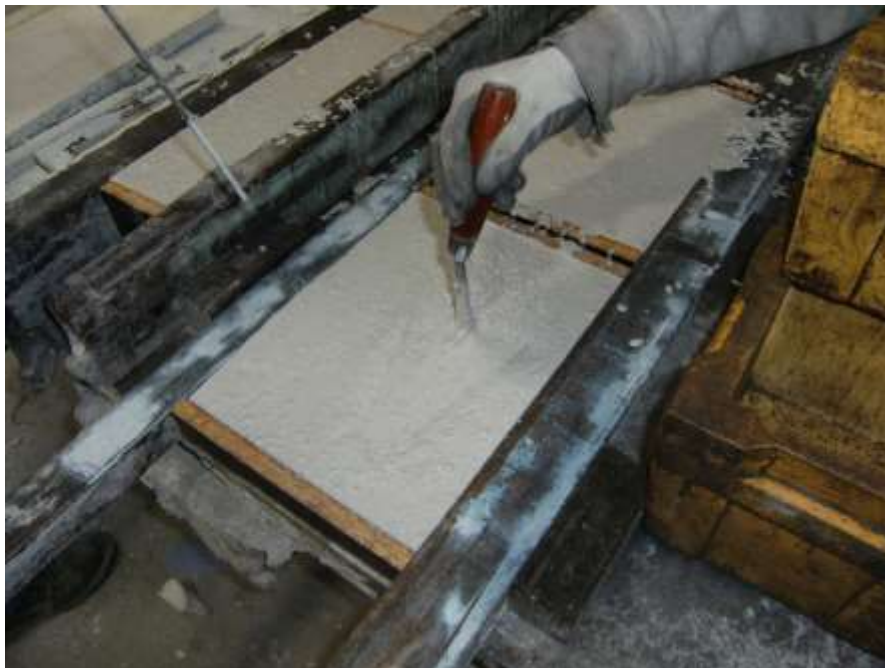
Figura 4.4.2t – Homogeneïtzació del formigó (vista 2)
