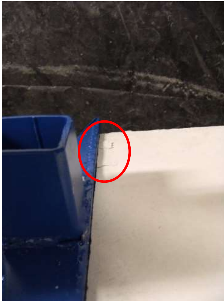
Figura 5.10.3.4a – Fissura laminar (vista 1)
