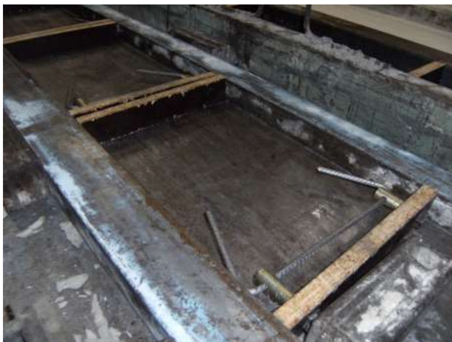
Figura 4.4.2c – Encofrat de les peces de formigó UHPC (vista 3)
