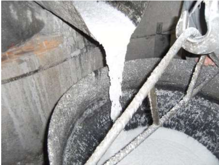
Figura 4.4.2o – Abocat d'amassada definitiva a cubilot (vista 1)
