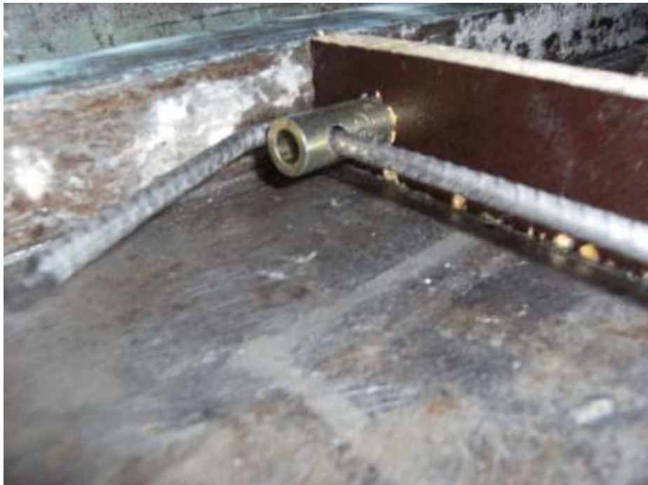
Figura 4.4.2e – Encofrat de les peces de formigó UHPC (vista 5)
