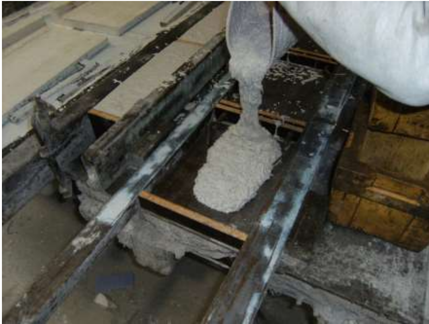
Figura 4.4.2q – Abocat de formigó als encofrats (vista 1)
