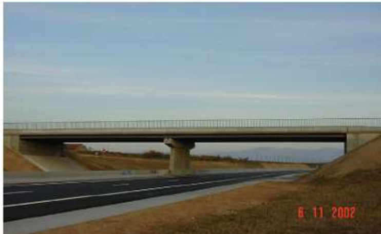
Figura 4.3.3b – Pont executat amb UHPC a Bourg-les-Valence (França)
