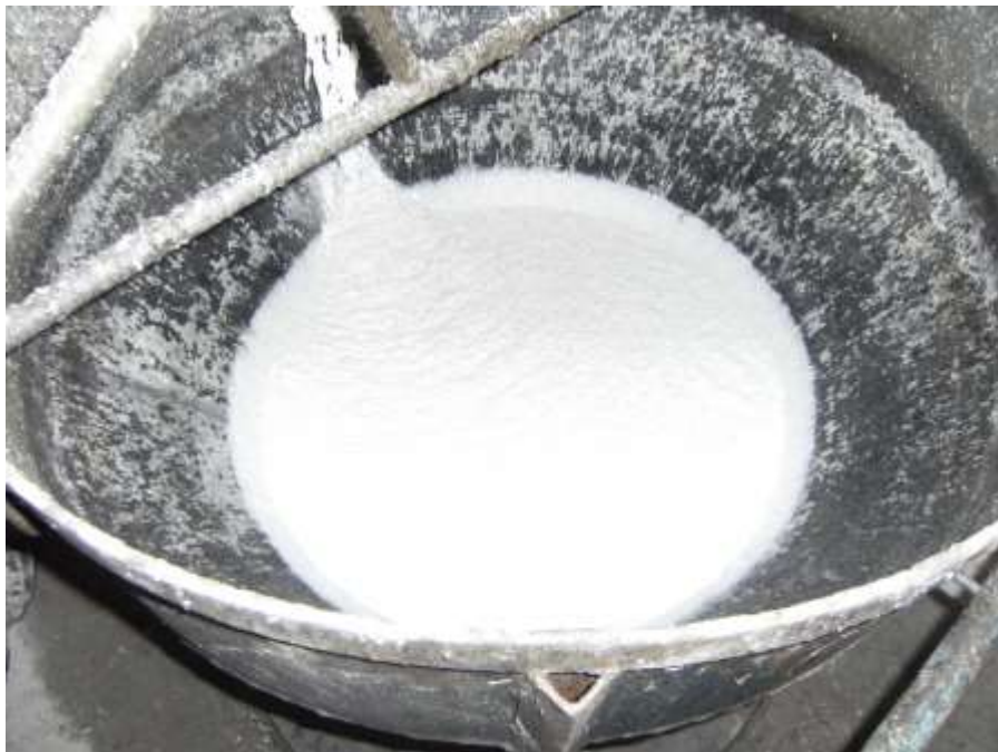
Figura 4.4.2p – Abocat d'amassada definitiva a cubilot (vista 2)
