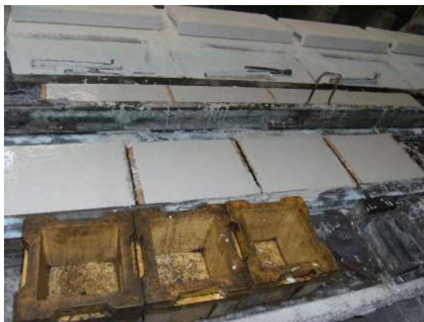
Figura 4.4.2v – Encofrats formigonats (vista 2)
