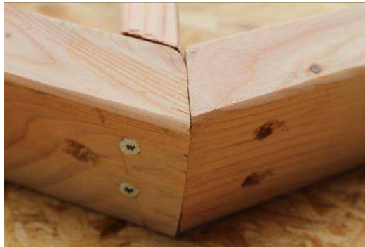
Fixació barra radi figures amb tirafons
