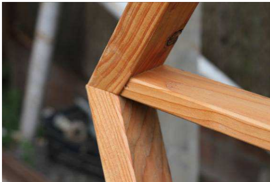
Fixació barra radi figures amb tirafons
