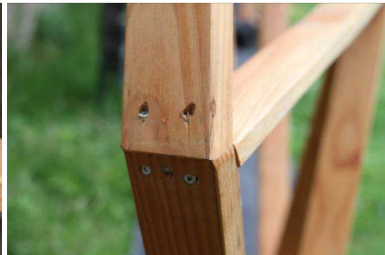
Fixació barra radi figures amb tirafons
