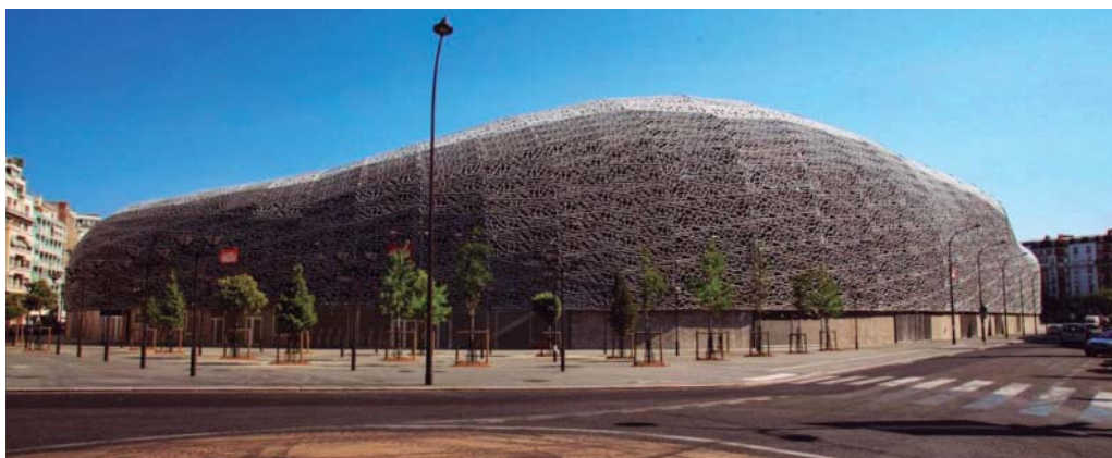
Figura 2-18 Exterior de l'estadi
