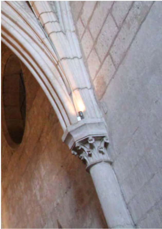
Fig. 557.- Las Huelgas. Iglesia abacial. Detalle del arranque del abovedamiento de uno de los tramos occidentales de la nave meridional, con los nervios diagonales enjarjados con los arcos formeros ciegos
