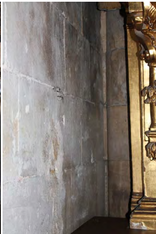
Fig. 359.- Las Huelgas. Iglesia abacial. Detalle de los tambores de la columna de la axila norte del templo, visibles desde la nave septentrional, tras el retablo
