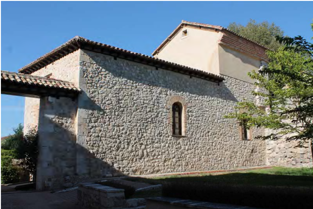
Fig. 868.- Las Huelgas. Capilla de Santiago. Muro meridional, construido con mampostería y sillares en los esquinazos
