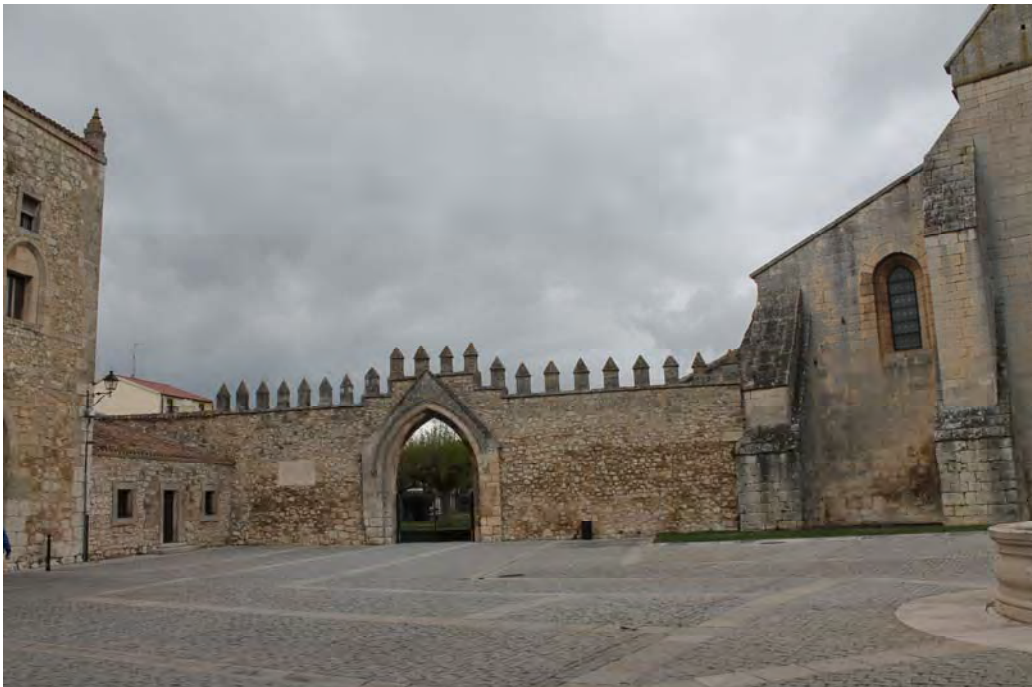
Fig. 752.- Las Huelgas. Muro almenado que separa el compás de adentro del compás de afuera
