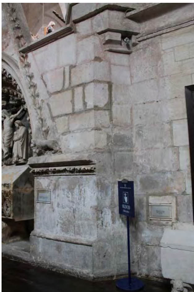
Fig. 565.- Las Huelgas. Iglesia abacial. Unión entre el sepulcro de Fernando de la Cerda y el pilar octogonal adyacente
