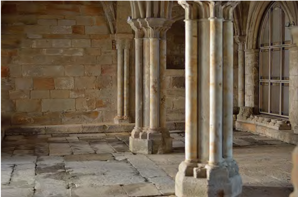
Fig. 658.- Aguilar de Campoo. Monasterio de Santa María la Real. Sala capitular. Detalle de los pilares con columnas en délit
