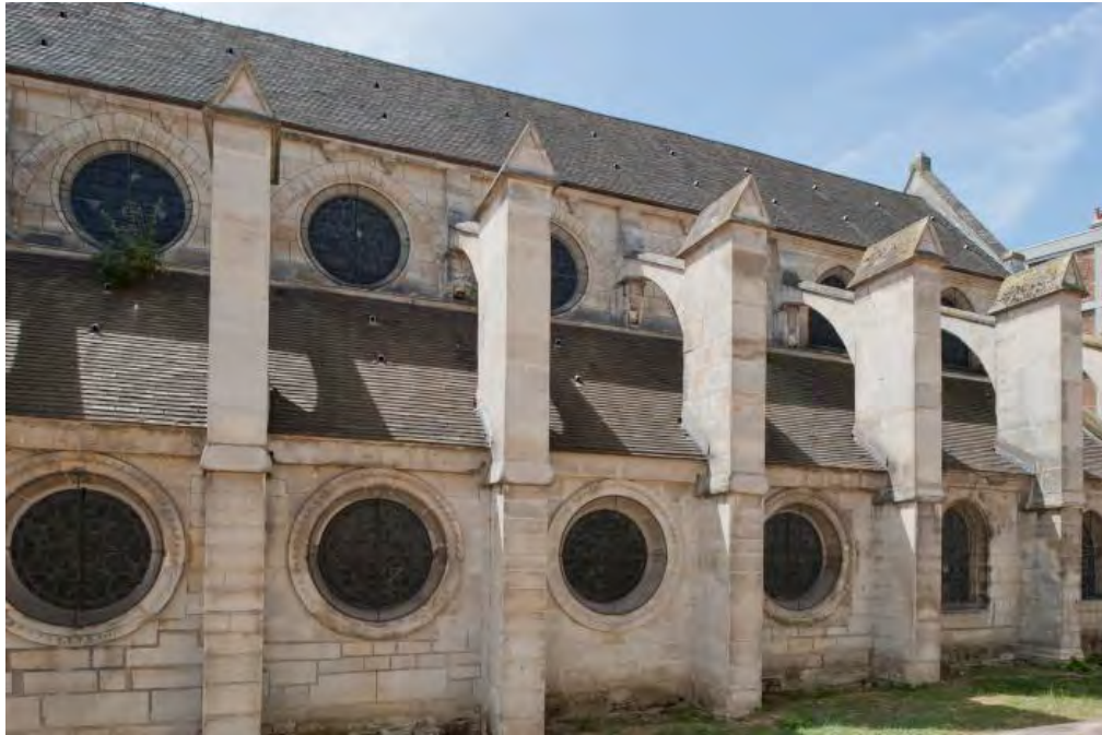
Fig. 457.- Arcueil. Iglesia de Saint-Denis, flanco septentrional
