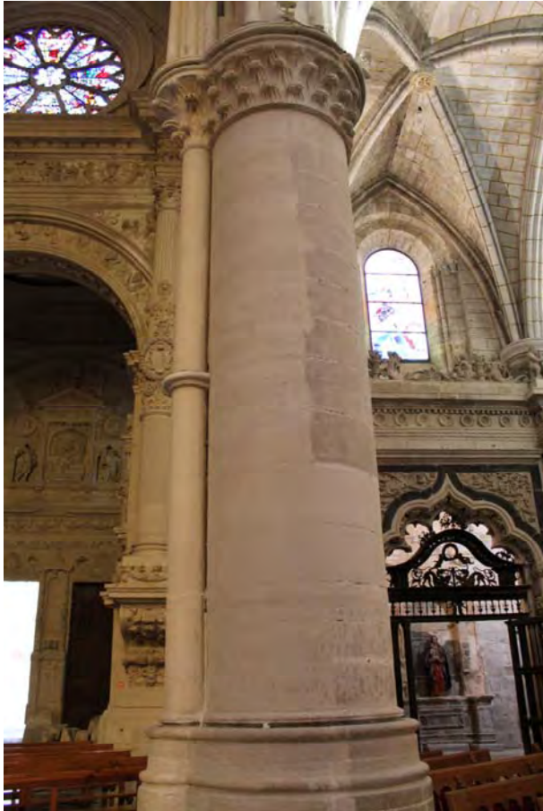
Fig. 481.- Cuenca. Catedral. Pilar de núcleo circular con una sola columna adosada a contralecho, en la embocadura de las capillas laterales de la cabecera
