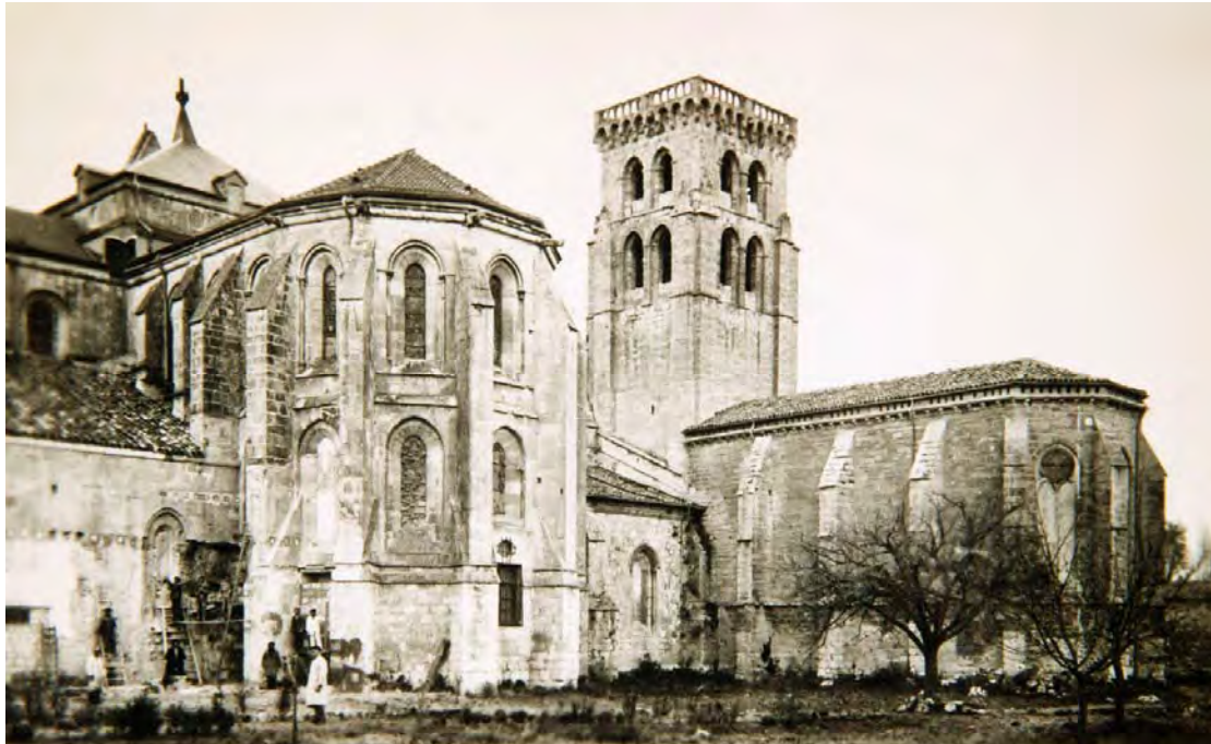
Fig. 214.- Las Huelgas. Iglesia abacial. Fotografía antigua en la que pueden verse los andamios instalados contra el testero de la capilla adyacente a la capilla mayor por el sur y contra los dos primeros paños del arranque del polígono absidal, una vez derribada la estructura adosada a la capilla (© Archivo Municipal de Burgos)
