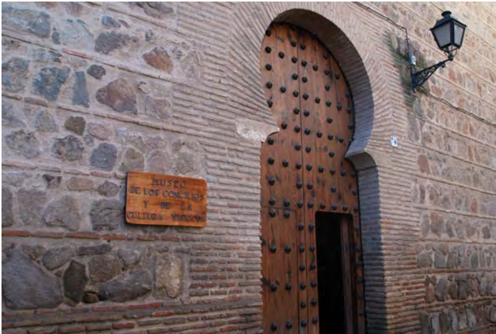
Fig. 85.- Toledo. Iglesia de San Román. Muro construido con cajas de mampostería entre verdugadas de ladrillo
