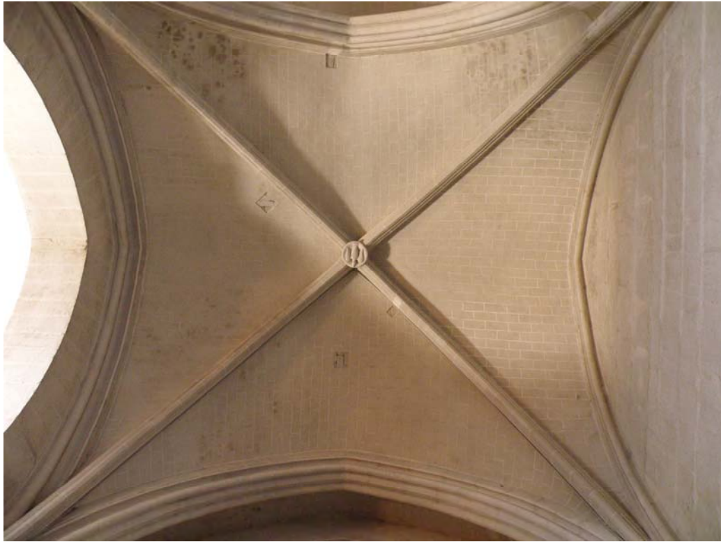
Fig. 373.- Las Huelgas. Iglesia abacial. Una de las bóvedas de la nave sur
