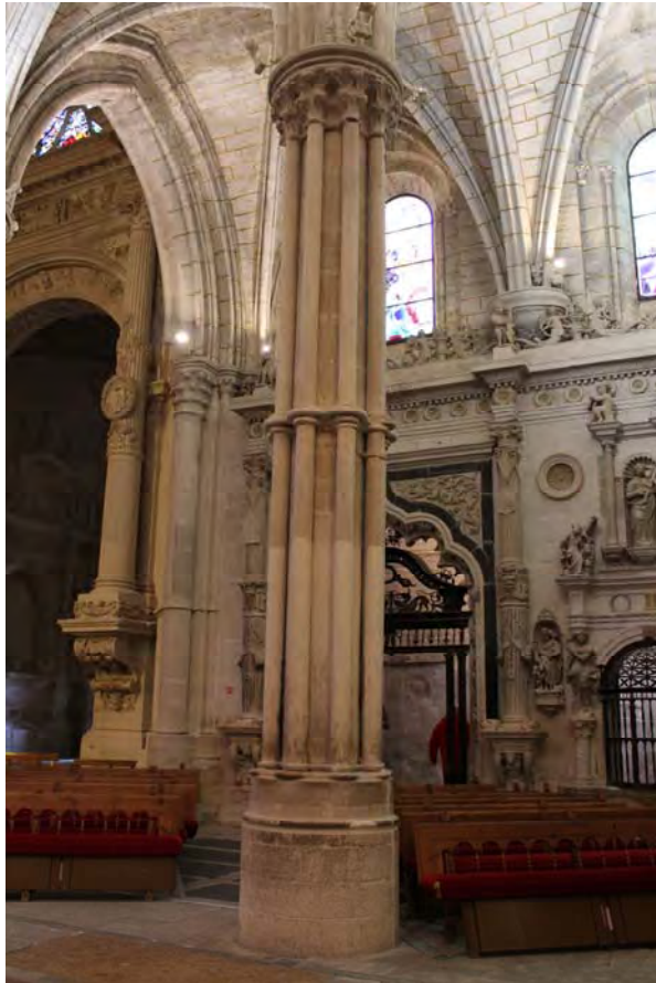
Fig. 479.- Cuenca. Catedral. Pilar que separa cada grupo de dos capillas laterales de la cabecera, de núcleo circular con columnas en délit
