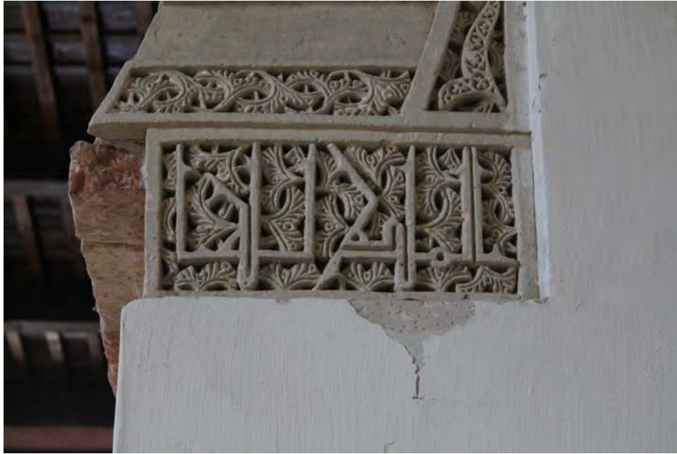
Fig. 880.- Las Huelgas. Capilla de Santiago. Imposta bajo el arranque septentrional de la cara oriental del arco triunfal
