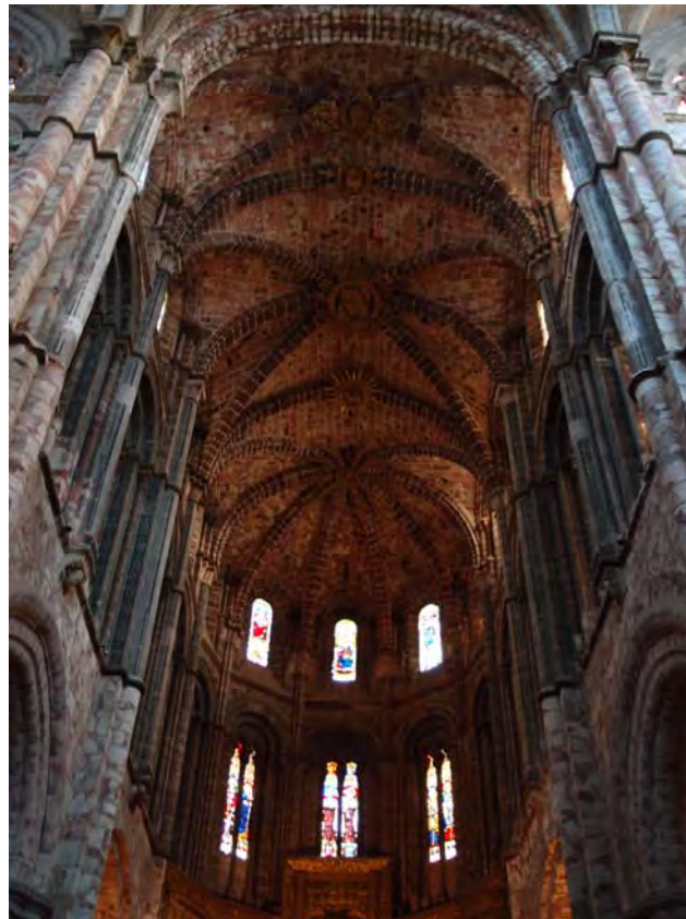
Fig. 492.- Ávila. Catedral. Bóvedas de la capilla mayor, que incluyen un tramo sexpartito
