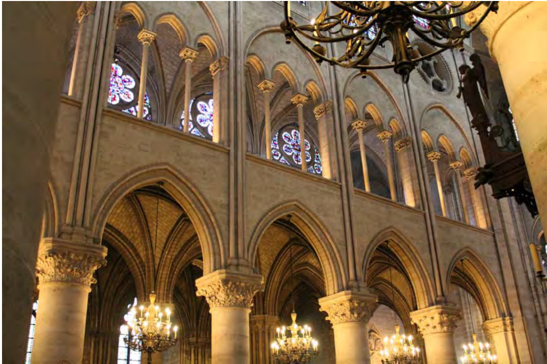
Fig. 469.- París. Catedral. Alzado de la nave central, al oeste del transepto, con haces de tres columnitas en délit
