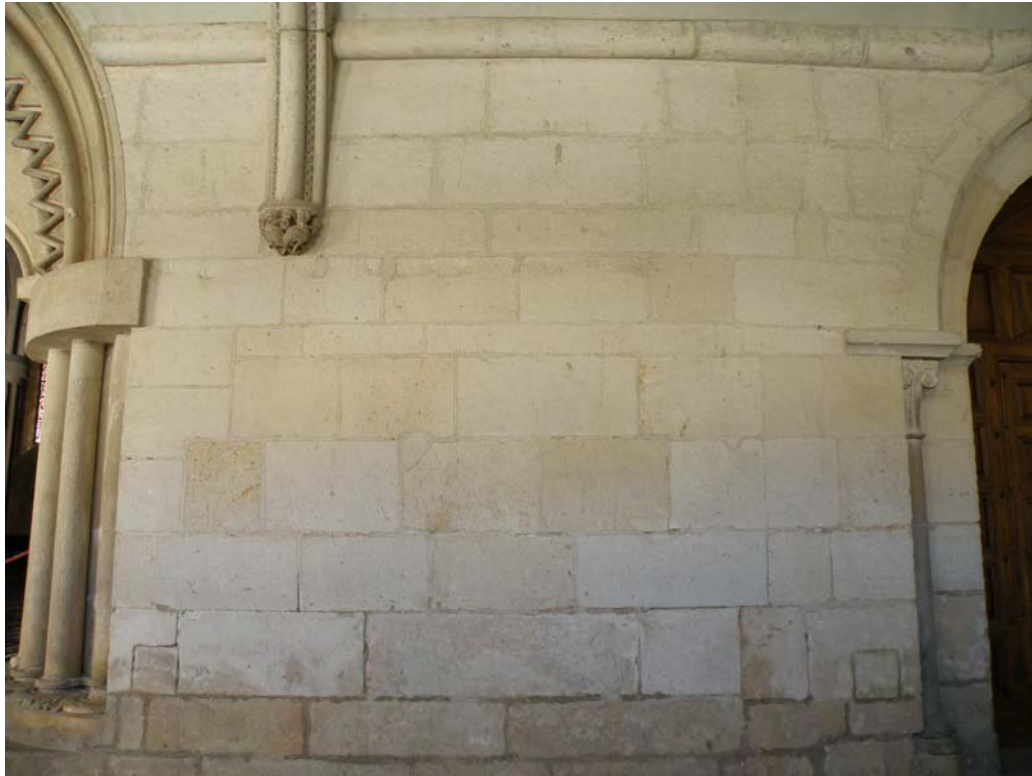
Fig. 747.- Las Huelgas. Claustro de San Fernando. Muro perimetral de la panda este entre la puerta del locutorio (derecha) y la fachada de la sala capitular (izquierda)
