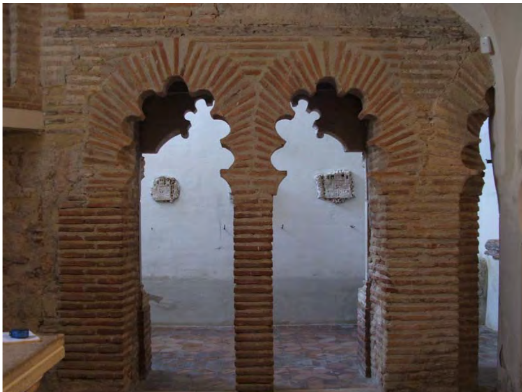
Fig. 131.- Las Huelgas. Capilla de la Asunción. Vanos del muro sur, que comunican la capilla con la estancia que por ese lado se le adosa
