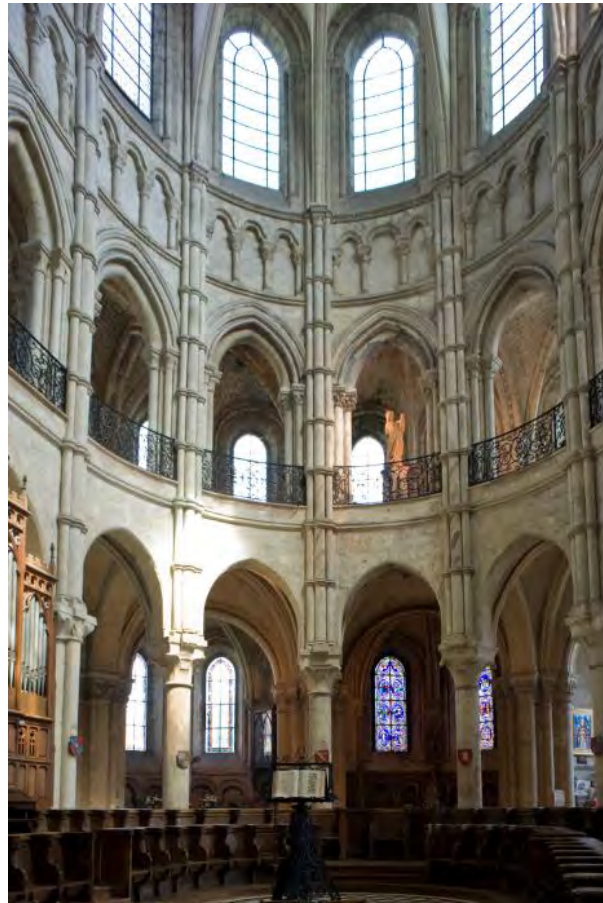
Fig. 472.- Noyon. Catedral. Haces de columnas en délit de la capilla mayor
