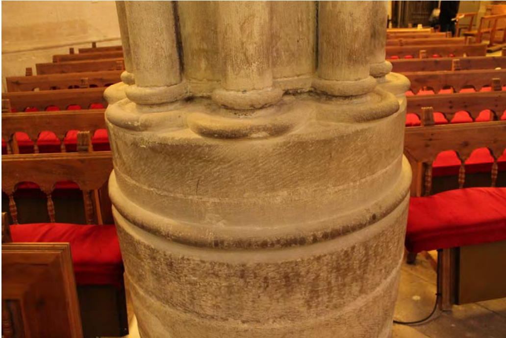
Fig. 657.- Cuenca. Catedral. Basamento de los pilares de núcleo circular con columnas en délit de la cabecera
