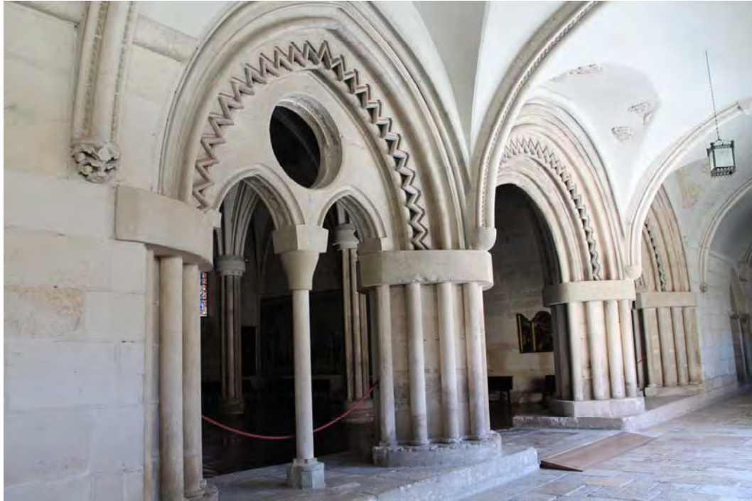
Fig. 589.- Las Huelgas. Claustro de San Fernando. Los tres tramos de la panda oriental que anteceden la fachada de la sala capitular, cuyas bóvedas se aristan en su mitad longitudinal correspondiente al muro perimetral
