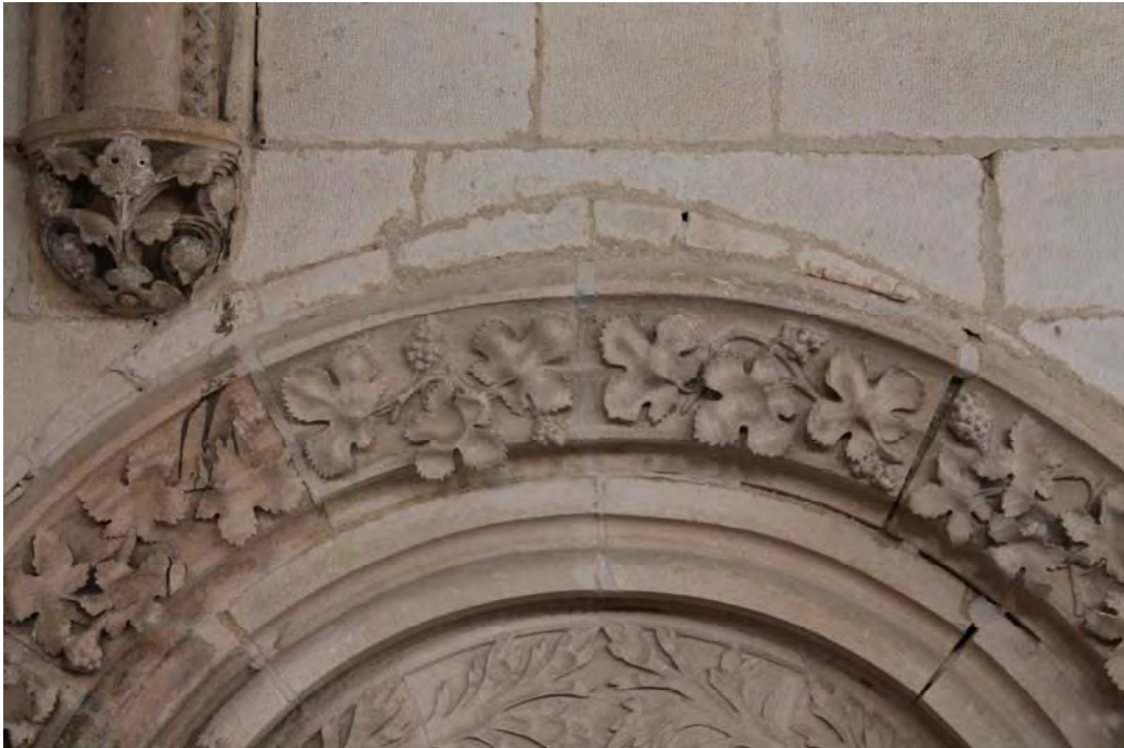
Fig. 644.- Las Huelgas. Sacristía. Detalle de la parte superior del arco de la portada occidental, de comunicación con la panda oriental del claustro de San Fernando, sobre el que pueden verse los restos del arco primitivo
