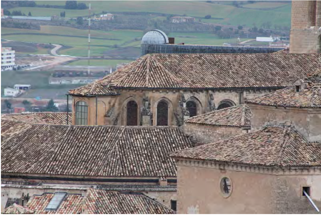
Fig. 517.- Cuenca. Catedral. Vista externa de la cabecera, con los contrafuertes de su capilla mayor
