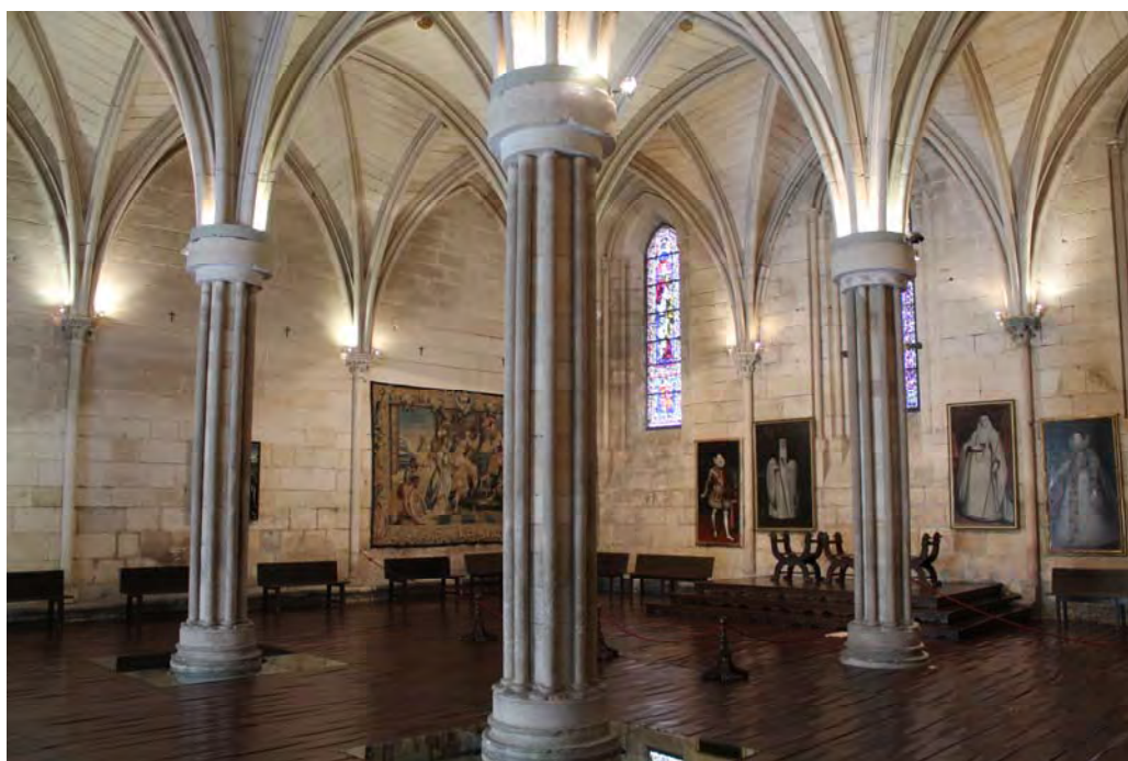
Fig. 671.- Las Huelgas. Sala capitular. Vista general de los muros septentrional y oriental
