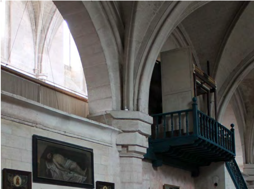
Fig. 356.- Las Huelgas. Iglesia abacial. Detalle de la confluencia, sobre uno de los pilares octogonales de la arcada de la nave norte, de arcos perpiaños y forneros y de nervios de bóveda, que permite comprobar cómo estos últimos cubren la molduración de los forneros, lo que es prueba de que no fueron enjarjados
