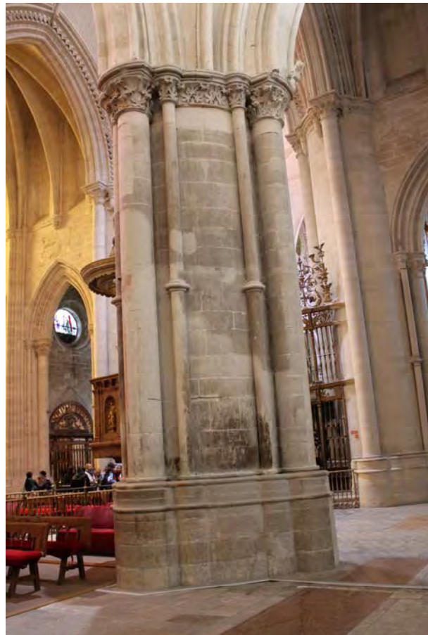
Fig. 482.- Cuenca. Catedral. Uno de los pilares torales, que combina gruesas columnas entregas con columnitas en délit
