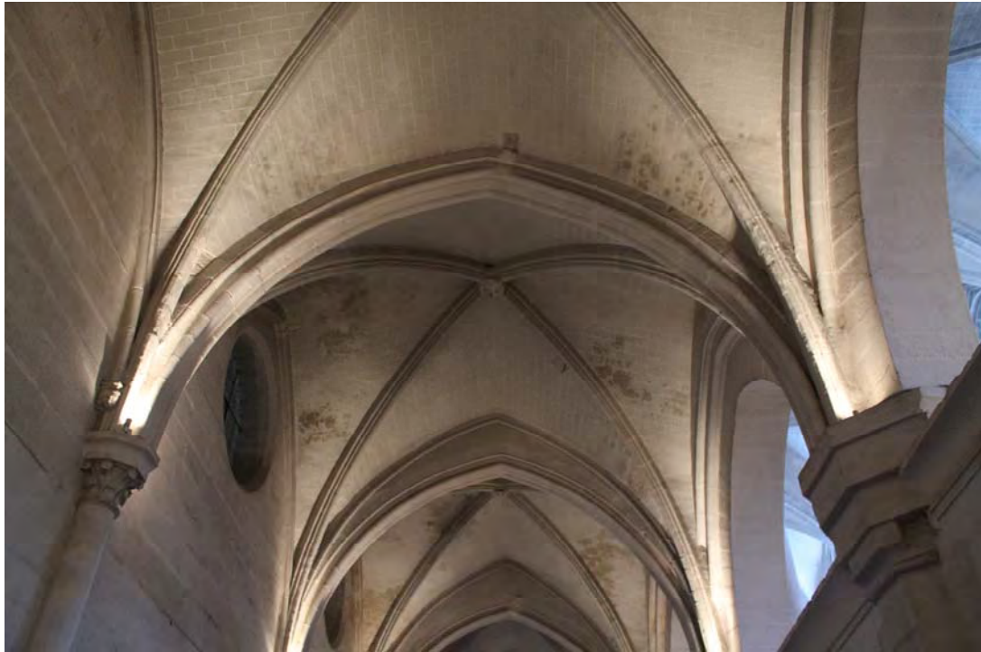
Fig. 389.- Las Huelgas. Iglesia abacial. En primer plano, bóveda de la nave sur que ajusta su altura a la de los arcos perpiaños y, tras ella, bóvedas sobrealzadas
