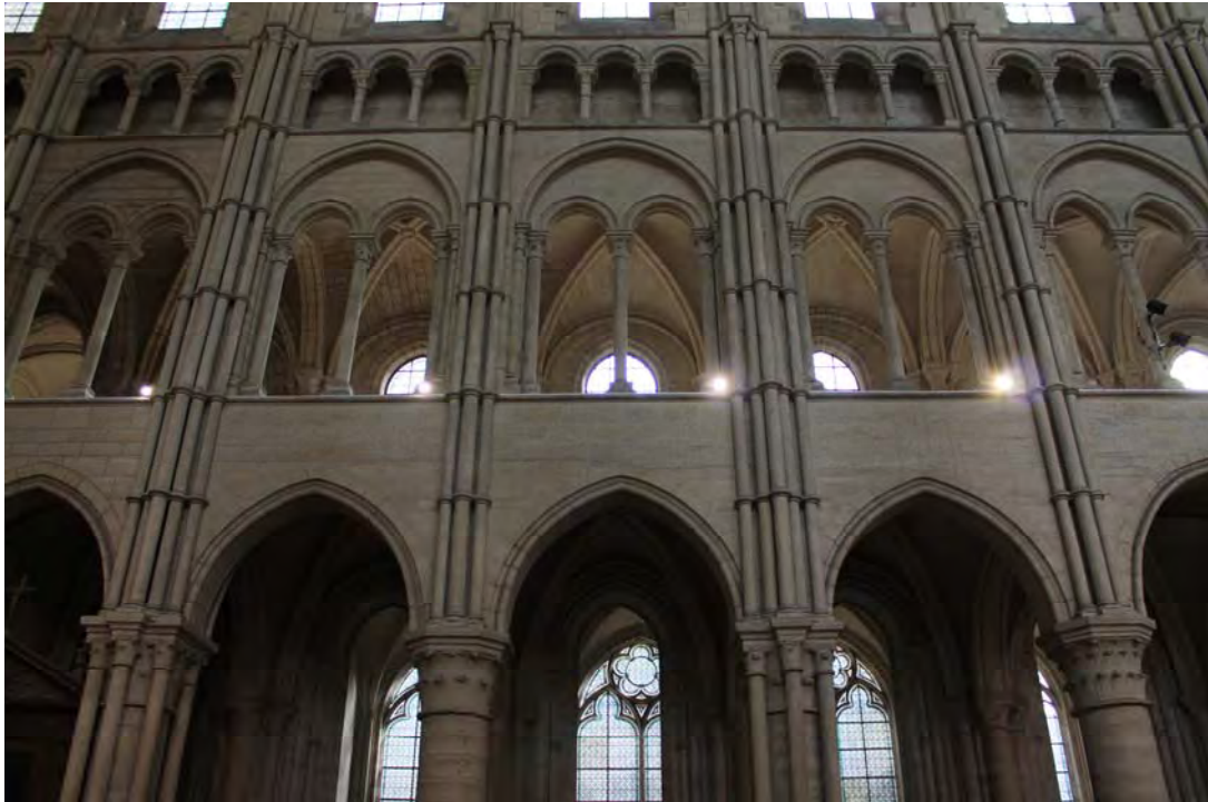
Fig. 470.- Laon. Catedral. Alzado, con haces alternativos de tres y cinco columnas en délit anilladas
