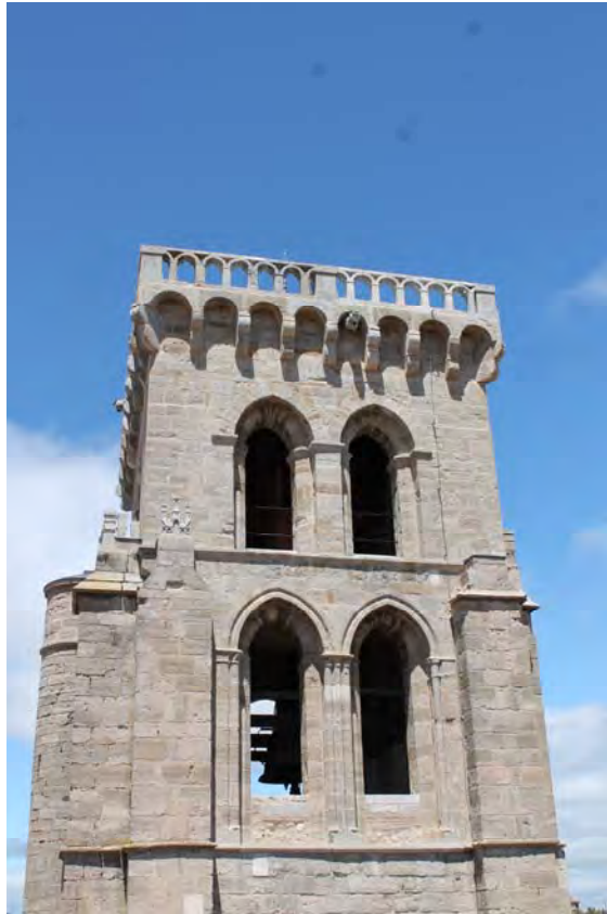
Fig. 844.- Las Huelgas. Torre. Tercio superior del costado occidental
