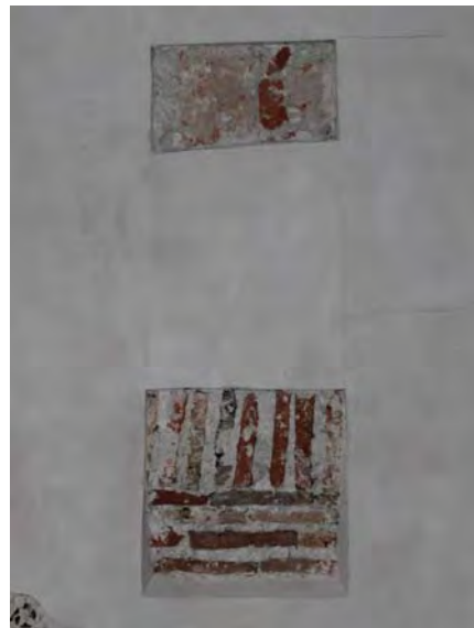
Fig. 594.- Las Huelgas. Claustro de San Fernando. Ladrillo de las bóvedas, visibles tras el enlucido que las cubre
