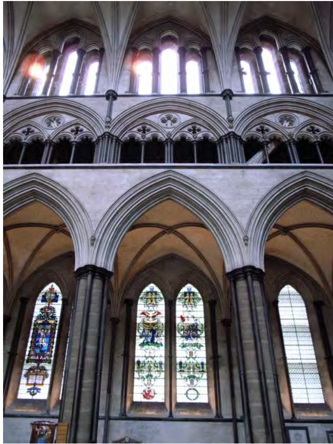
Fig. 427.- Salisbury. Catedral. Alzado de la nave central
