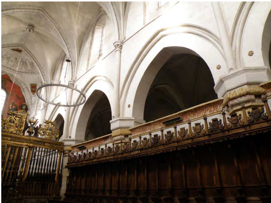
Fig. 301.- Las Huelgas. Iglesia abacial. Arcada meridional de la nave central
