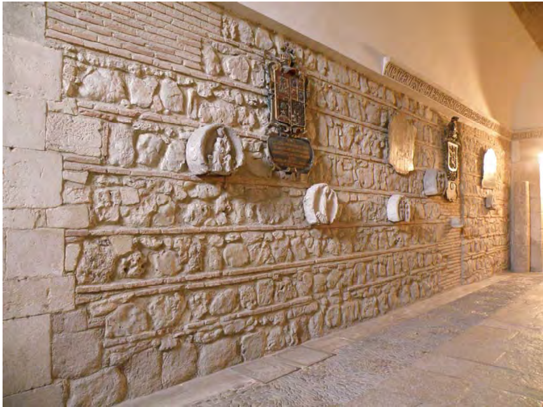
Fig. 695.- Las Huelgas. Pasaje. Aparejo de su muro meridional
