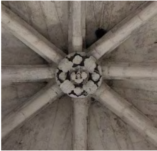
Fig. 252.- Las Huelgas. Iglesia abacial. Detalle de la clave de bóveda del cimborrio
