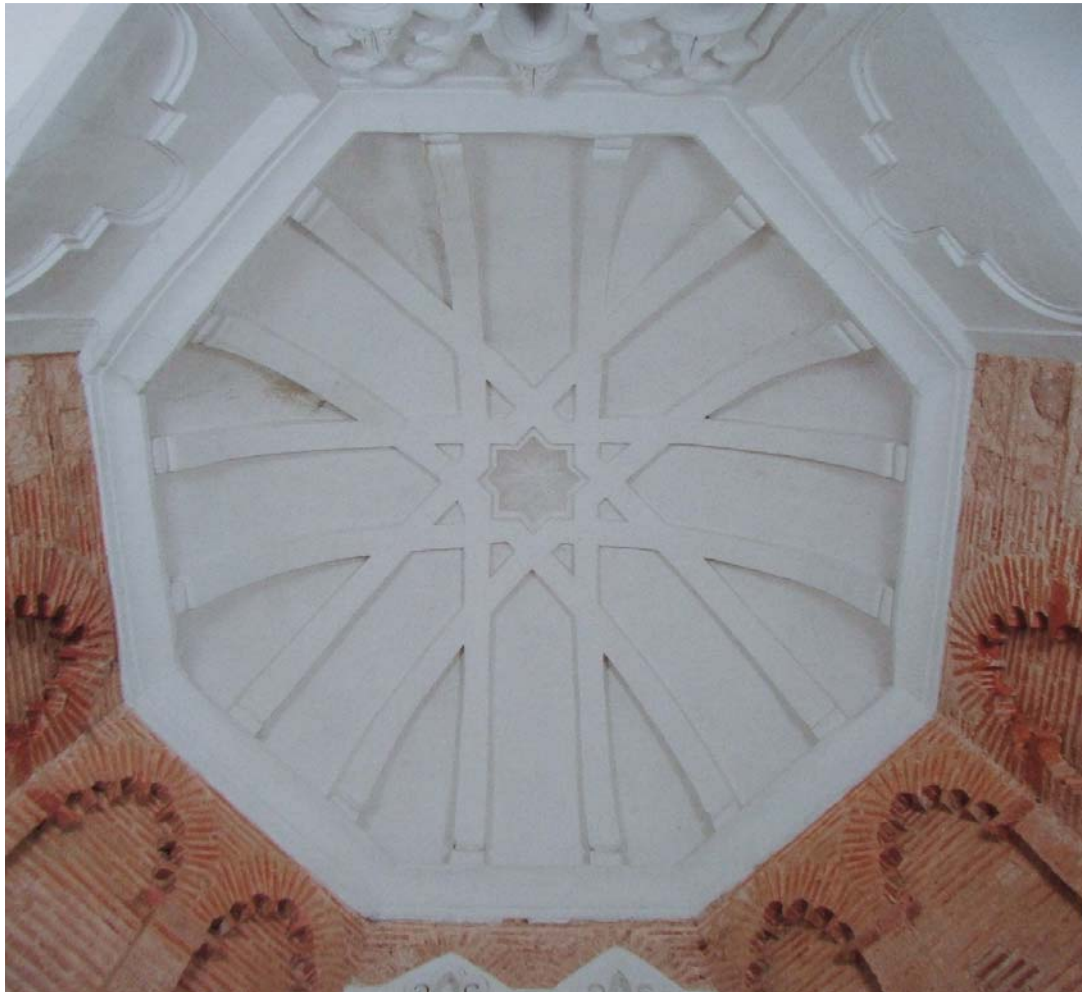
Fig. 106.- Las Huelgas. Capilla de la Asunción. Vista general del espacio del presbiterio , con la cúpula nervada de ladrillo que lo cubre
