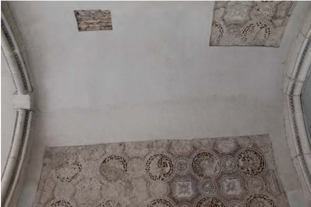
Fig. 610.- Las Huelgas. Claustro de San Fernando. Yeserías del cuarto tramo (desde el este) de la panda meridional
