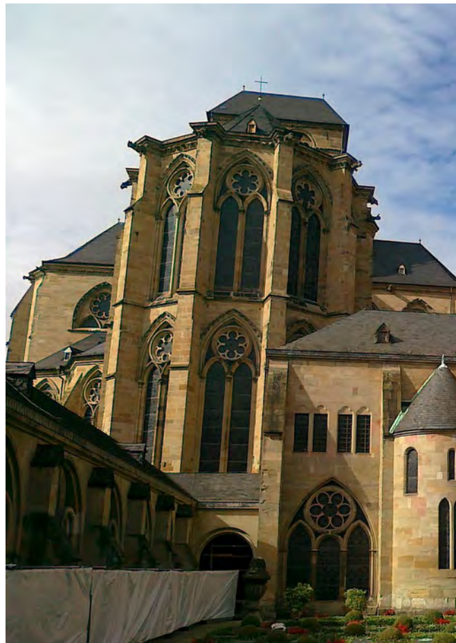
Fig. 432.- Trier. Liebfrauenkirche. Exterior de la cabecera
