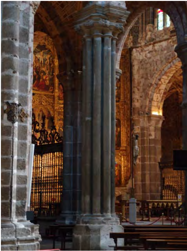
Fig. 477.- Ávila. Catedral. Pilar con columnas en délit que divide la embocadura septentrional de la doble girola
