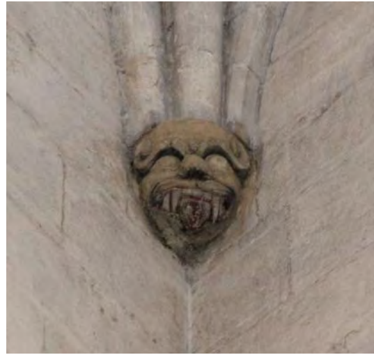
Fig. 253.- Las Huelgas. Iglesia abacial. Una de las ménsulas de las que nacen los nervios de la bóveda del cimborrio
