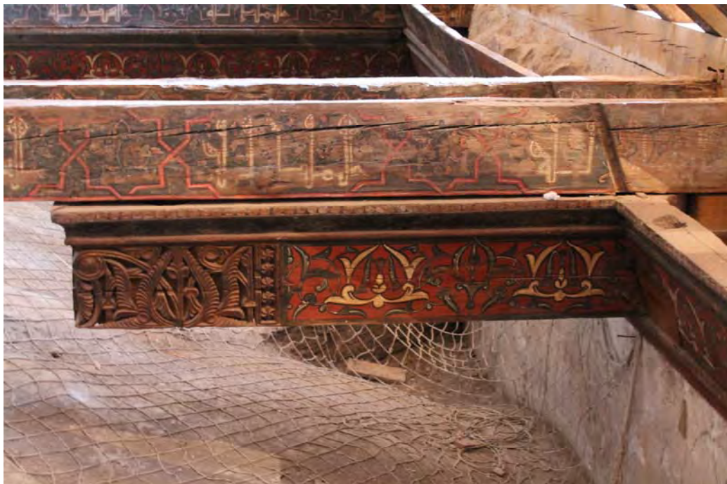
Fig. 712.- Las Huelgas. Refectorio. Detalle de la decoración escultórica de la cubierta, centrada en los cabezales de los durmientes
