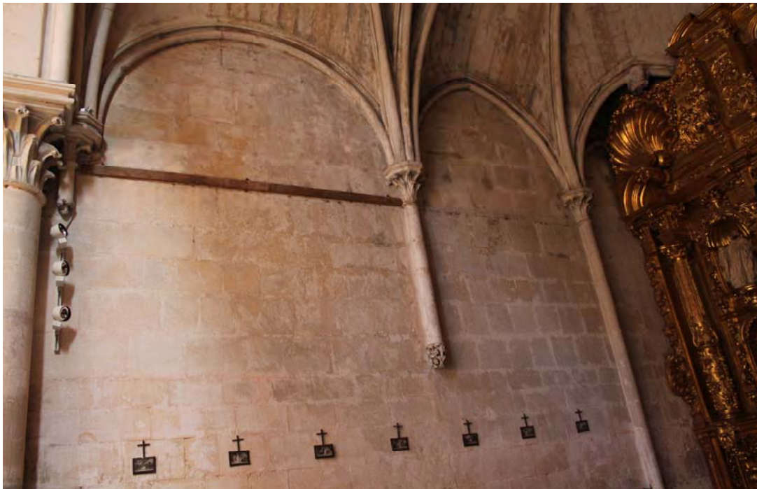
Fig. 228.- Las Huelgas. Iglesia abacial. Muro septentrional de la capilla norte del bloque meridional de capillas laterales: columna oriental que descende hasta el suelo y columna occidental acabada en cul-de-lampe
