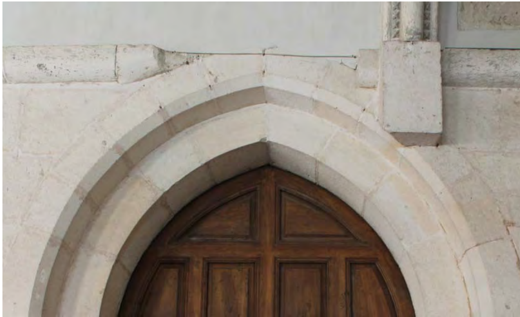
Fig. 593.- Las Huelgas. Claustro de San Fernando. Interrupción de la imposta de los muros perimetrales a la altura de la portada del locutorio
