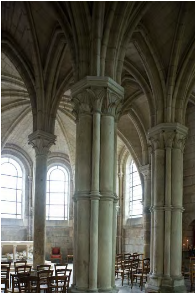
Fig. 473.- Soissons. Catedral. Pilares con columnas en délit de la entrada a la capilla del brazo sur del transepto
