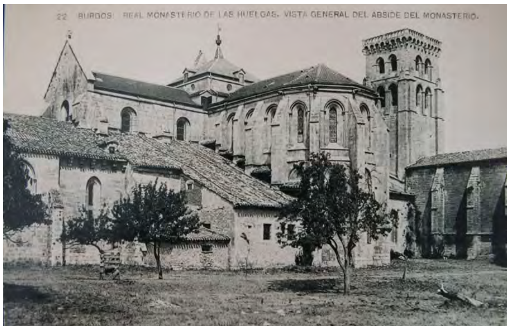
Fig. 212.- Las Huelgas. Iglesia abacial. Fotografía posterior a 1892 que muestra la estructura adosada a la capilla meridional contigua a la central (© Archivo Municipal de Burgos)
