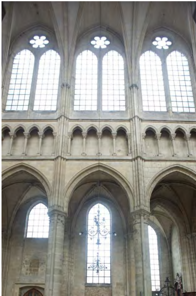
Fig. 561.- Soissons. Catedral. Alzado de la nave central
