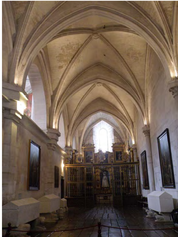
Fig. 352.- Las Huelgas. Iglesia abacial. Bóvedas sobrealzadas de los cuatro tramos occidentales de la nave septentrional
