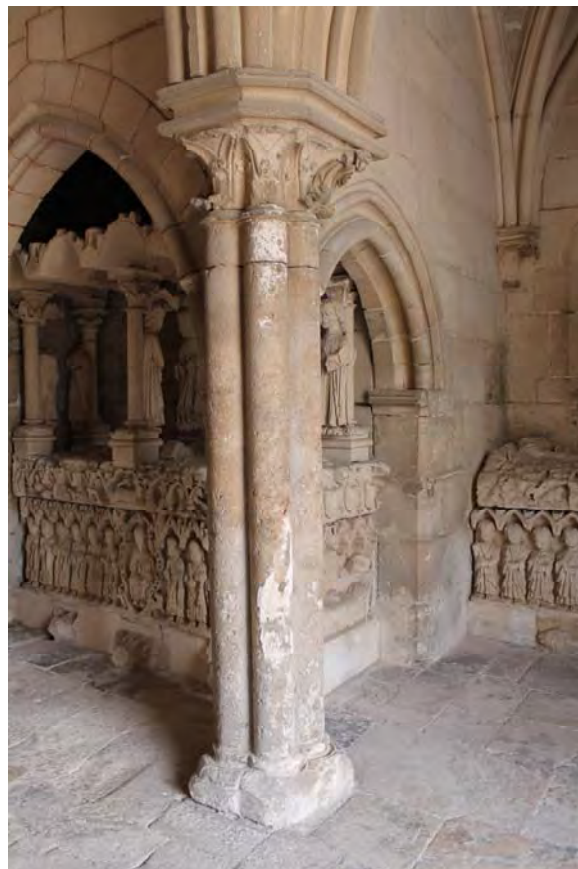
Fig. 824.- Las Huelgas. Vestíbulo. Grupo de tres columnas en el límite oriental entre los dos tramos occidentales y, tras él, el espacio habilitado en el ángulo del contrafuerte angular del brazo norte del transepto
