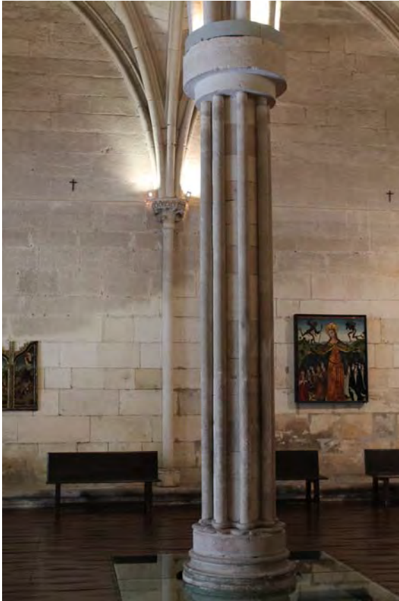
Fig. 655.- Las Huelgas. Sala capitular. Uno de los cuatro pilares exentos con columnas adosadas en délit que dividen su espacio interior
