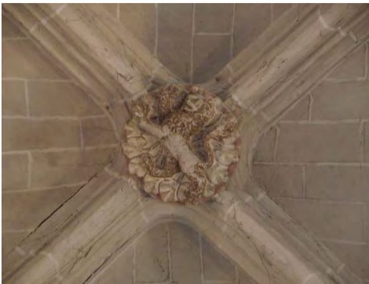
Fig. 380.- Las Huelgas. Iglesia abacial. Clave de bóveda del séptimo tramo (desde el este) de la nave sur: león heráldico
