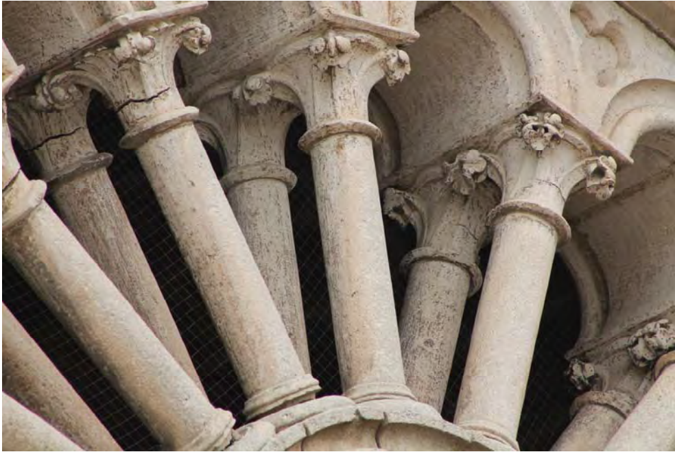
Fig. 833.- Las Huelgas. Vestíbulo. Detalle de las pequeñas columnas que conforman los radios del rosetón
