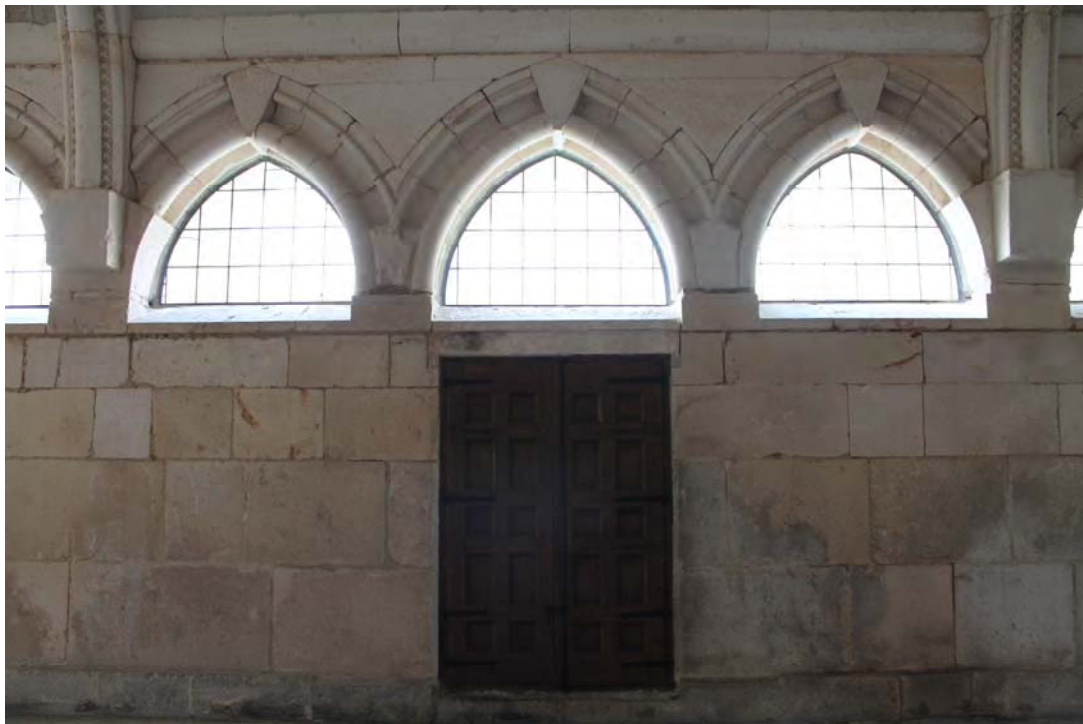
Fig. 569.- Las Huelgas. Claustro de San Fernando. Grupo de tres arcos de la arquería de la panda meridional
