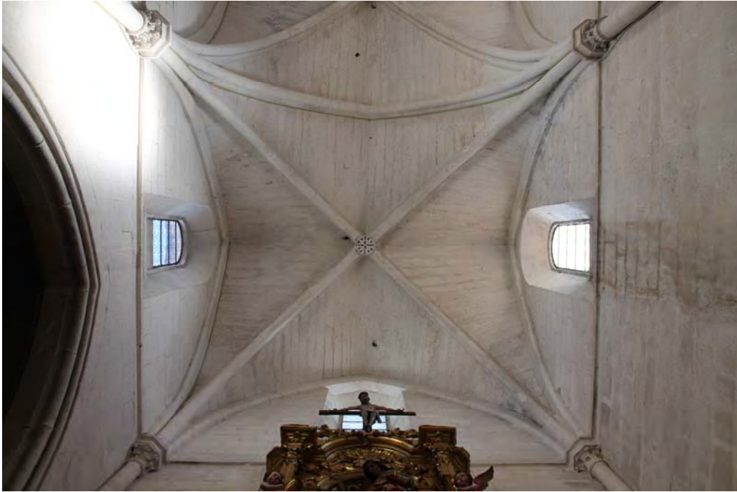
Fig. 248.- Las Huelgas. Iglesia abacial. Bóveda del tramo meridional del transepto
