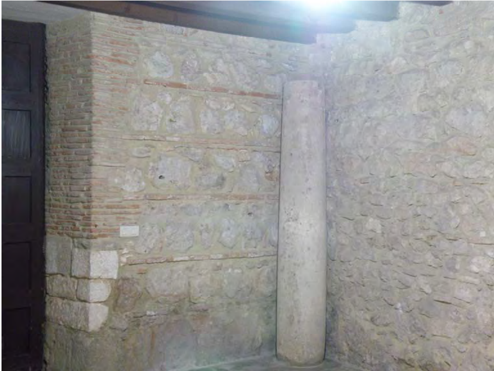
Fig. 169.- Las Huelgas. Claustro de Las Claustillas. Esquinazo suroeste de la estancia previa a la capilla de la Asunción, donde se puede ver el contraste de aparejo entre los muros perimetrales (con verdugadas) y el muro transversal añadido a posteriori para dividir el pabellón norte en varias estancias (sin verdugadas)
