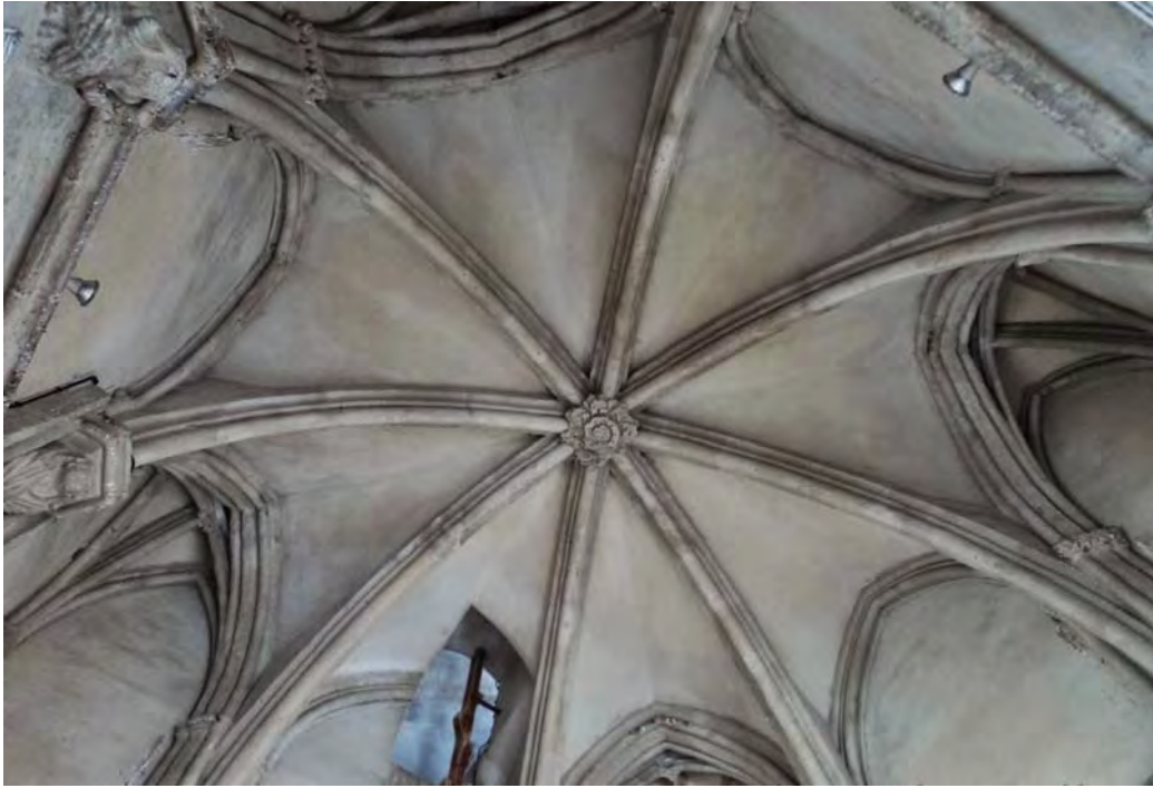
Fig. 509.- Sevilla. Torreón de don Fadrique. Bóveda de su planta superior
