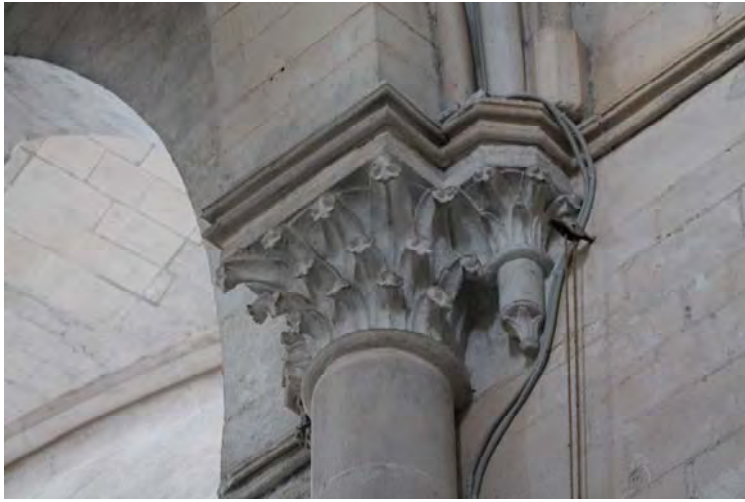
Fig. 198.- Las Huelgas. Iglesia abacial. Cul-de-lampe del extremo occidental del muro norte del presbiterio
