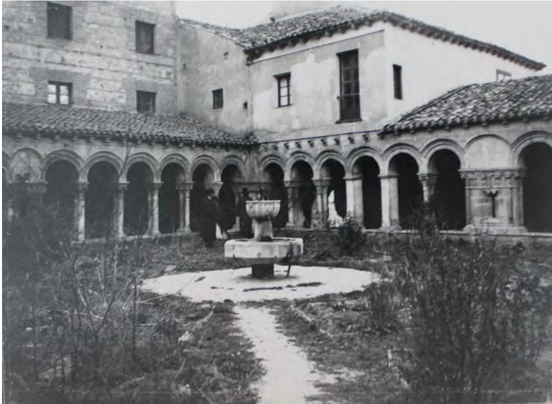
Fig. 97.- Las Huelgas. Claustro de Las Claustrillas. Antigua fotografía de la panda meridional, donde se aprecian los dos pilares alzados en sustitución de las columnas primitivas (© Archivo Municipal de Burgos)
