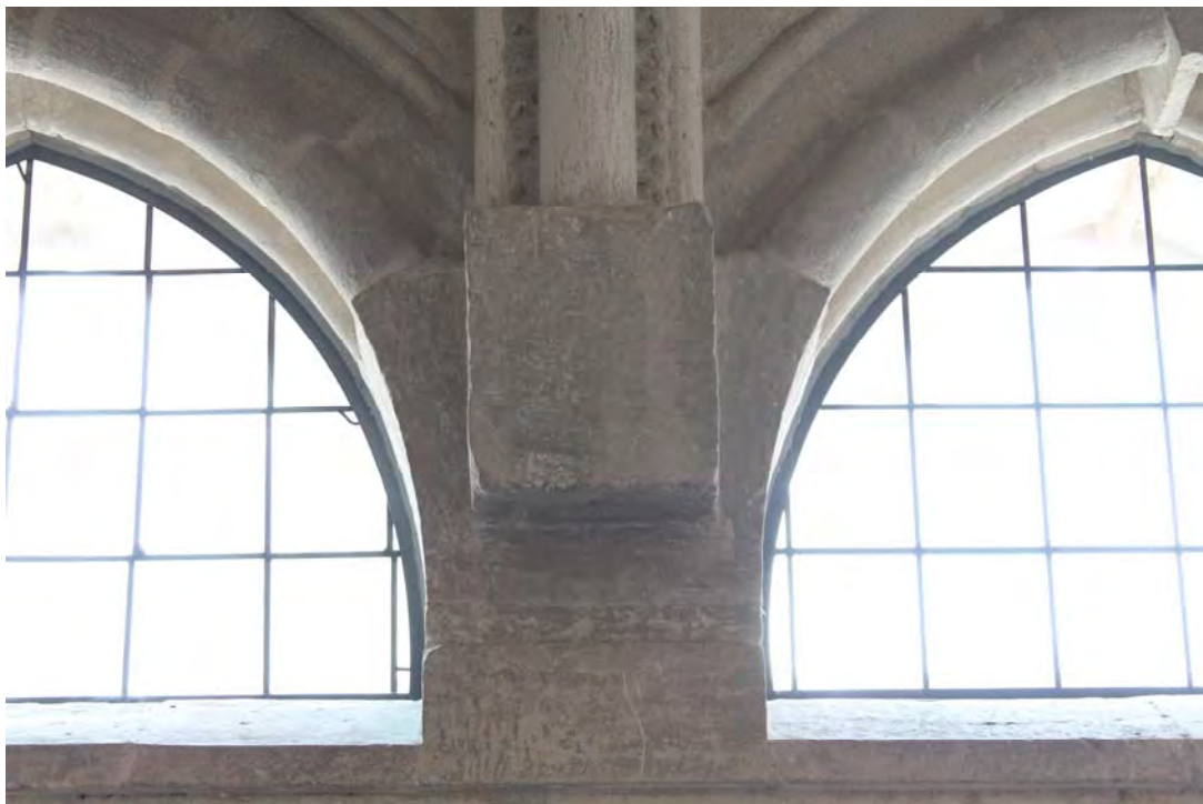
Fig. 571.- Las Huelgas. Claustro de San Fernando. Salmer de la panda occidental, común a dos arcos, cuya molduración y cuya ménsula (que marca el nacimiento del arco perpiaño de la bóveda) quedaron sin labrar
