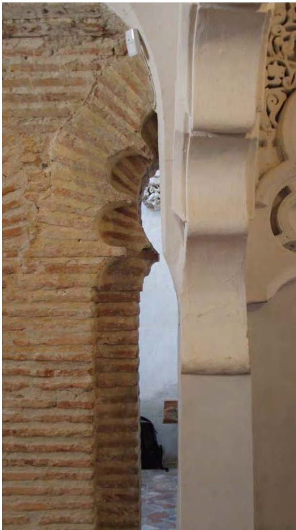
Fig. 133.- Las Huelgas. Capilla de la Asuncion. Arco occidental del muro meridional, obliterado por la trompa suroeste
