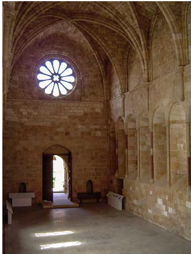
Fig. 514.- Monasterio de Santa María de Huerta. Refectorio, hacia el sur
