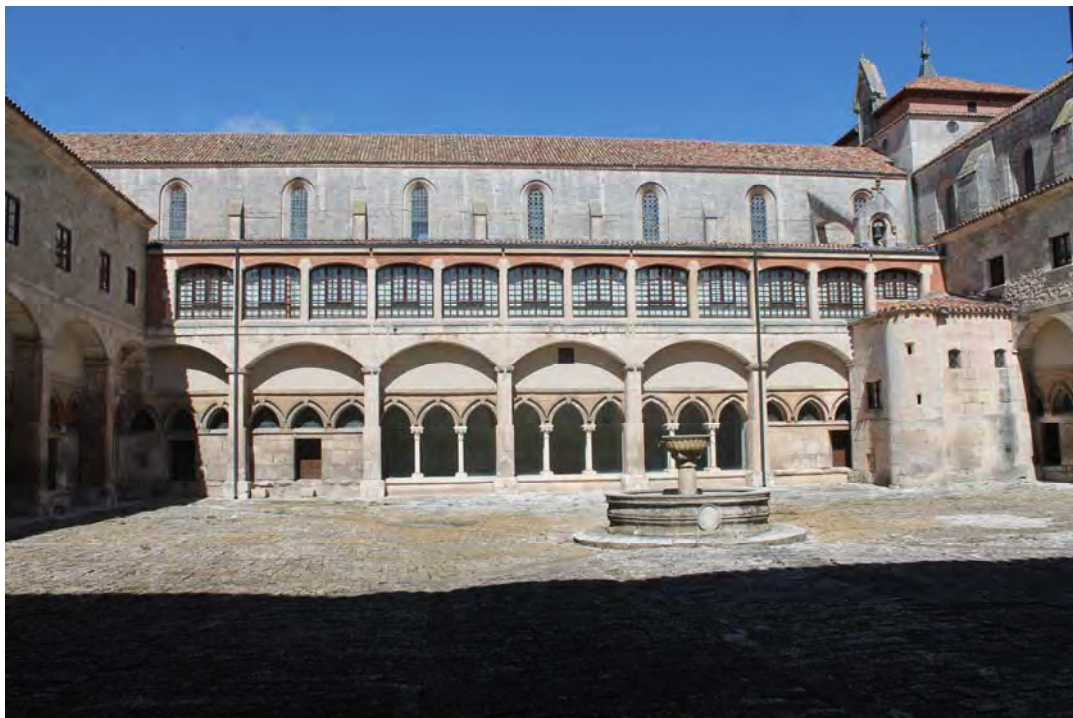
Fig. 319.- Las Huelgas. Iglesia abacial. Vista del flanco meridional del cuerpo de naves desde el claustro de San Fernando, en la que se ven los contrafuertes que se suceden en el claristorio de la nave central
