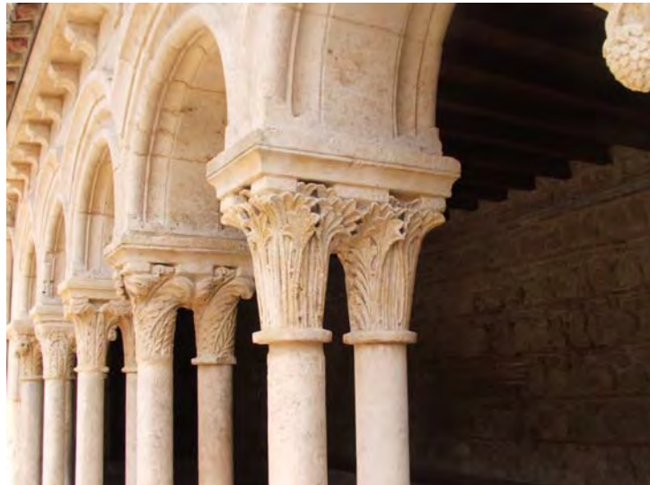
Fig. 40.- Las Huelgas. Claustro de Las Claustrillas. Capiteles dobles de la panda oriental, en los que se aprecia su perfil elongado
