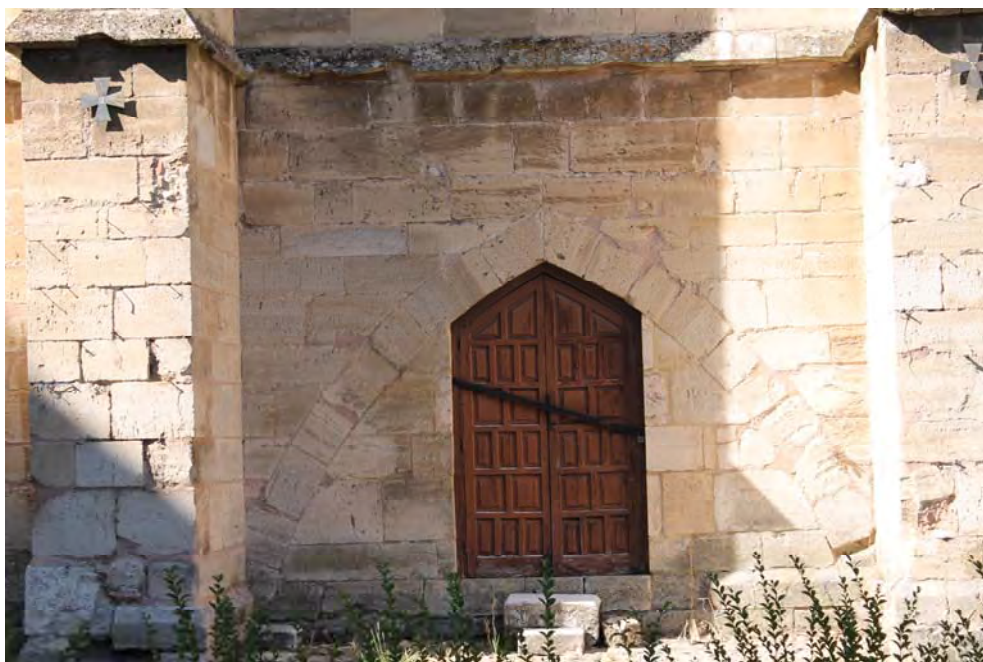
Fig. 857.- Las Huelgas. Capilla de San Juan. Puerta de su muro meridional, abierta en el arcosolio occidental
