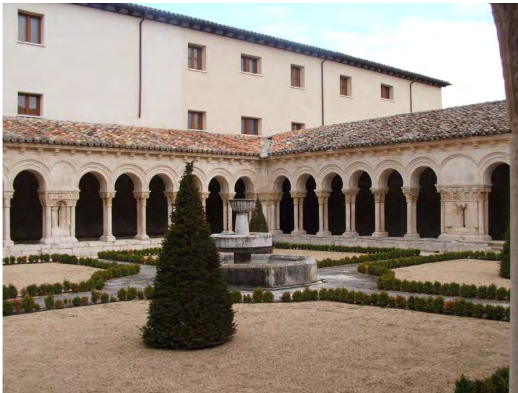
Fig. 34.- Las Huelgas. Claustro de Las Claustrillas. Vista general
