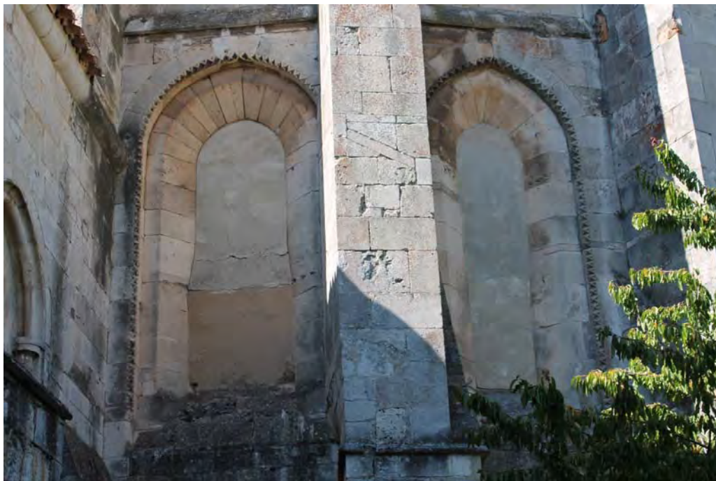
Fig. 549.- Las Huelgas. Iglesia abacial. Unión del testero oriental de la capilla lateral adyacente a la mayor por el sur y del arranque meridional del heptágono absidal
