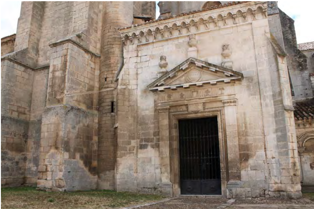
Fig. 836.- Las Huelgas. Vestíbulo. Fachada septentrional del tramo que precede la fachada del transepto
