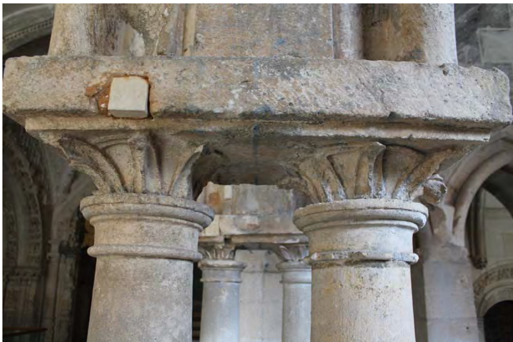
Fig. 580.- Las Huelgas. Claustro de San Fernando. Remate superior de los capiteles de crochets originales de las columnas del arranque oriental de la panda norte, por lo demás sustituidos por nuevos capiteles y fustes renacentistas al ser edificada la capilla de Belén
