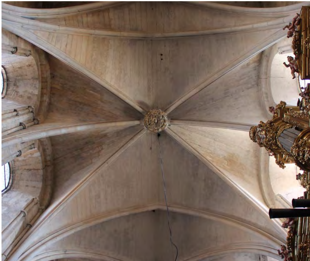
Fig. 185.- Las Huelgas. Iglesia abacial. Bóveda sexpartita del tramo oriental del presbiterio, en la que puede observarse la plementería formada por grandes lajas monolíticas
