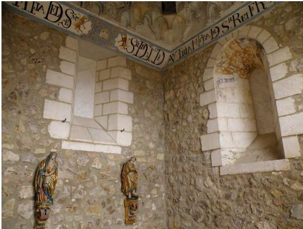
Fig. 759.- Las Huelgas. Capilla del Salvador. Esquinazo suroriental
