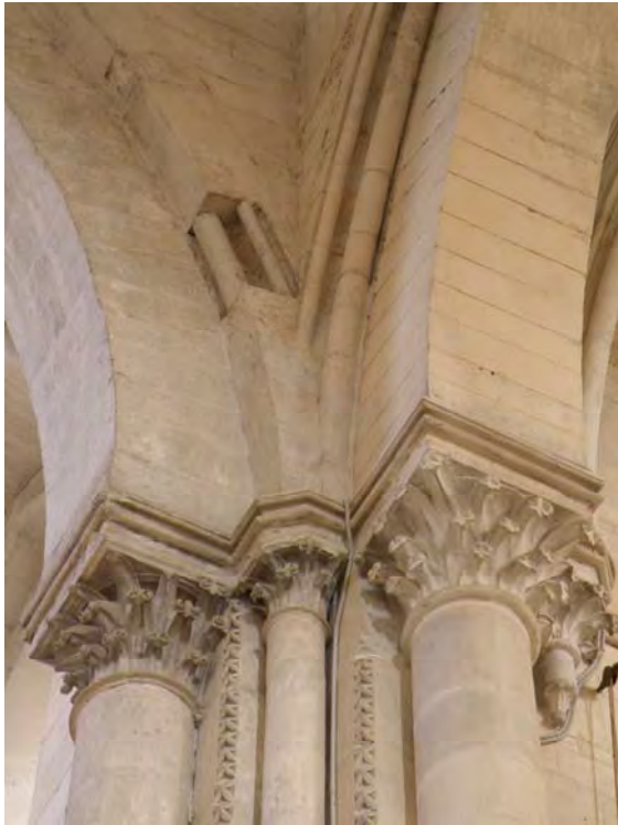
Fig. 250.- Las Huelgas. Iglesia abacial. Detalle del arranque de los arcos torales que dan paso a la capilla mayor (completamente moldurado) y al brazo norte del transepto (moldurado únicamente por encima del jarjamento)
