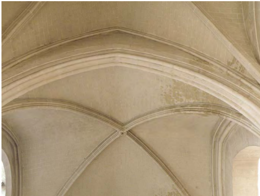
Fig. 353.- Las Huelgas. Iglesia abacial. Lienzos murales levantados sobre los arcos perpiaños para sobreelevar las bóvedas de los cuatro tramos occidentales de la nave septentrional
