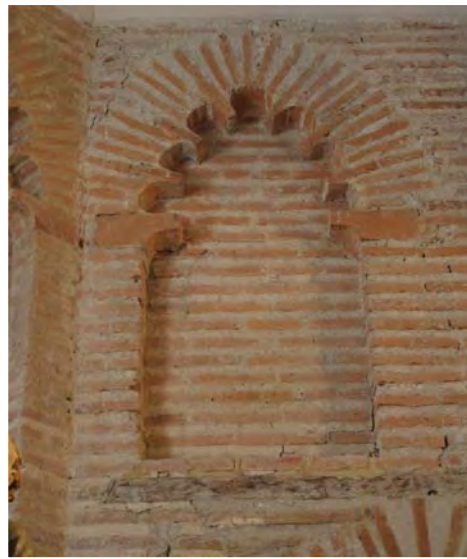
Fig. 130.- Las Huelgas. Capilla de la Asuncion. Arco ciego del extremo oriental del muro sur
