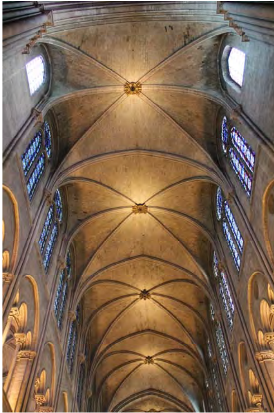
Fig. 485.- París. Catedral. Bóvedas sexpartitas de la nave central
