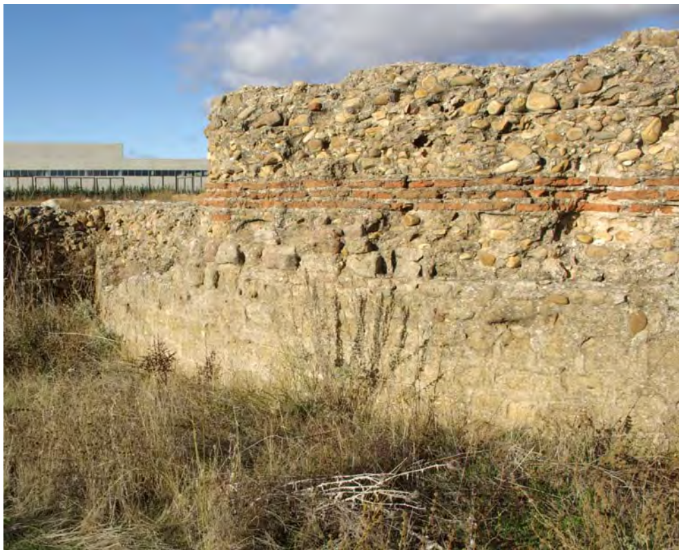
Fig. 88.- Marialba de la Ribera. Basílica martirial tardoantigua. Muro construido con cantos rodados, mortero y verdugadas de ladrillo
