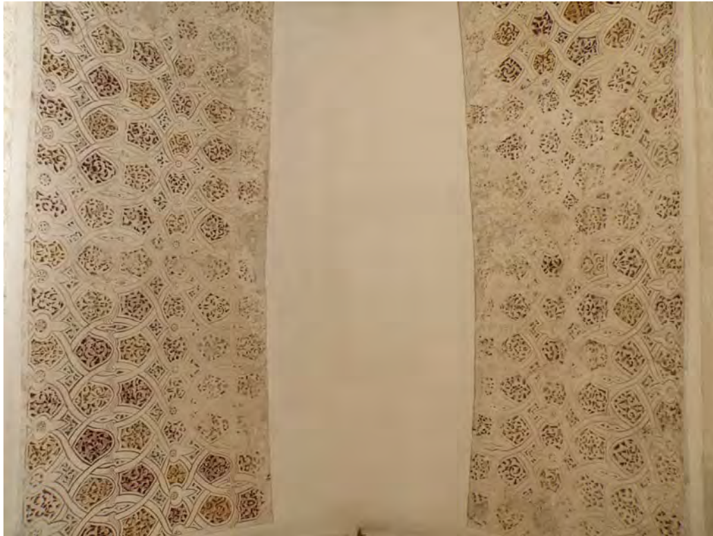
Fig. 625.- Las Huelgas. Claustro de San Fernando. Yaserías del octavo tramo (desde el sur) de la galería occidental
