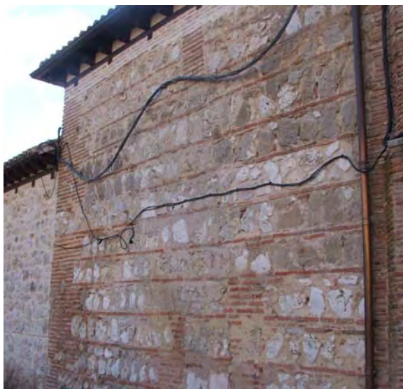
Fig. 104.- Las Huelgas. Capilla de la Asunción. Paramento externo del muro norte, construido con aparejo de mampostería y verdugadas de ladrillo
