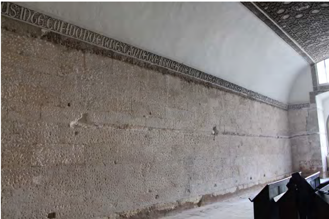
Fig. 692.- Las Huelgas. Locutorio. Aparejo de su muro septentrional
