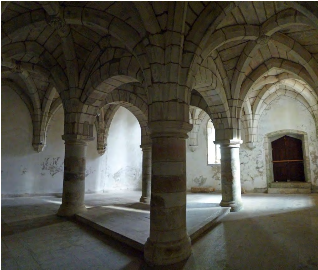
Fig. 187.- Monasterio de Sobrado de los Monjes. Cocina. Abovedamientos
