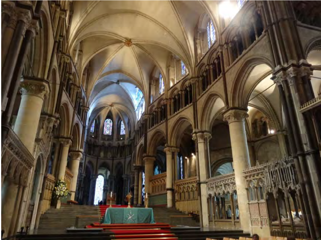
Fig. 463.- Canterbury. Catedral. Diversos tipos de pilares con columnas adosadas en délit en el entorno del altar mayor
