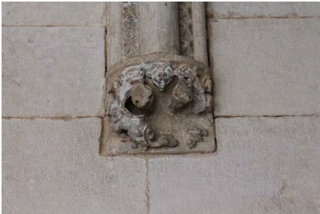
Fig. 725.- Las Huelgas. Claustro de San Fernando. Una de las ménsulas de la panda meridional que marcan el nacimiento de los arcos perpiaños por el lado del muro perimetral, en el cual se encastra a posteriori
