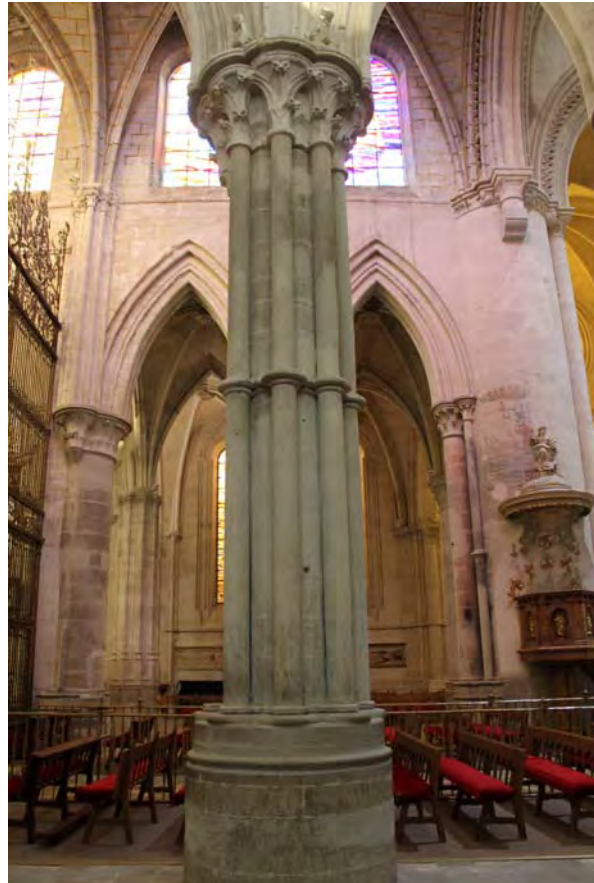
Fig. 480.- Cuenca. Catedral. Pilar que sostiene la arcada del presbiterio, de núcleo octogonal con columnas en délit
