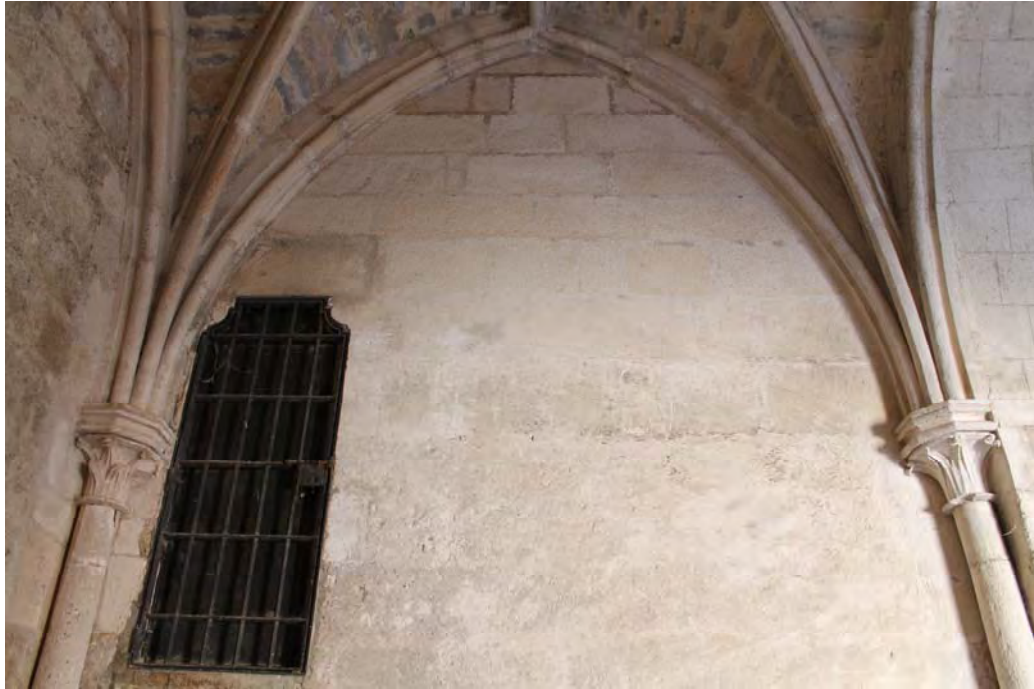
Fig. 803.- Las Huelgas. Pórtico de los Caballeros. Columnas adosadas en el tramo oriental
