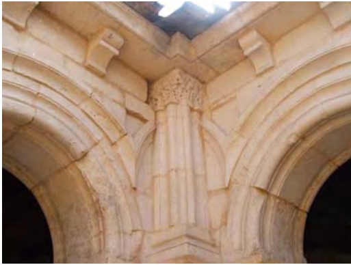
Fig. 50.- Las Huelgas. Claustro de Las Claustrillas. Detalle de la pilastra que corona el machón angular sureste
