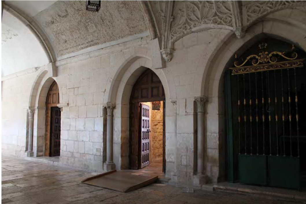
Fig. 585.- Las Huelgas. Claustro de San Fernando. Extremo meridional de la galería este, donde se puede observar cómo las ménsulas que dan arranque a los arcos perpiaños de la bóveda invaden las roscas de los arcos de las portadas del locutorio y del pasaje
