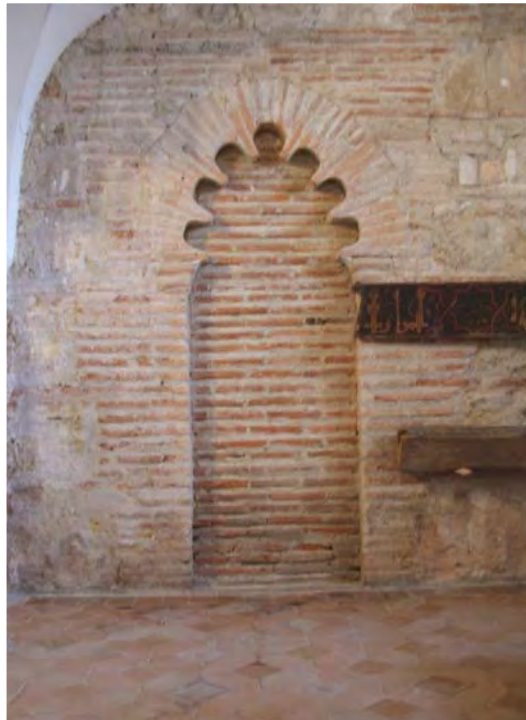
Fig. 128.- Las Huelgas. Capilla de la Asunción. Vano cegado del muro norte, antigua puerta
