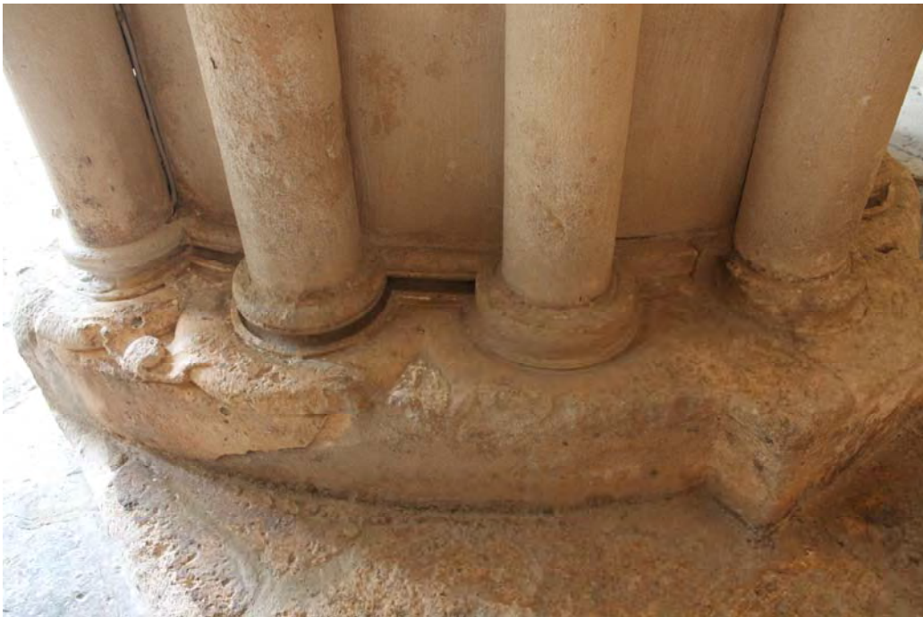
Fig. 679.- Las Huelgas. Sala capitular. Basas trabajadas y sin trabajar del pilar exento septentrional de la fachada
