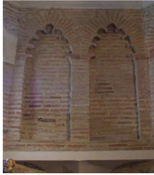
Fig. 122.- Las Huelgas. Capilla de la Asunción. Arcos polilobulados de la trompa oriental del lado sur
