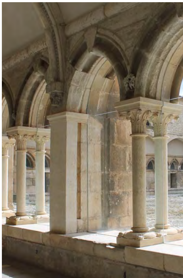
Fig. 726.- Las Huelgas. Claustro de San Fernando. Vista de uno de los contrafuertes claustrales desde la galería septentrional, en la que se ve cómo el estribo está perfectamente aparejado con la estructura de la arquería
