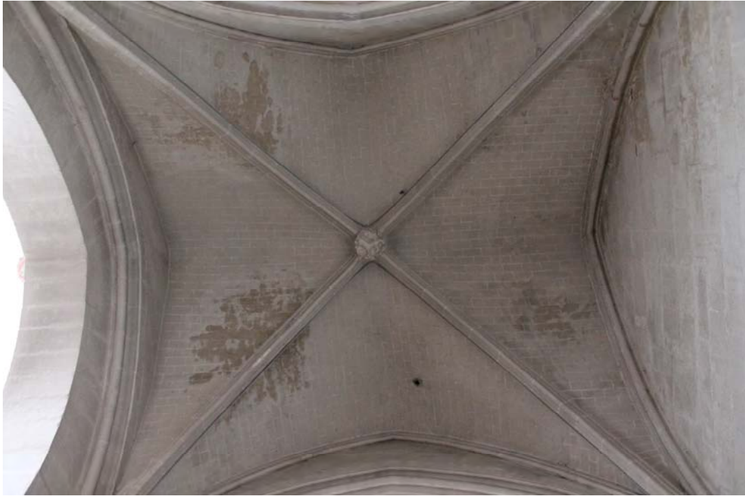
Fig. 344.- Las Huelgas. Iglesia abacial. Bóveda de crucería cuatripartita de la nave septentrional, cubierta por un enlucido con despiece pétreo simulado
