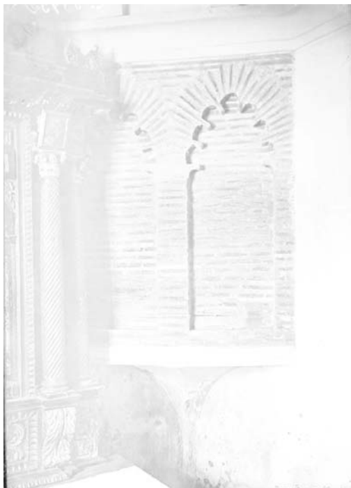
Fig. 150.- Las Huelgas. Capilla de la Asunción. Fotografía antigua, que muestra la trompa suroriental y el arranque del muro sur de la capilla (© IPCE, Fototeca del Patrimonio Artístico, Archivo Ruiz Vernacci)
