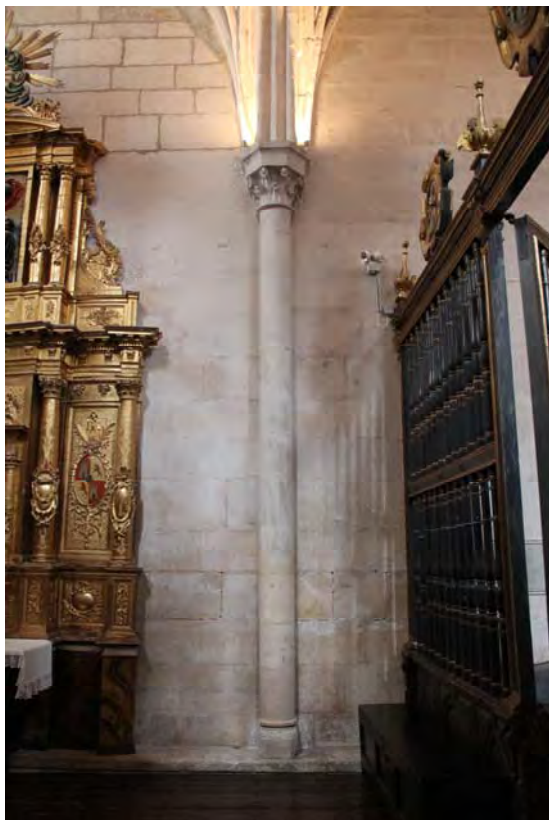
Fig. 358.- Las Huelgas. Iglesia abacial. Una de las columnas adosadas al muro norte de la nave septentrional
