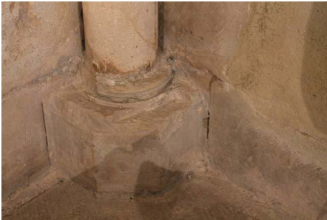
Fig. 662.- Las Huelgas. Sala capitular. Plinto y basa de una de las columnas cantoneras
