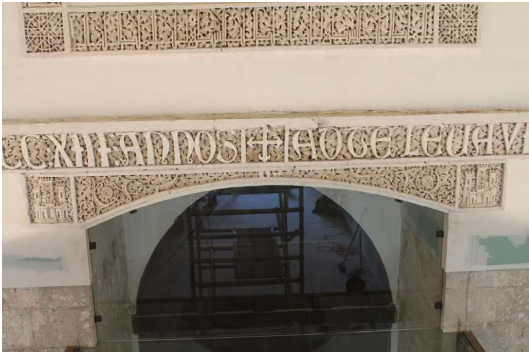
Fig. 685.- Las Huelgas. Locutorio. Yeserías sobre el arco escarzano occidental
