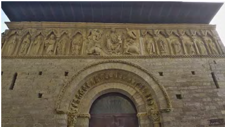
Fig. 66.- Carrión de los Condes. Iglesia de Santiago. Apostolado
