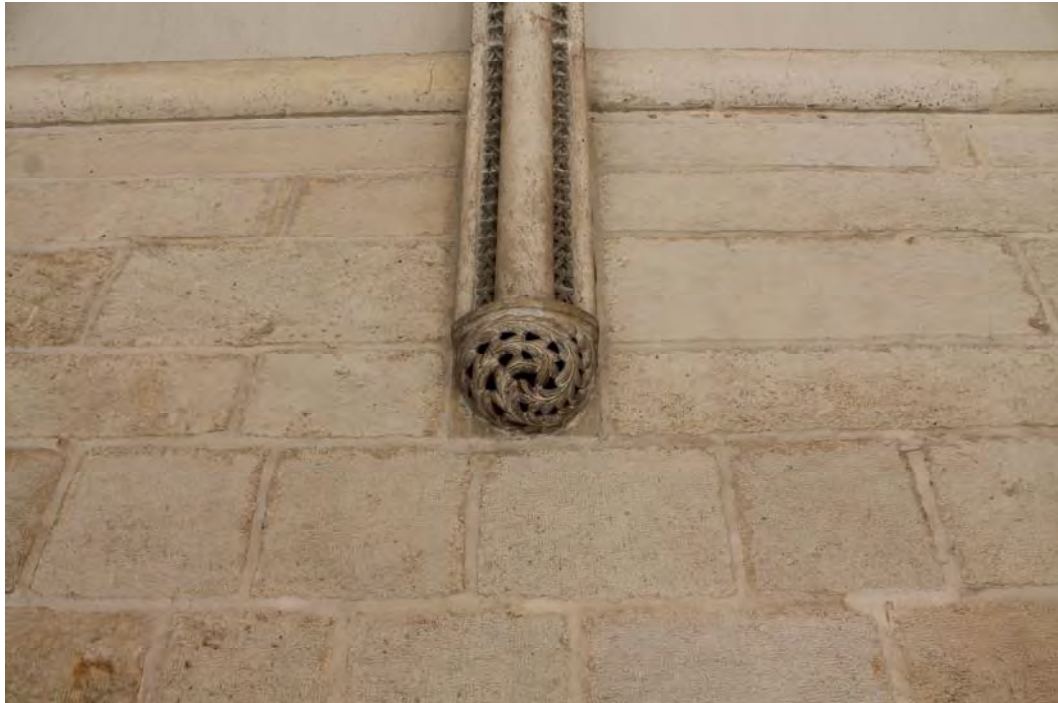
Fig. 586.- Las Huelgas. Claustro de San Fernando. Detalle de la ménsula y de la molduración de uno de los arcos perpiaños del abovedamiento (en su arranque del costado del muro perimetral), situado en la panda septentrional
