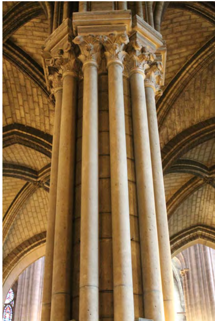
Fig. 462.- París. Catedral. Pilar con columnas en délit del intercolumnio del doble colateral meridional
