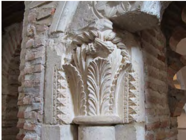
Fig. 78.- Las Huelgas. Capitel izquierdo del arcosolio funerario reutilizado como puerta entre la capilla de la Asunción y la estancia adosada por el sur
