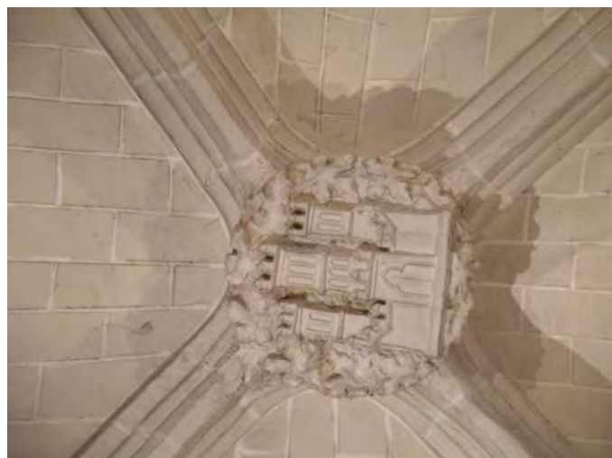
Fig. 348.- Las Huelgas. Iglesia abacial. Clave de bóveda de la nave septentrional: castillo
