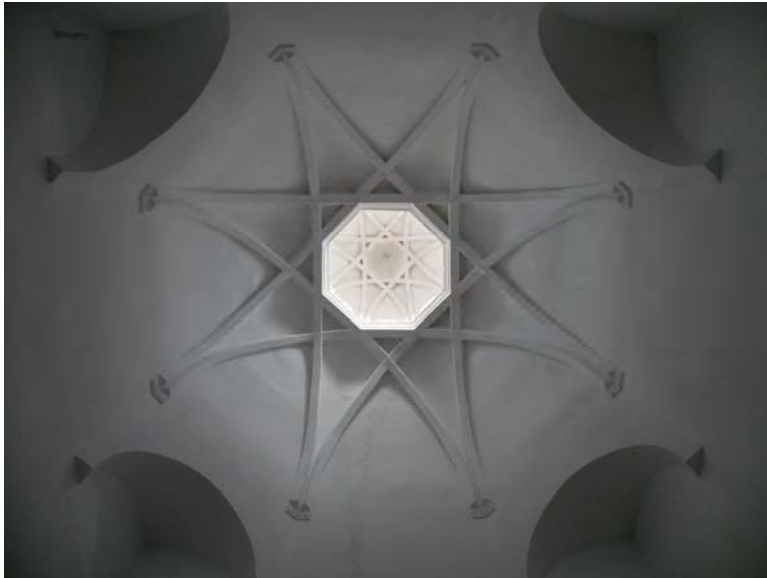
Fig. 142.- Córdoba. Convento dominico de San Pablo. Capilla Nueva, cúpula
