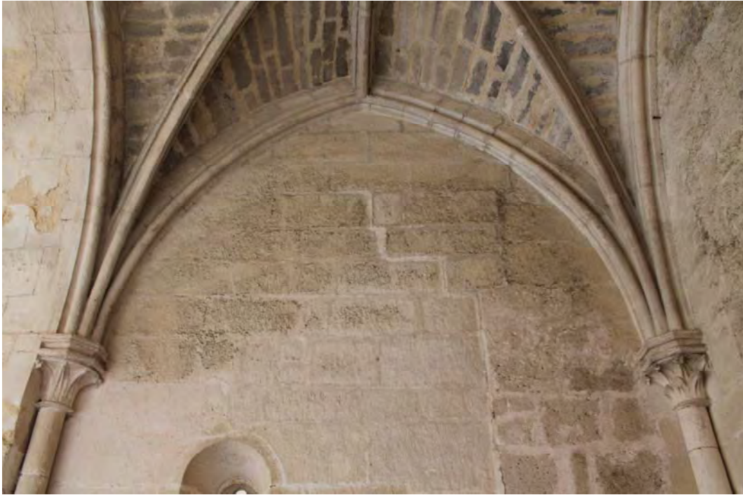
Fig. 817.- Las Huelgas. Pórtico de los Caballeros. Unión del contrafuerte del ángulo noroeste del brazo norte del transepto, de construcción previa, y del muro del tramo oriental del pórtico
