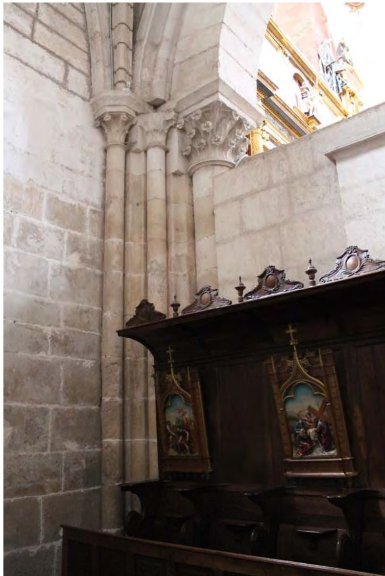
Fig. 305.- Las Huelgas. Iglesia abacial. Pilar adosado a la contrafachada correspondiente a la arcada meridional, visto desde la nave sur
