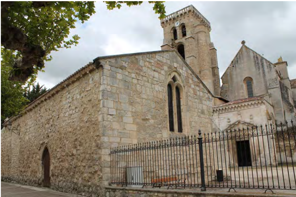
Fig. 791.- Las Huelgas. Capilla de San Martín. Muros occidental y septentrional
