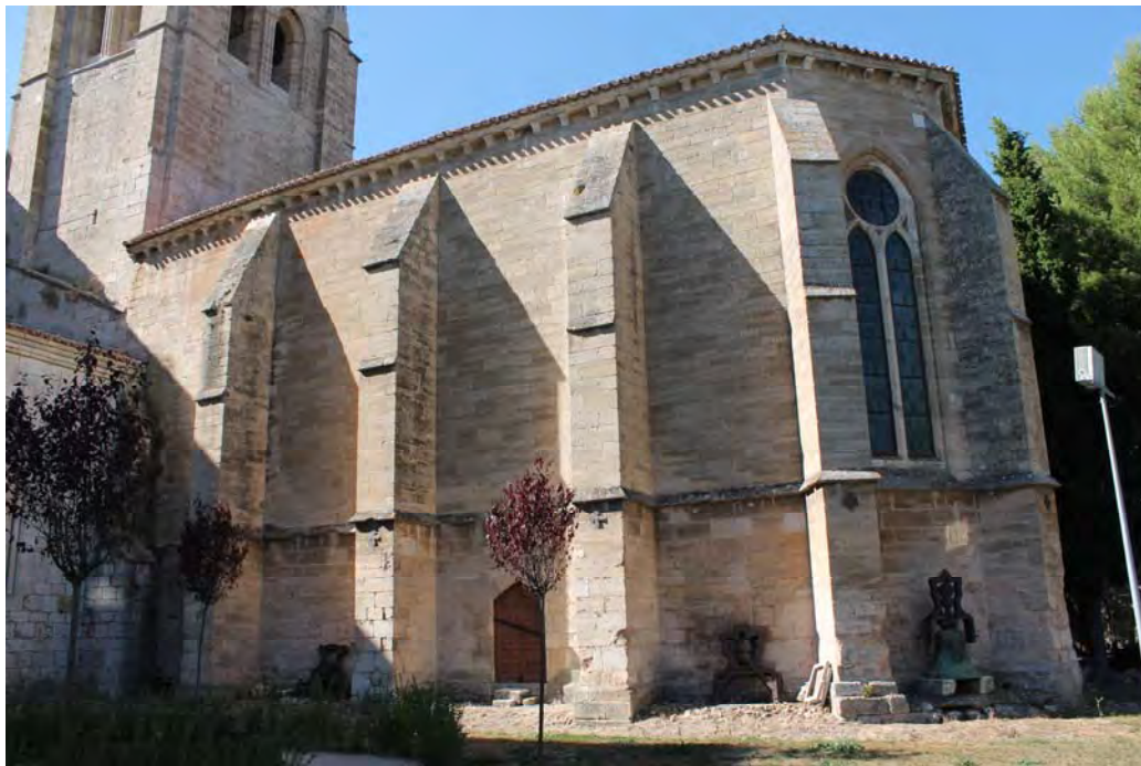
Fig. 865.- Las Huelgas. Capilla de San Juan. Muro meridional
