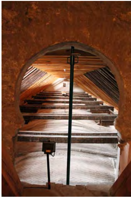
Fig. 713.- Las Huelgas. Refectorio. Espadaña del extremo septentrional de las cubiertas
