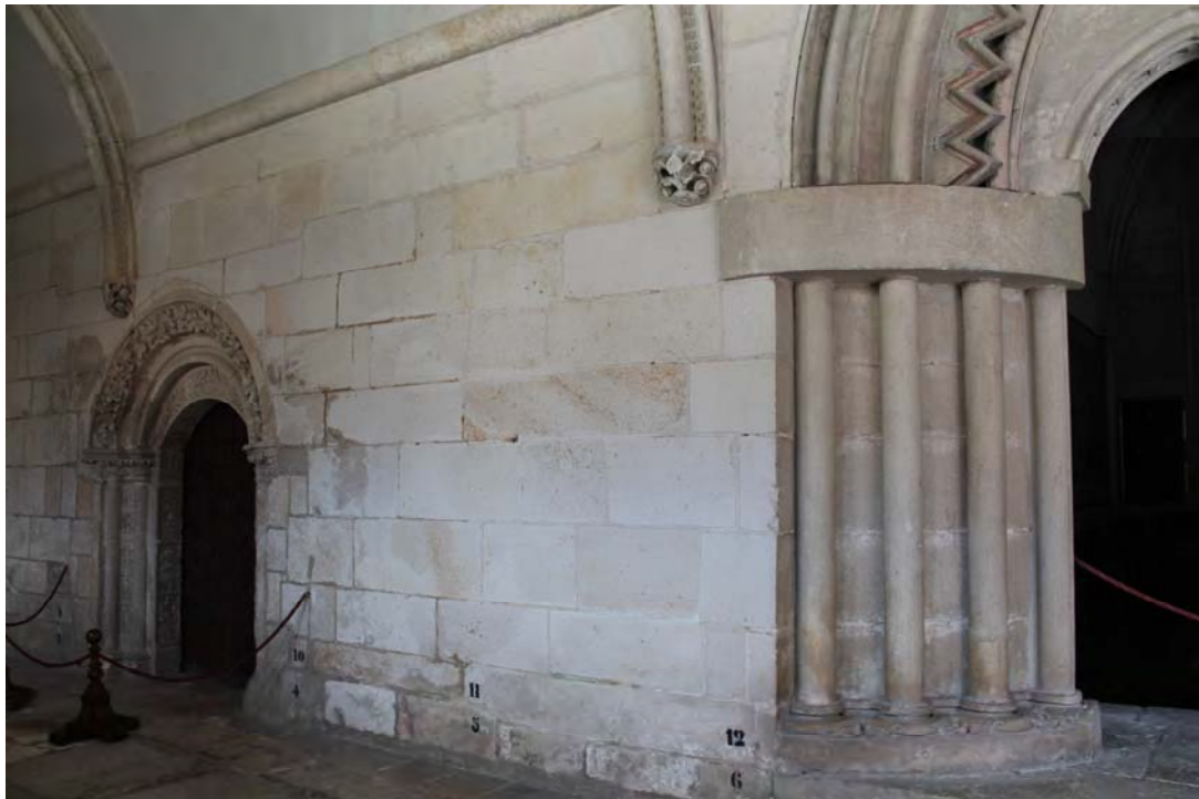
Fig. 749.- Las Huelgas. Claustro de San Fernando. Pilar adosado del extremo norte de la fachada occidental de la sala capitular y su unión con el muro perimetral del claustro
