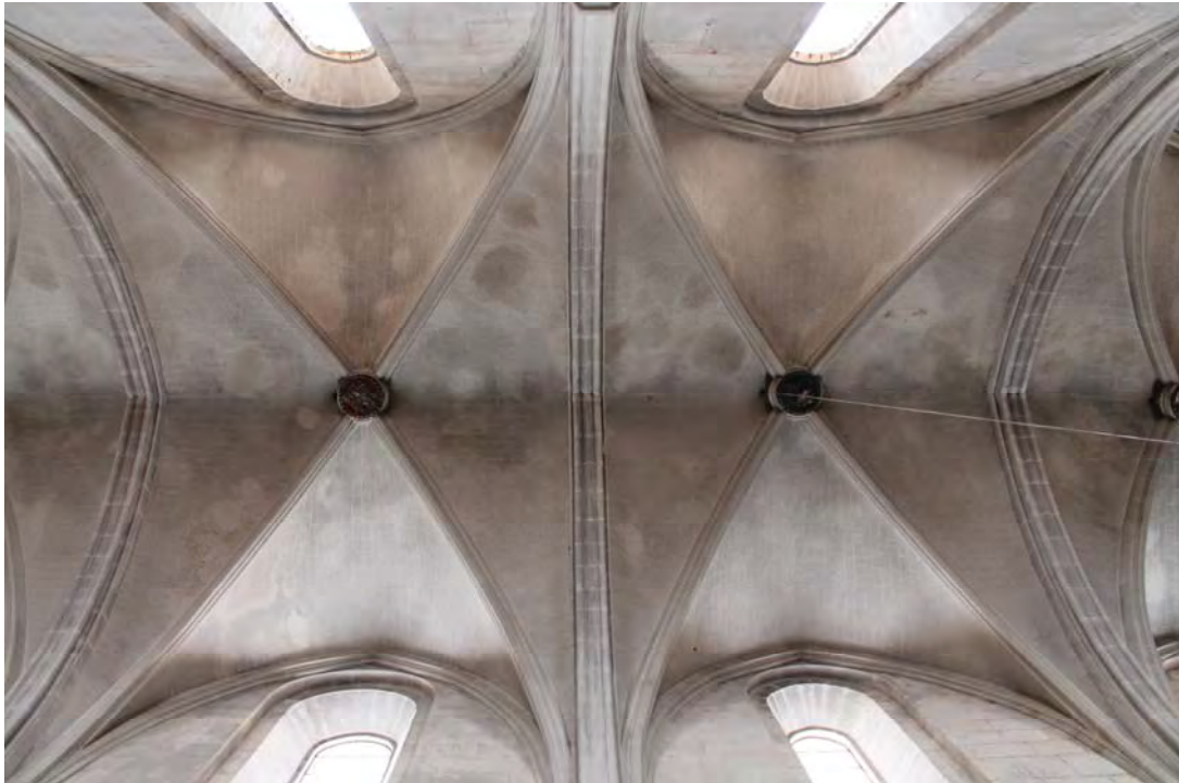
Fig. 309.- Las Huelgas. Iglesia abacial. Bóvedas de crucería cuatrimpartita de la nave central
