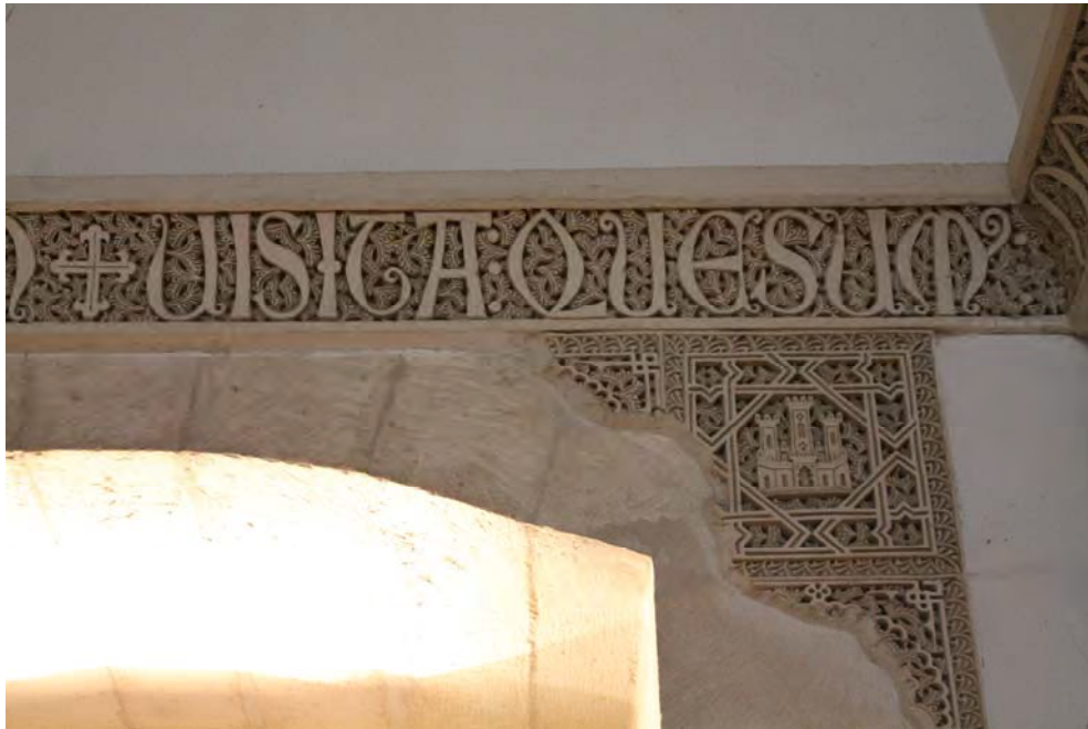
Fig. 700.- Las Huelgas. Pasaje. Fragmento de las yeserías de la cenefa que hace las veces de falsa imposta, en el testero occidental de la sala
