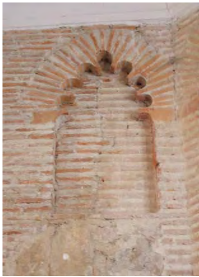
Fig. 129.- Las Huelgas. Capilla de la Asuncion. Arco ciego del extremo oriental del muro norte
