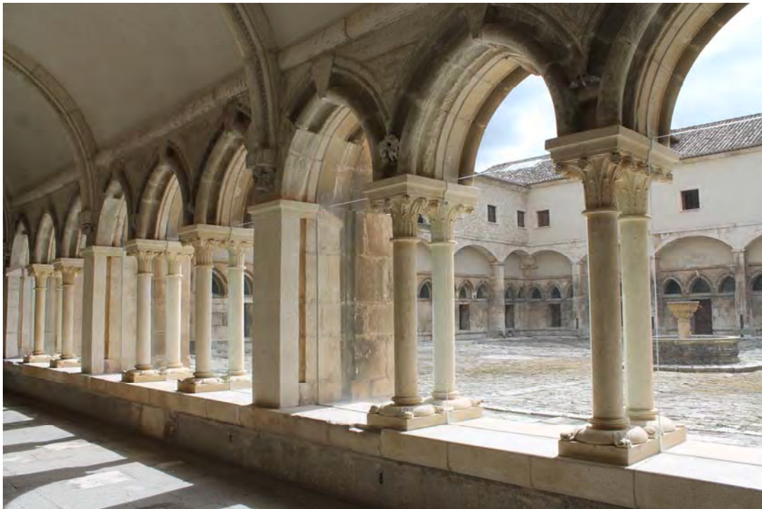
Fig. 574.- Las Huelgas. Claustro de San Fernando. Columnas modernas de la panda septentrional, repuestas durante las obras de reconstrucción de 1998-2003
