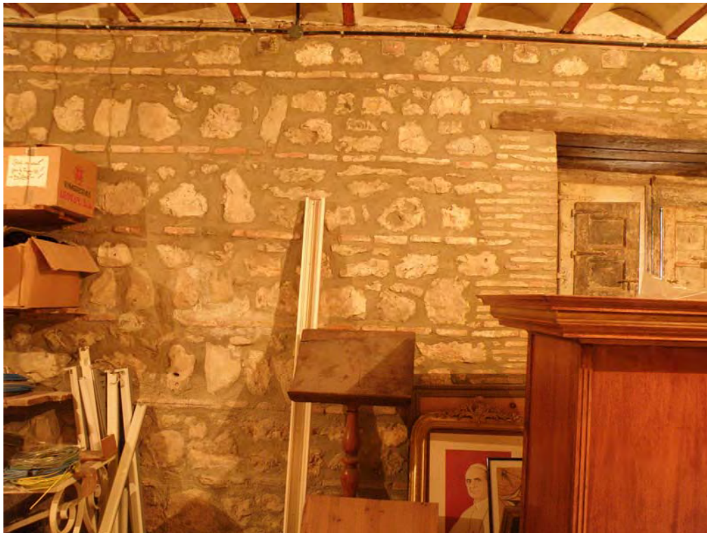
Fig. 161.- Las Huelgas. Claustro de Las Claustillas. Pabellón septentrional. Aparejo del paramento interno de sus muros, con mampostería y verdugadas
