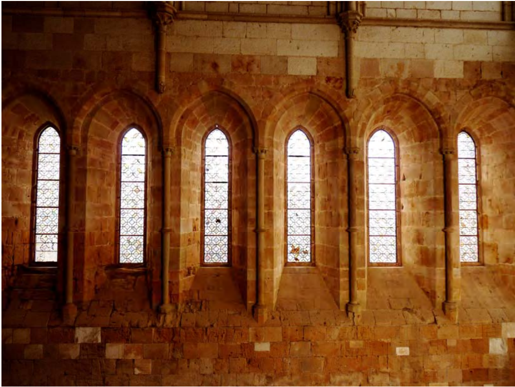
Fig. 483.- Monasterio de Santa María de Huerta. Columnas en délit de los muros del refectorio
