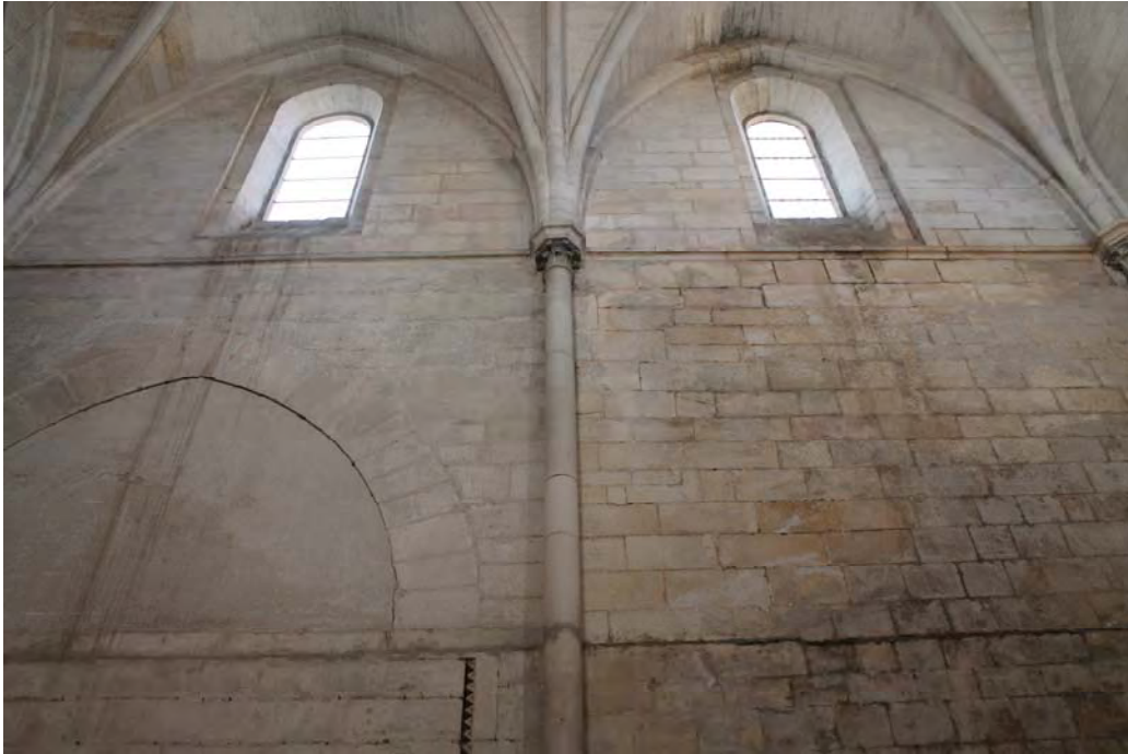
Fig. 282.- Las Huelgas. Iglesia abacial. Saltos de hiladas producidos en el muro occidental del transepto, en el punto de confluencia entre los dos tramos de su brazo norte
