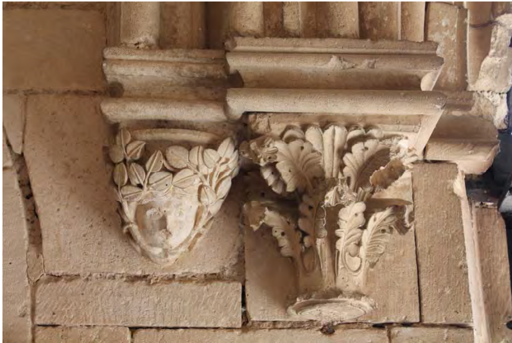
Fig. 823.- Las Huelgas. Vestíbulo. Ménsulas antropomorfa y vegetal que sostienen, respectivamente, las nervaduras del tramo meridional del extremo occidental del vestíbulo y el arco perpiaño y las nervaduras de su tramo norte
