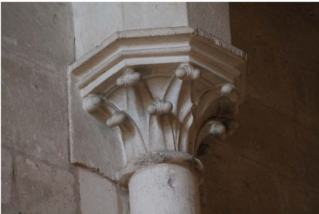
Fig. 642.- Las Huelgas. Sacristía. Uno de los capiteles de crochets de las columnas adosadas a los muros
