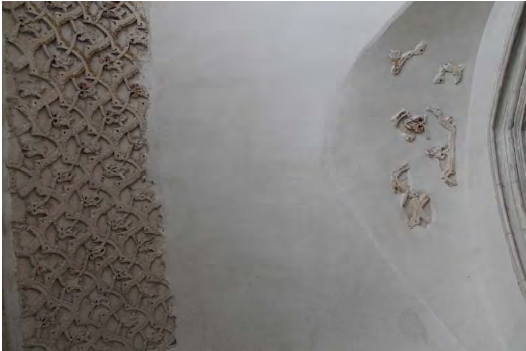
Fig. 601.- Las Huelgas. Claustro de San Fernando. Yaserías del cuarto tramo (desde el norte) de la galería oriental
