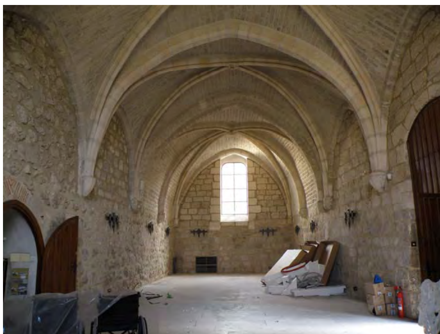
Fig. 789.- Las Huelgas. Capilla de San Martín. Vista hacia el este
