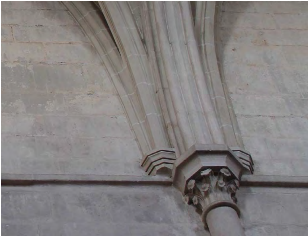
Fig. 560.- Las Huelgas. Iglesia abacial. Nervios diagonales y arcos formeros ciegos perfectamente enjarjados en el resto de tramos de la nave central
