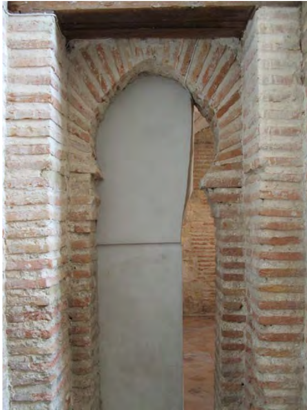
Fig. 134.- Las Huelgas. Capilla de la Asunción. Vano occidental del muro sur. Arco túbido interno
