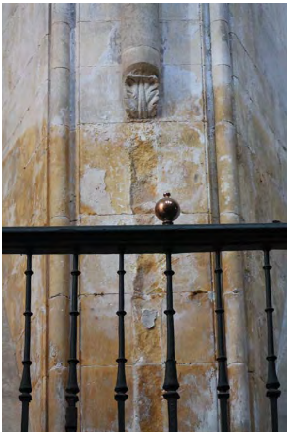
Fig. 200.- Las Huelgas. Iglesia abacial. Columna entrega del muro norte del presbiterio, rematada en un cul-de-lampe de factura moderna, bajo el cual pueden verse las huellas de la eliminación de los antiguos tambores
