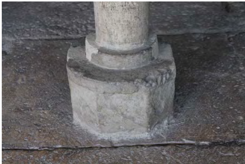
Fig. 677.- Las Huelgas. Sala capitular. Basa sin terminar de ser labrada de la columna que ejerce de parteluz de uno de los dos vanos laterales de la fachada occidental
