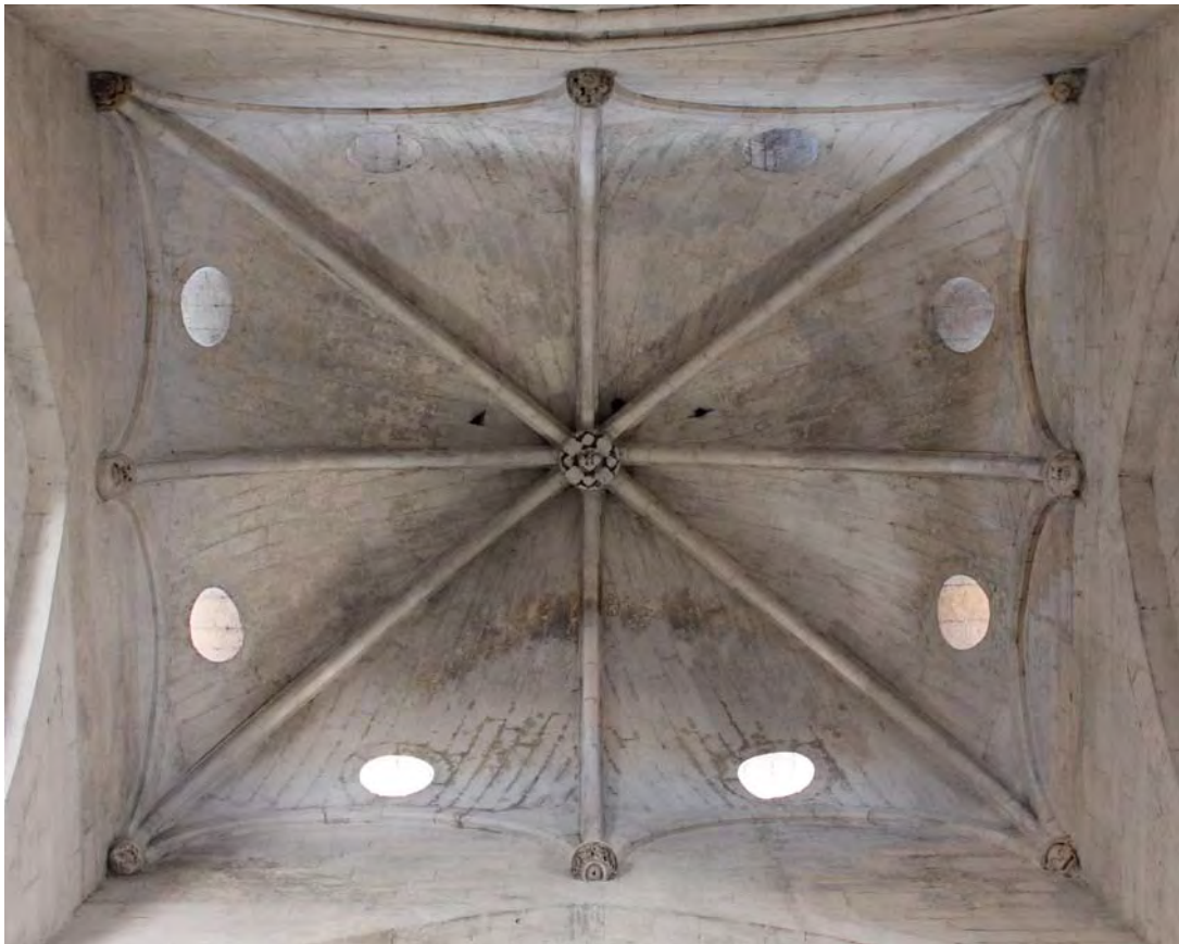
Fig. 251.- Las Huelgas. Iglesia abacial. Bóveda octopartita del cimborrio
