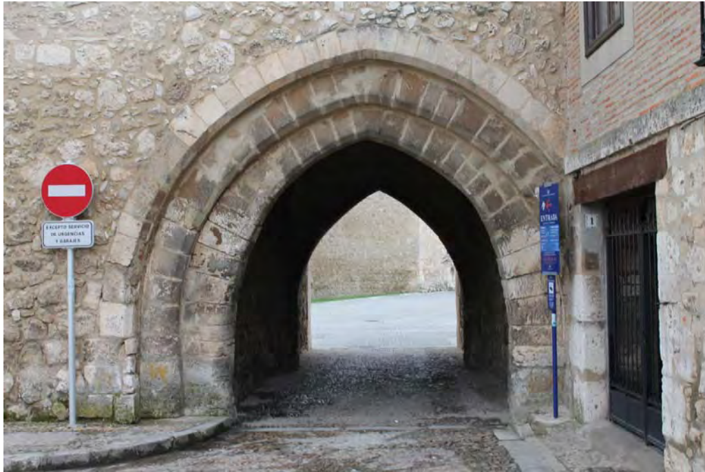
Fig. 755.- Las Huelgas. Torreón. Puerta abierta en su muro norte
