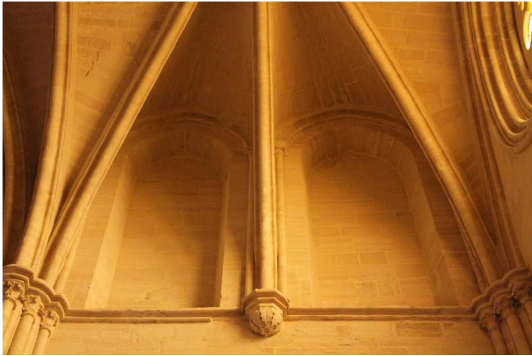
Fig. 550.- Cuenca. Catedral. Ventanas cegadas de origen del muro oriental del brazo meridional del transepto
