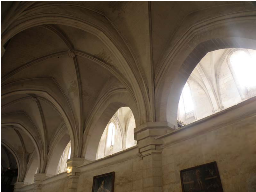
Fig. 357.- Las Huelgas. Iglesia abacial. Lenzos murales levantados sobre los forneros de la arcada de la nave norte para permitir la sobreelevación de sus bóvedas
