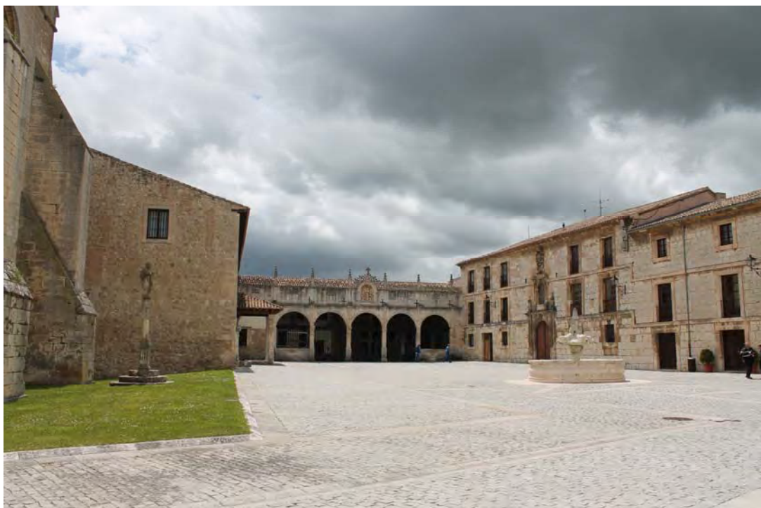
Fig. 750.- Las Huelgas. Compás de adentro. Vista hacia el sur
