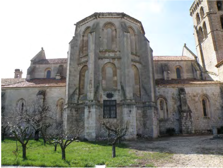
Fig. 181.- Las Huelgas. Iglesia abacial. Capilla mayor, vista exterior
