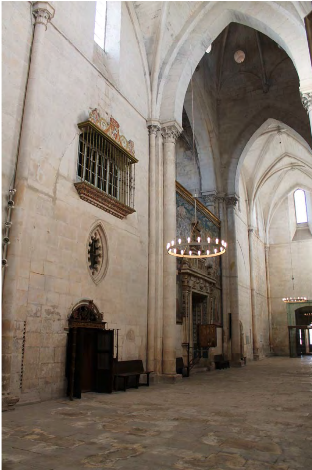
Fig. 268.- Las Huelgas. Iglesia abacial. Vista general del muro oeste del transepto
