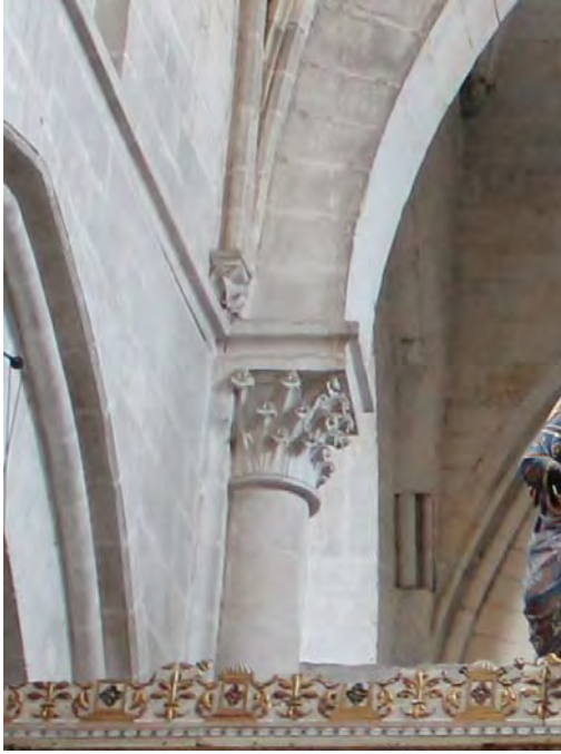
Fig. 552.- Las Huelgas. Iglesia abacial. Detalle de la alineación existente entre los tambores de los fustes de las columnas de los pilares torales occidentales y los sillares del enjutado existente sobre las arcadas del tramo oriental de la nave central
