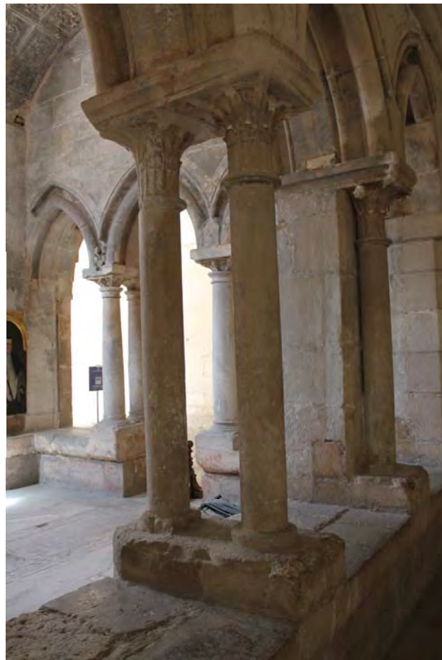
Fig. 576.- Las Huelgas. Claustro de San Fernando. Columnas originales supervivientes en el esquinazo noreste del claustro (extremo norte de la panda este), que comunica con la capilla de Belén
