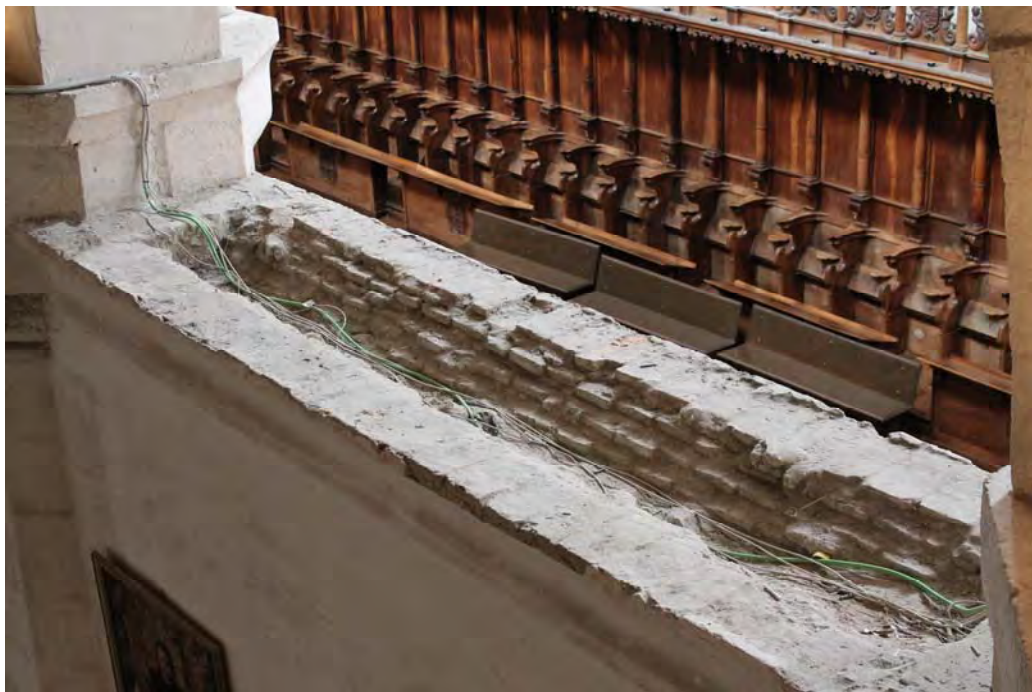
Fig. 562.- Las Huelgas. Iglesia abacial. Muro que separa la nave central de la meridional, construido con un núcleo de cascote y material de relleno, visto desde el coro alto de los dos tramos orientales de la nave sur
