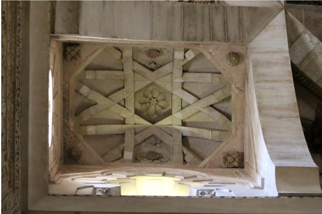
Fig. 113.- Córdoba. Mezquita aljama. Detalle de uno de los cuatro cupulines de las esquinas de la cúpula de la capilla de Villaviciosa
