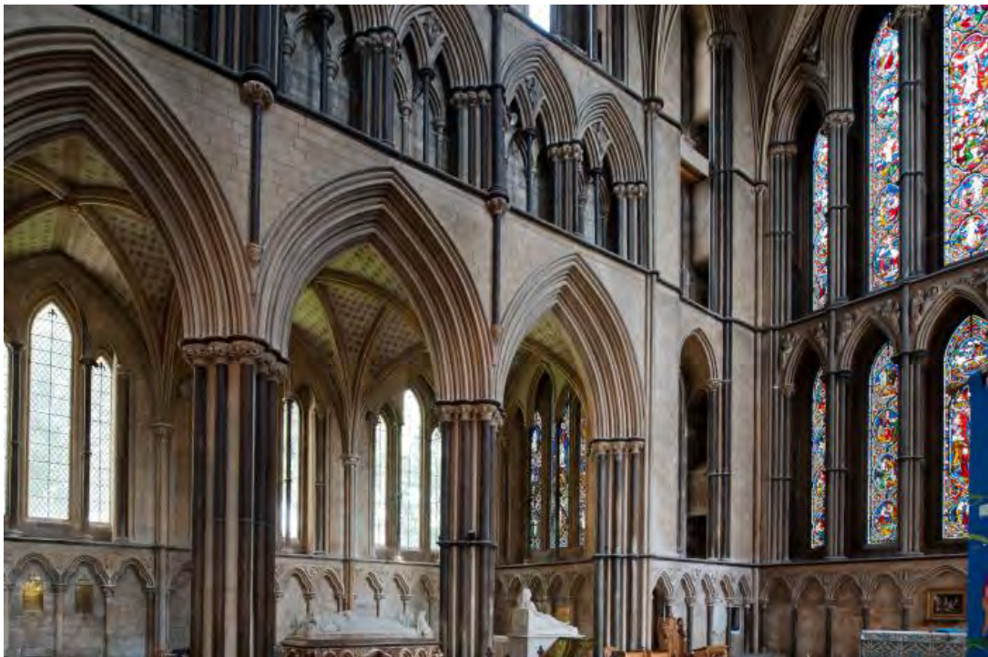
Fig. 464.- Worcester. Catedral. Algunos de los pilares con columnas en délit de la cabecera del edificio
