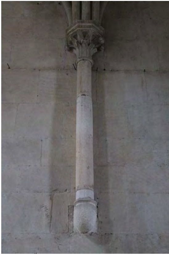
Fig. 229.- Las Huelgas. Iglesia abacial. Columna acabada en cul-de-lampe del muro norte de la capilla lateral septentrional
