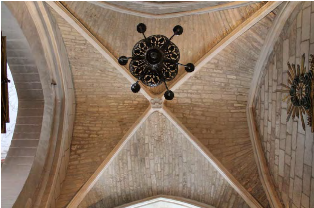
Fig. 345.- Las Huelgas. Iglesia abacial. Bóveda de crucería del tramo occidental de la nave septentrional, que muestra su auténtica plementería
