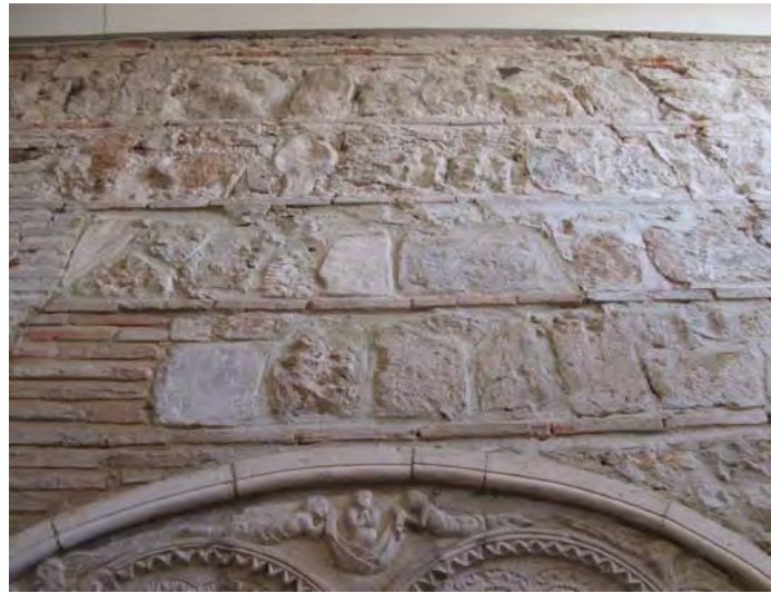
Fig. 105.- Las Huelgas. Capilla de la Asunción. Paramento externo del muro sur, con aparejo de cajas de mampostería entre verdugadas de ladrillo
