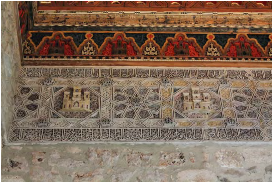
Fig. 882.- Las Huelgas. Capilla de Santiago. Detalle del friso de yesería que corona los muros de su cabecera
