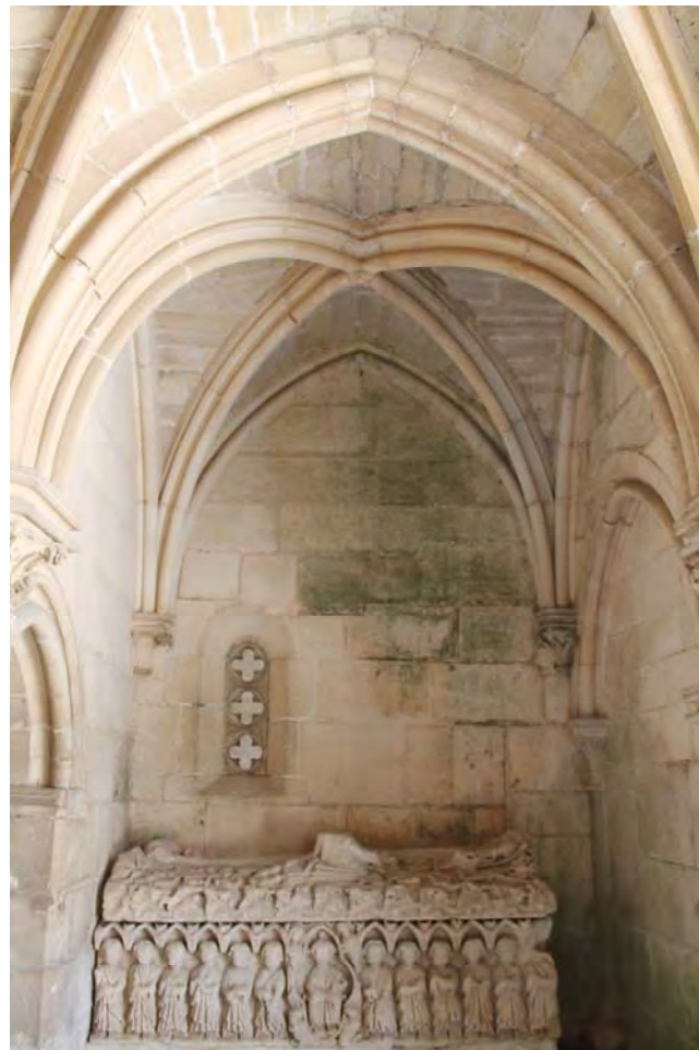
Fig. 822.- Las Huelgas. Vestíbulo. Los dos tramos occidentales, cubiertos con bóvedas de crucería
