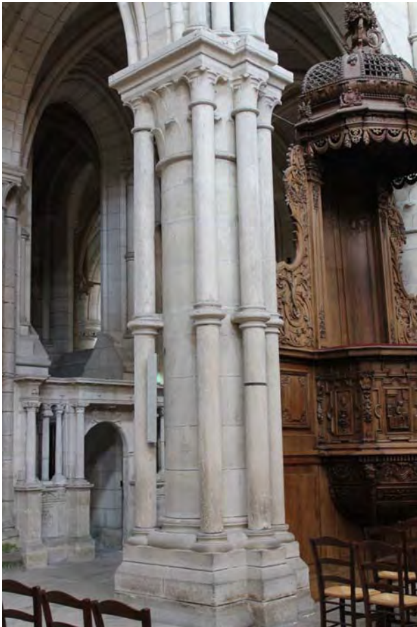
Fig. 471.- Laon. Catedral. Uno de los cuatro pilares con columnas a contralecho de la zona oriental de la nave
