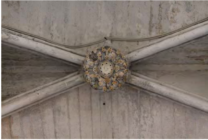
Fig. 183.- Las Huelgas. Iglesia abacial. Clave de la bóveda del tramo occidental del presbiterio
