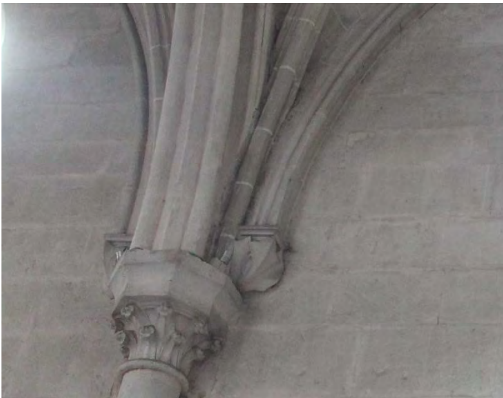
Fig. 556.- Las Huelgas. Iglesia abacial. Detalle del arranque del abovedamiento de uno de los tramos orientales de la nave septentrional, con los nervios diagonales sin enjarjar con los arcos formeros ciegos
