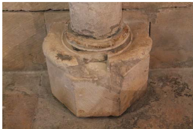
Fig. 663.- Las Huelgas. Sala capitular. Plinto y basa de una de las columnas adosadas a los muros
