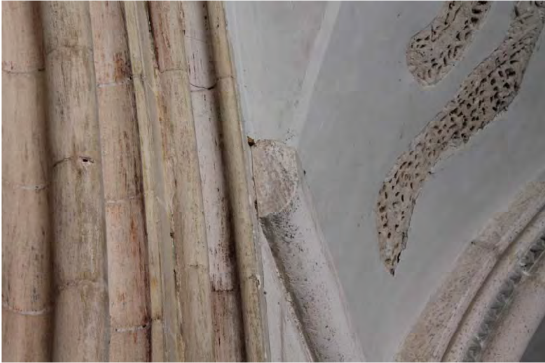
Fig. 591.- Las Huelgas. Claustro de San Fernando. Interrupción de la imposta que recorre los muros perimetrales en su contacto con los vanos de la fachada de la sala capitular
