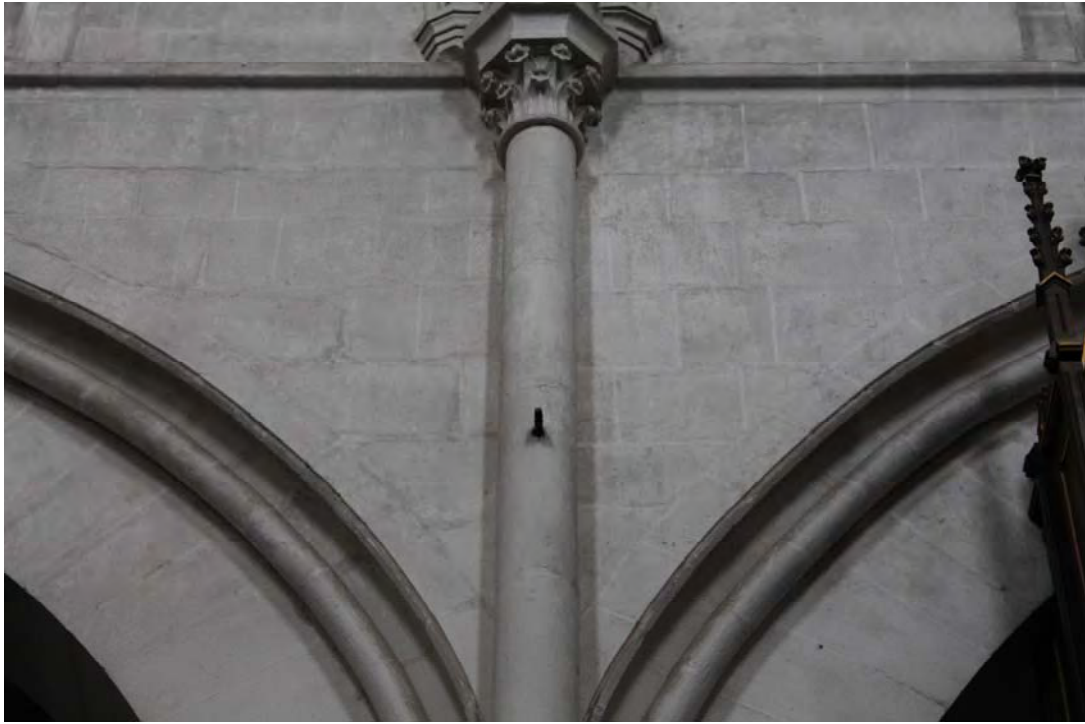
Fig. 317.- Las Huelgas. Iglesia abacial. Salto de hiladas en el enjutado de la arcada septentrional, junto a la columna adosada que marca el paso entre el quinto y el sexto tramos desde el oeste
