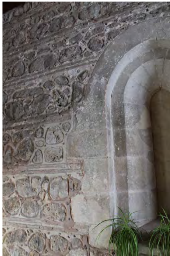
Fig. 760.- Las Huelgas. Capilla del Salvador. Detalle del aparejo del paramento externo del muro septentrional
