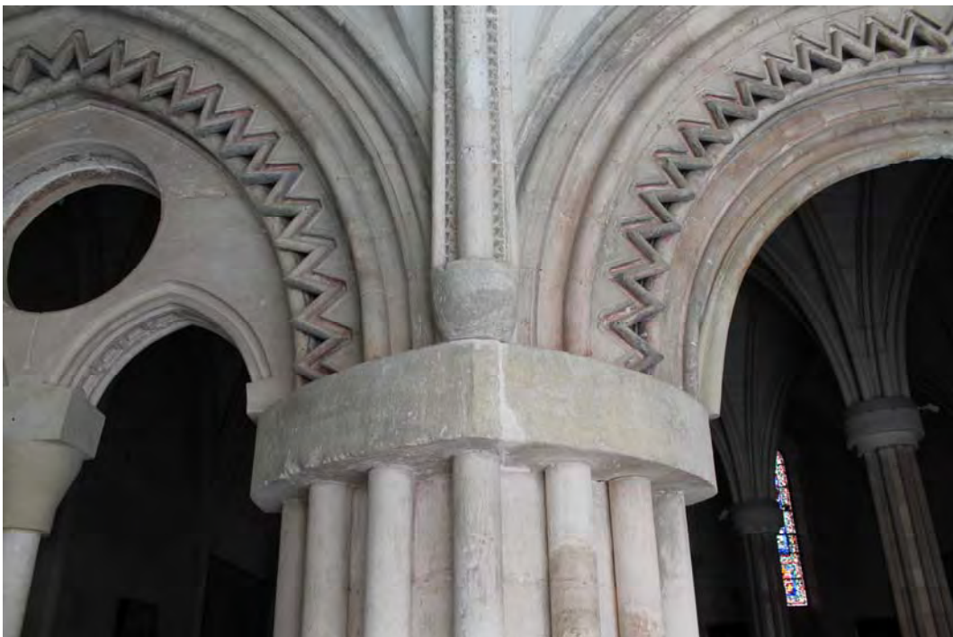
Fig. 588.- Las Huelgas. Claustro de San Fernando. Una de las ménsulas que quedaron sin labrar sobre los dos grandes pilares exentos de la fachada de la sala capitular
