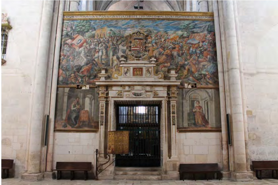
Fig. 279.- Las Huelgas. Iglesia abacial. Muro trazado entre los dos pilares occidentales del crucero, que oblitera parcialmente la embocadura de la nave central
