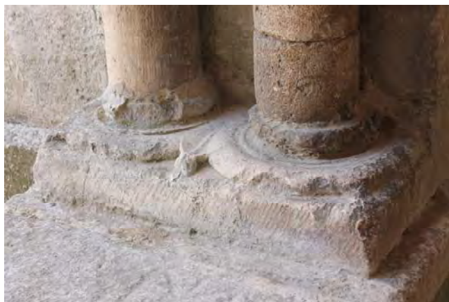
Fig. 808.- Las Huelgas. Pórtico de los Caballeros. Basas con lengüetas de una de las columnas pareadas
