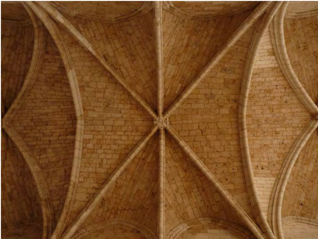
Fig. 490.- Monasterio de Santa María de Huerta. Refectorio. Una de sus bóvedas sexpartitas
