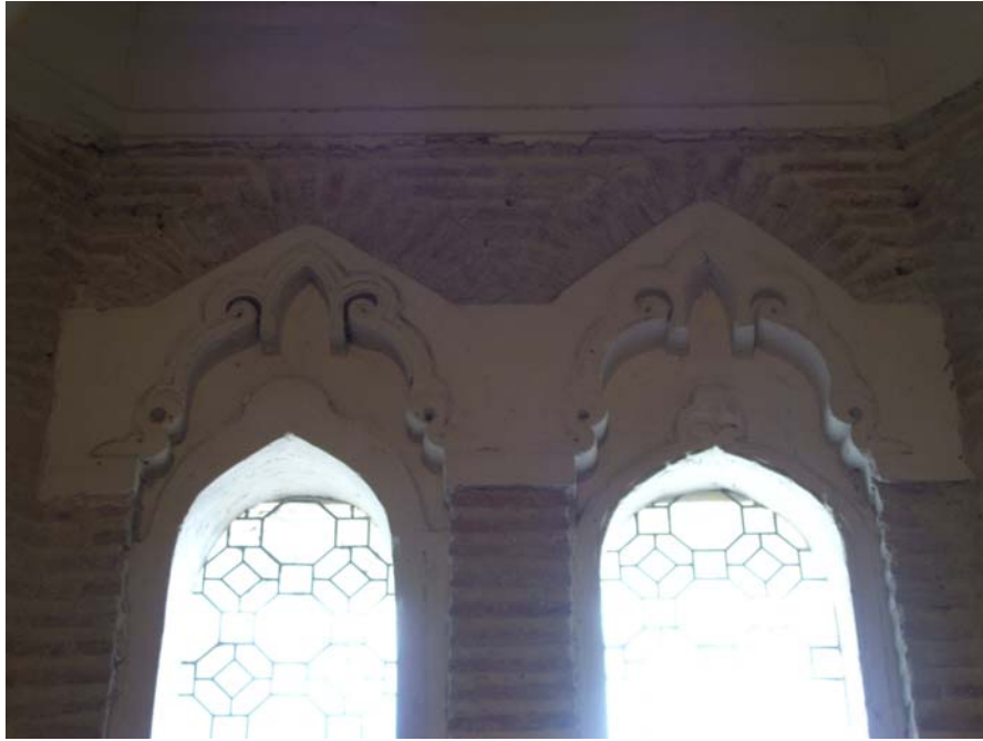
Fig. 127.- Las Huelgas. Capilla de la Asunción. Ventanas del testero oriental, paramento interno
