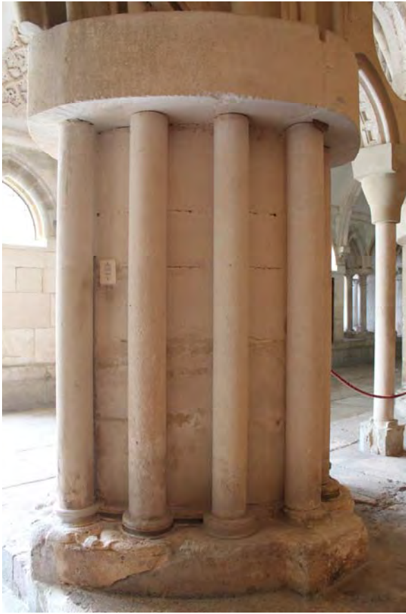
Fig. 653.- Las Huelgas. Sala capitular. Uno de los dos pilares ovoides exentos del centro de la fachada occidental
