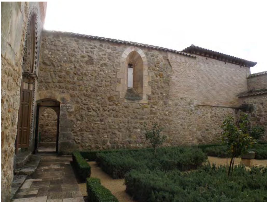
Fig. 776.- Las Huelgas. Capilla del Salvador. Muro sur, paramento interno
