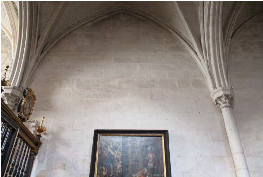
Fig. 354.- Las Huelgas. Iglesia abacial. Uno de los arcos formeros ciegos del muro norte de la nave septentrional
