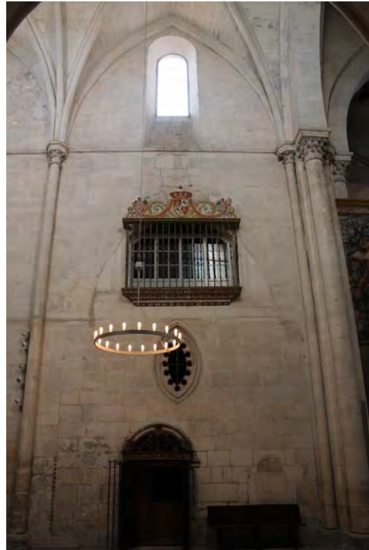
Fig. 276.- Las Huelgas. Iglesia abacial. Vano obliterado de la embocadura de la nave lateral meridional
