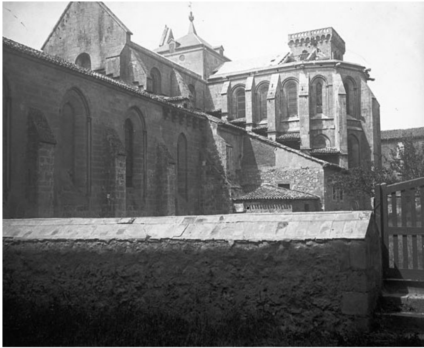
Fig. 213.- Las Huelgas. Iglesia abacial. Antigua fotografía (posterior a 1914) en la que se puede apreciar la estructura adosada a la capilla meridional y la cubierta del templo en obras (© Archivo Municipal de Burgos)
