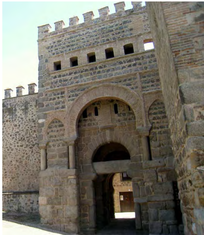
Fig. 84.- Toledo. Puerta Antigua de Bisagra de las murallas de la villa, construida con el mismo tipo de aparejo de mampostería y ladrillo
