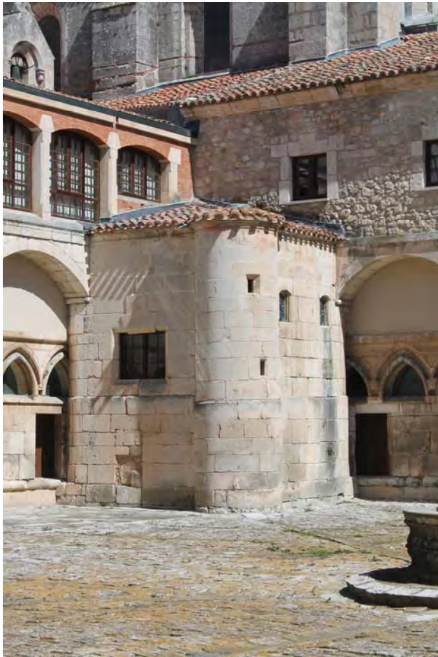
Fig. 575.- Las Huelgas. Claustro de San Fernando. Vista de la capilla de Belén, situada en el esquinazo noreste del patio claustral
