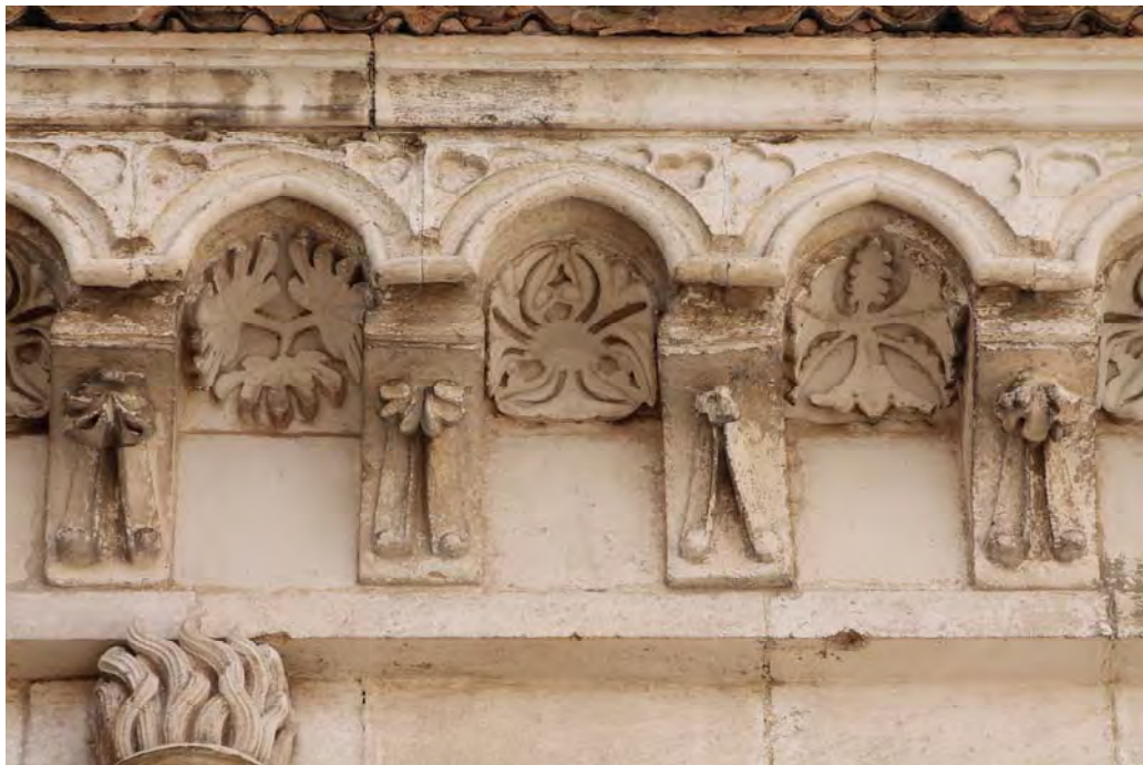
Fig. 837.- Las Huelgas. Vestíbulo. Detalle de la cornisa de la fachada septentrional del tramo que precede la fachada del transepto
