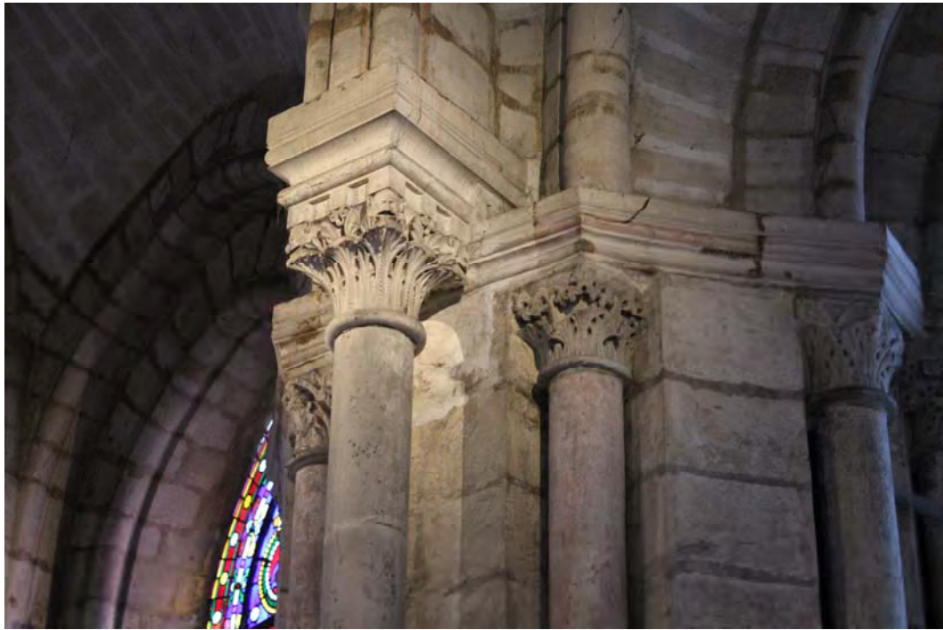
Fig. 467.- Abadía de Saint-Denis. Iglesia abacial. Columnas en délit del deambulatorio
