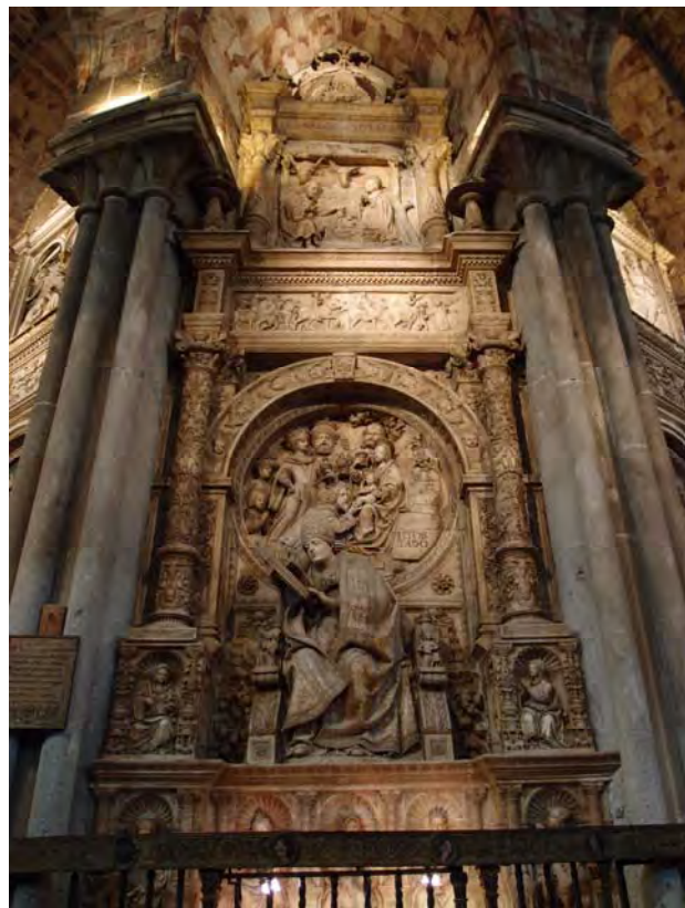
Fig. 478.- Ávila. Catedral. Pilares con columnas en délit que flanquean el trasaltar de la girola
