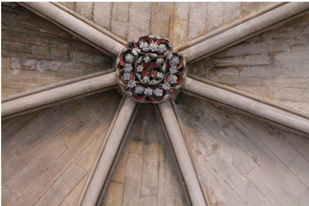
Fig. 224.- Las Huelgas. Iglesia abacial. Clave de bóveda de la misma capilla
