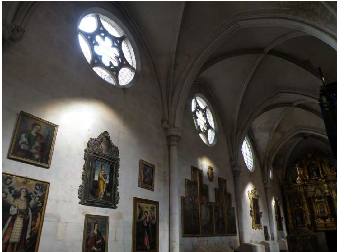
Fig. 351.- Las Huelgas. Iglesia abacial. Bóvedas de los cuatro tramos orientales de la nave septentrional, adaptadas a la altura marcada por los arcos perpiaños
