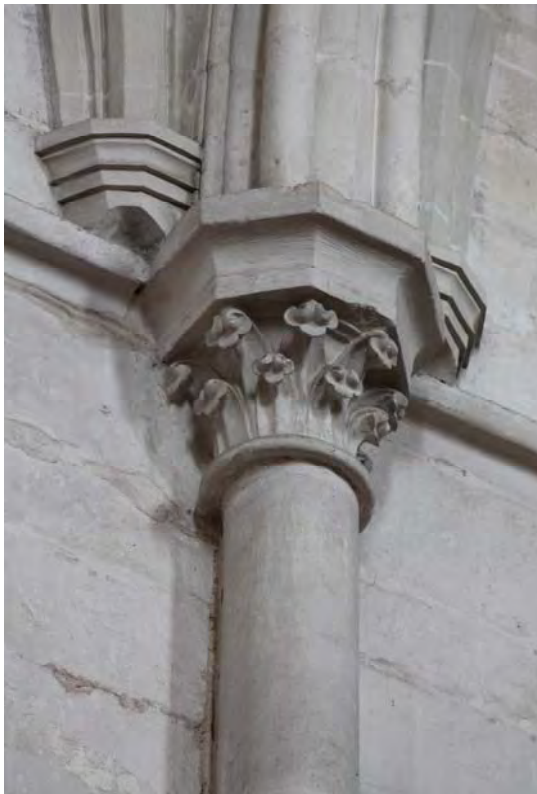
Fig. 311.- Las Huelgas. Iglesia abacial. Ménsulas situadas en la base del nivel del claristorio de la nave central
