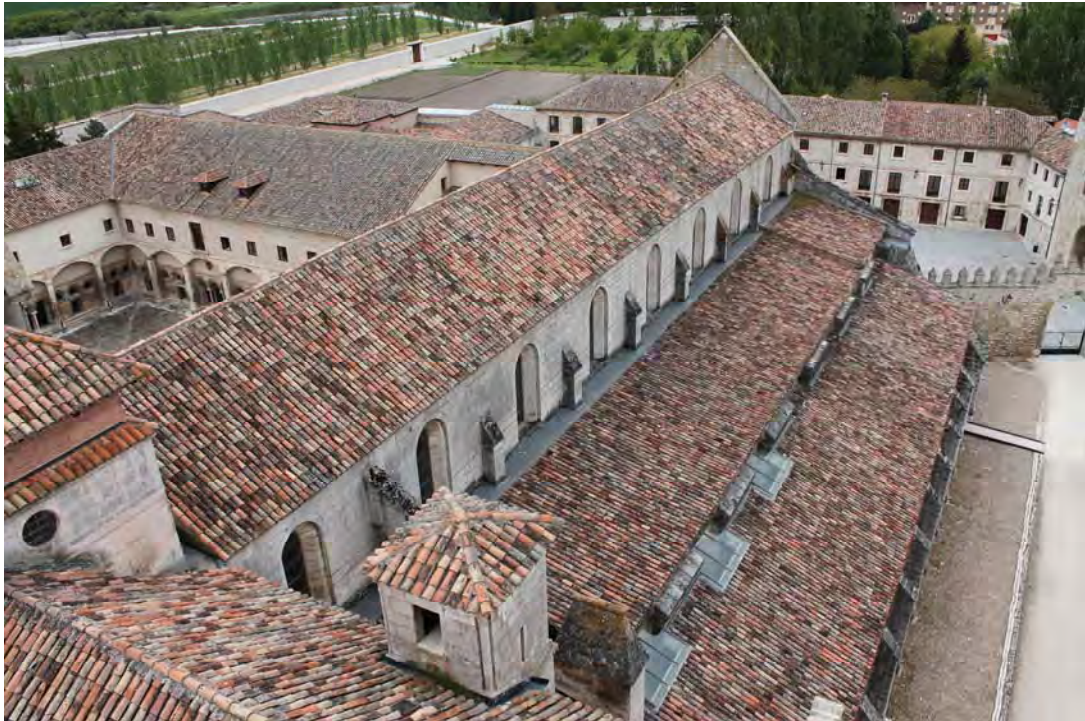
Fig. 318.- Las Huelgas. Iglesia abacial. Vista del flanco septentrional del cuerpo de naves desde la torre, en la que se pueden apreciar los contrafuertes que jalonan el desarrollo del claristorio de la nave central
