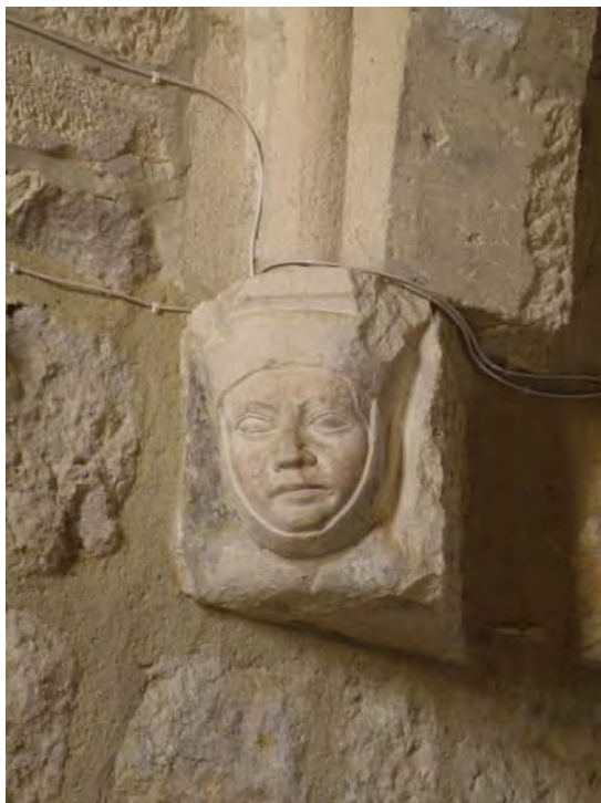
Fig. 792.- Las Huelgas. Capilla de San Martín. Una de las ménsulas antropomorfas de sus muros
