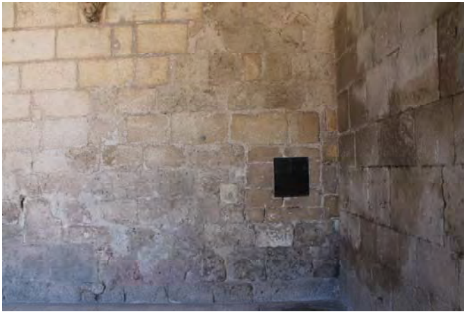
Fig. 371.- Las Huelgas. Pórtico de los Caballeros. Pequeño vano del extremo occidental
