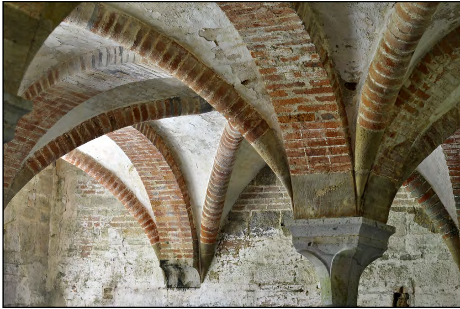
Fig. 89.- L'Escale-Dieu. Sala capitular del cenobio, cuyos abovedamientos fueron construidos con ladrillo
