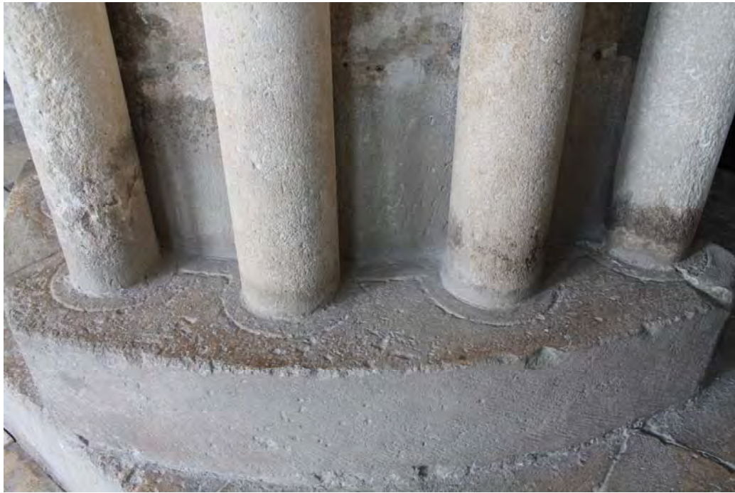
Fig. 680.- Las Huelgas. Sala capitular. Basas sin esculpir del pilar exento meridional de la fachada
