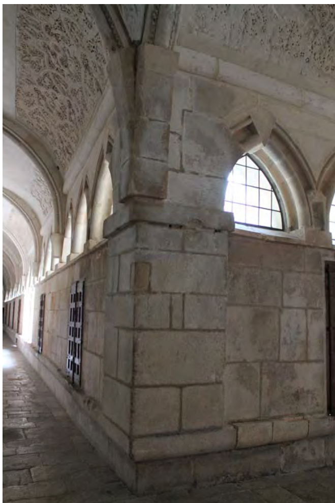
Fig. 570.- Las Huelgas. Claustro de San Fernando. Machón angular noroeste, con los salmeres de la arquería y el arranque de los dos perpiaños que parten de él sin moldurar
