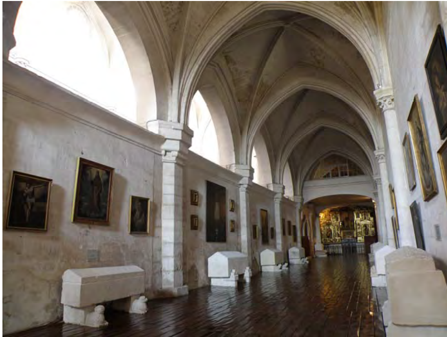
Fig. 391.- Las Huelgas. Iglesia abacial. Vista, en dirección este, de la arquería de arcos formeros que separa la nave meridional de la central
