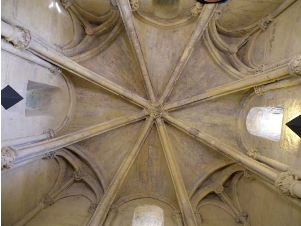
Fig. 511.- Córdoba. Alcázar real. Torre de los Leones. Bóveda de su planta superior
