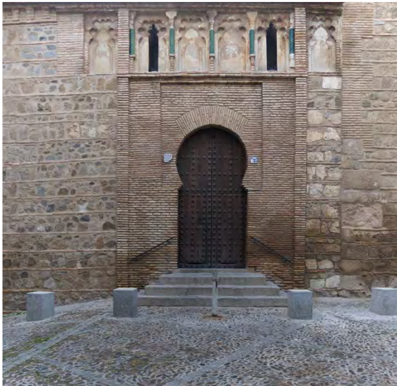
Fig. 86.- Toledo. Iglesia de San Andrés. Fachada principal, con muros de cajones de mampostería y verdugadas de ladrillo
