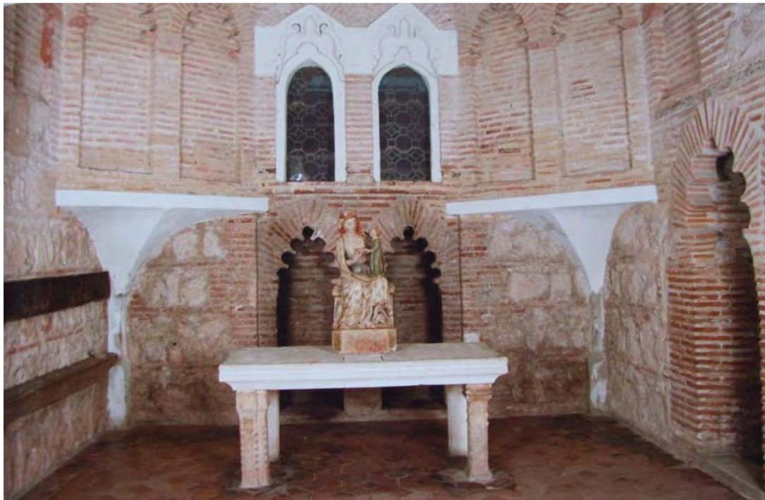
Fig. 120.- Las Huelgas. Capilla de la Asunción. Vista del testero oriental, con las dos trompas que dan paso a la bóveda
