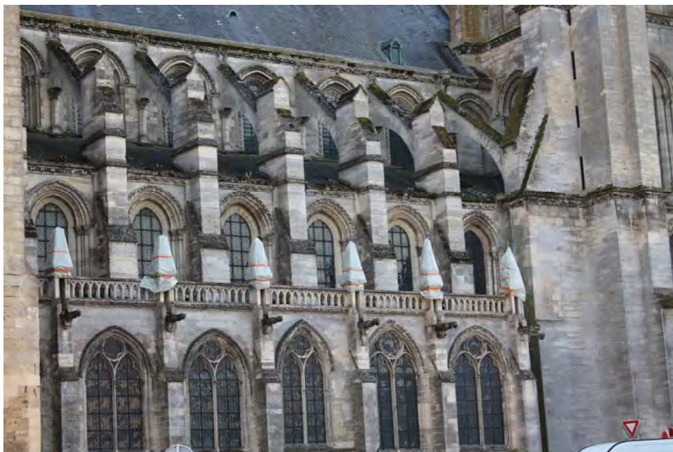
Fig. 208.- Laon. Catedral. Contrafuertes del cuerpo de naves
