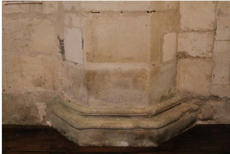
Fig. 304.- Las Huelgas. Iglesia abacial. Única basa moldurada de los pilares octogonales de la arcada meridional
