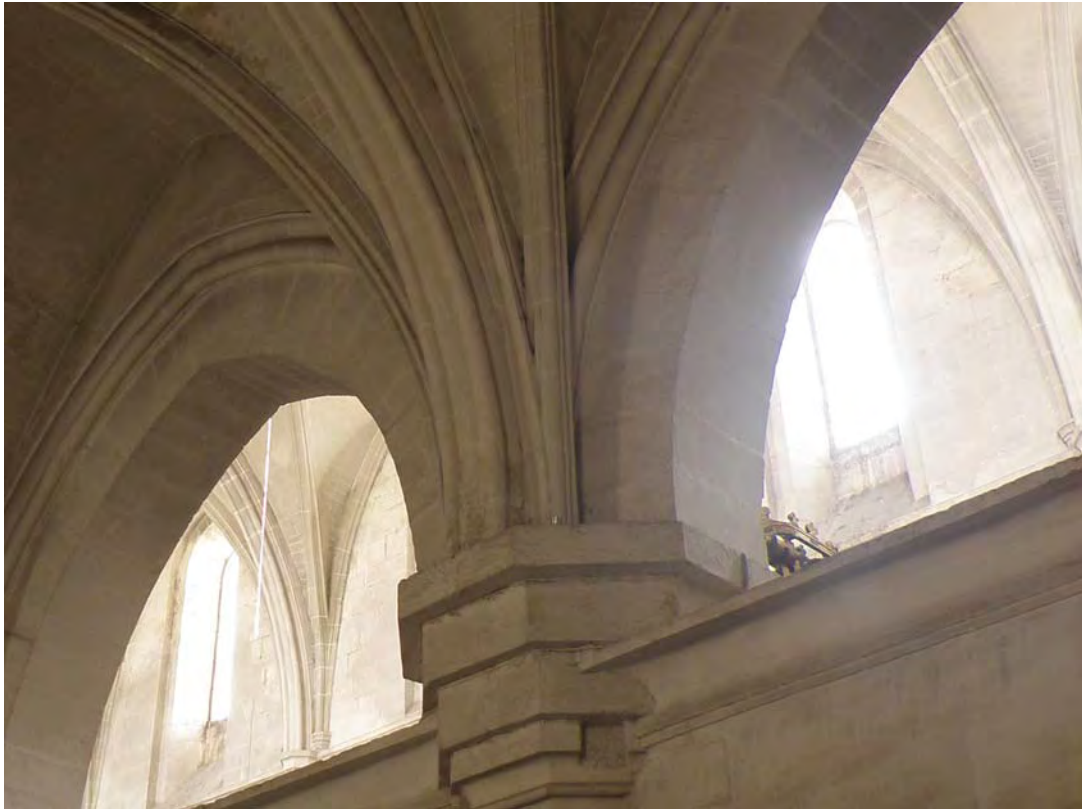
Fig. 555.- Las Huelgas. Iglesia abacial. Detalle del arranque de uno de los abovedamientos de la nave septentrional, en el que se puede apreciar que los nervios diagonales no están enjarjados con los arcos perpiaños y formeros
