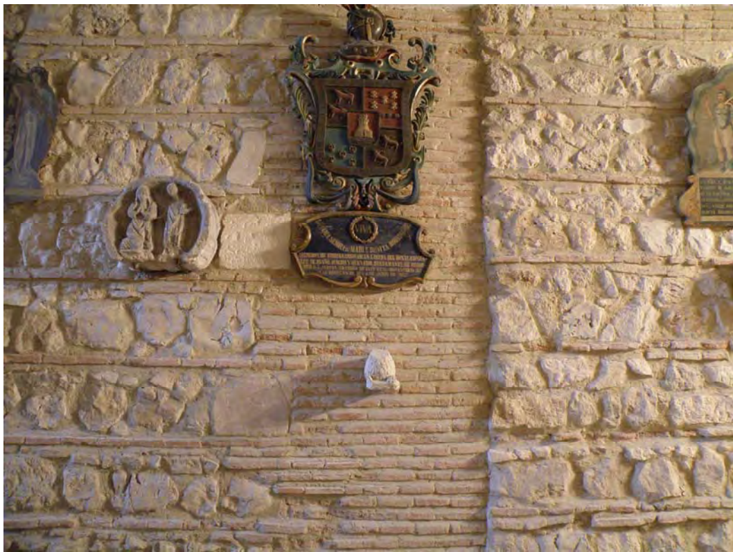
Fig. 696.- Las Huelgas. Pasaje. Corte en el aparejo de su muro meridional
