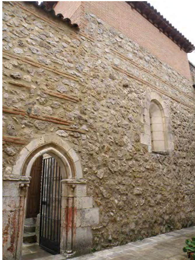
Fig. 762.- Las Huelgas. Capilla del Salvador. Paramento externo de su muro meridional
