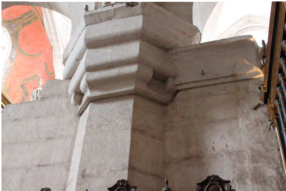
Fig. 303.- Las Huelgas. Iglesia abacial. Bloque superior de uno de los pilares octogonales de las arcadas de las naves
