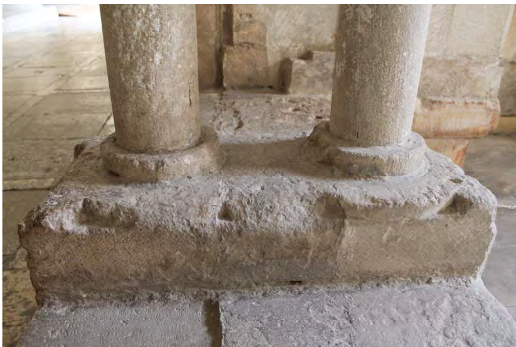
Fig. 577.- Las Huelgas. Claustro de San Fernando. Plintos y basas de las columnas originales conservadas en la capilla de Belén
