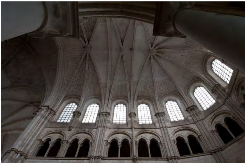
Fig. 488.- Abadía de Vézelay. Bóvedas de la capilla mayor, que incluyen un tramo sexpartito
