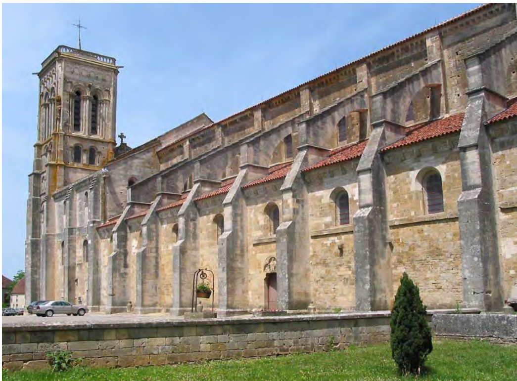
Fig. 330.- Abadía de Vézelay. Arbotantes del cuerpo de naves
