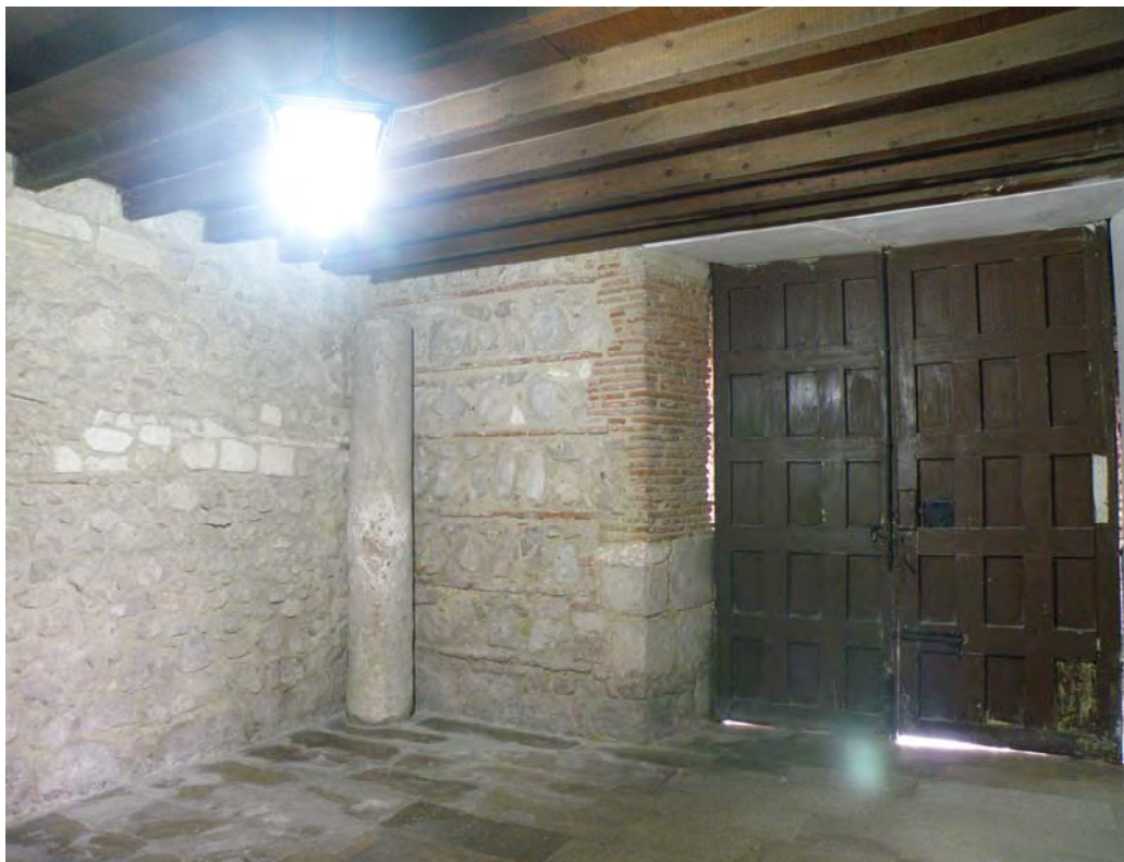
Fig. 162.- Las Huelgas. Claustro de Las Claustillas. Estancia del pabellón norte que antecede a la capilla de la Asunción
