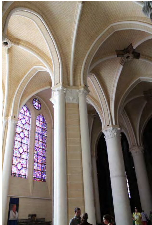
Fig. 474.- Chartres. Catedral. Uno de los pilares con columnas en délit de la girola
