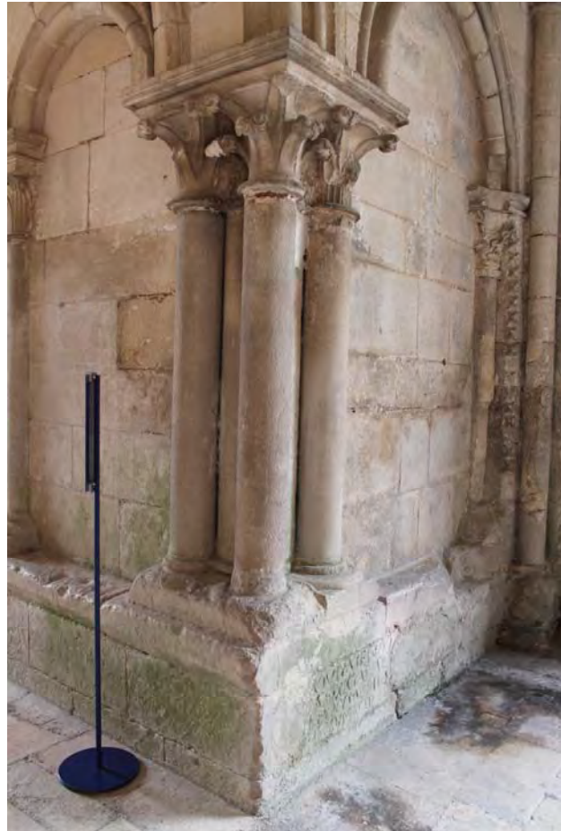
Fig. 832.- Las Huelgas. Vestíbulo. Machón angular ubicado en la confluencia del tramo que precede la fachada del transepto y del tramo rectangular cubierto con bóveda de cañón apuntado
