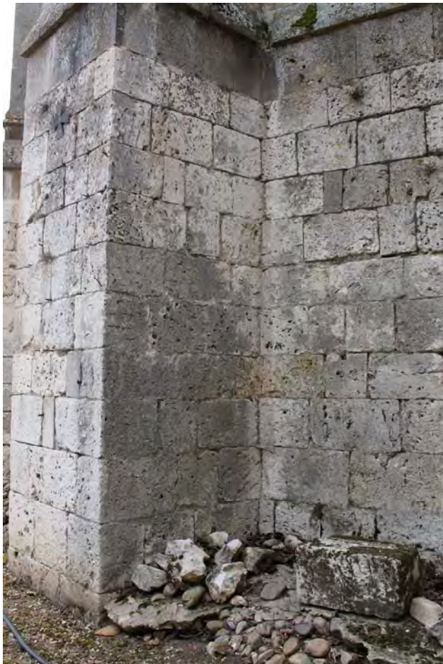
Fig. 210.- Las Huelgas. Iglesia abacial. Perfecta trabazón y regularidad de hiladas existentes entre los cuatro contrafuertes restantes del ábside y los paños del mismo
