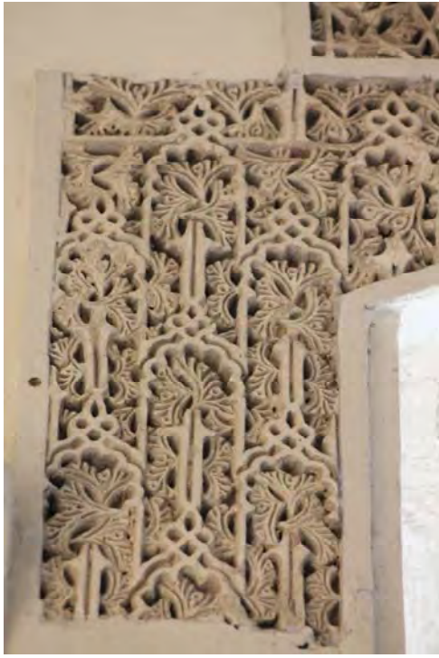
Fig. 686.- Las Huelgas. Locutorio. Detalle de las yeserías del arco escarzano oriental
