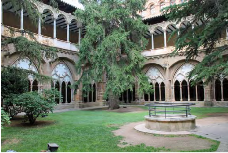
Fig. 92.- Veruela. Claustro reglar, vista general
