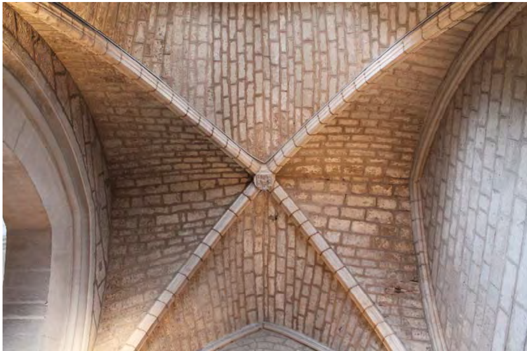
Fig. 374.- Las Huelgas. Iglesia abacial. Bóveda del tramo occidental de la nave sur
