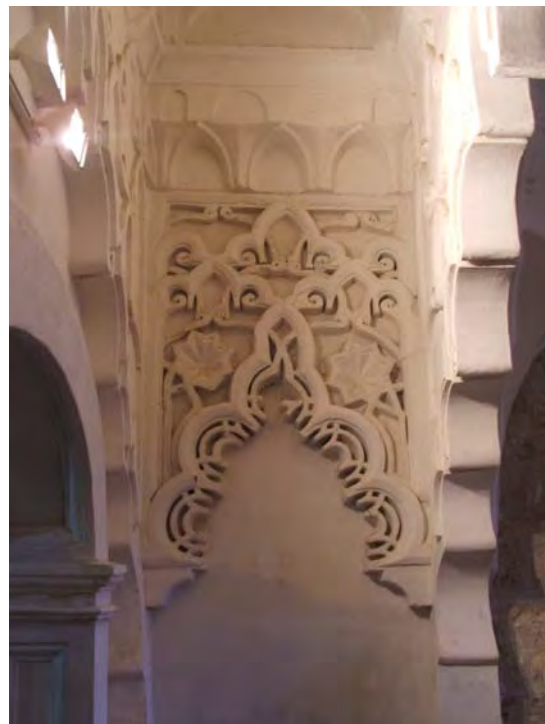
Fig. 141.- Las Huelgas. Capilla de la Asunción. Labor de yesería del testero septentrional del vestíbulo occidental
