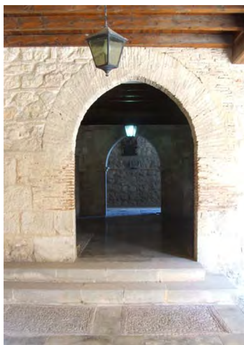
Fig. 168.- Las Huelgas. Claustro de Las Claustrillas. Puerta meridional de la estancia de la fig. 166, que comunica con el esquinazo sureste del claustro
