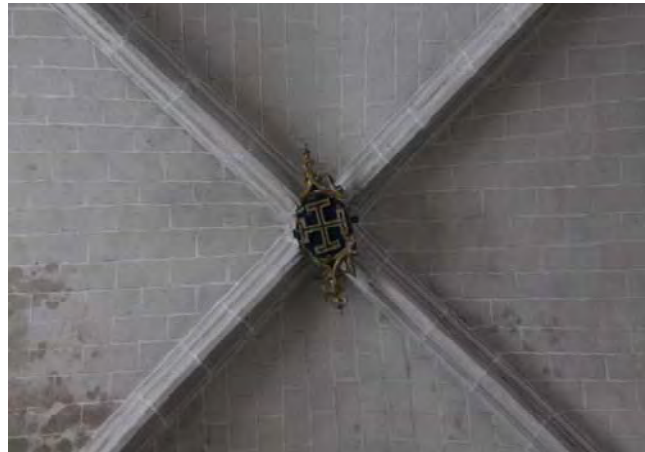
Fig. 350.- Las Huelgas. Iglesia abacial. Clave de bóveda del tramo oriental de la nave septentrional
