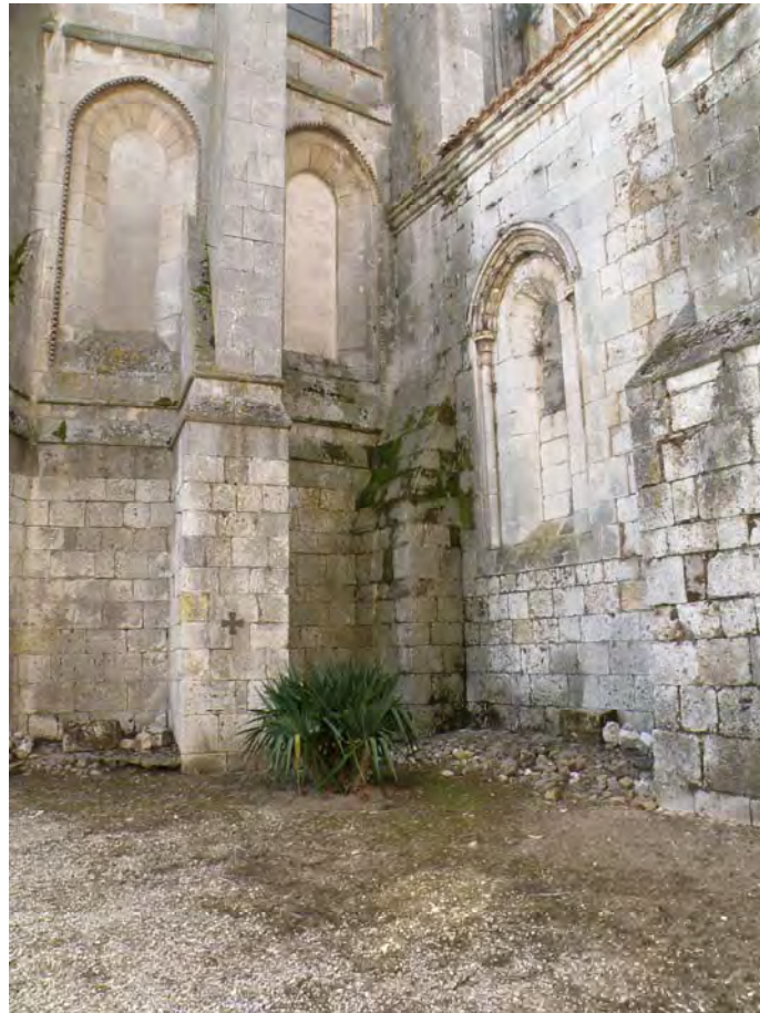
Fig. 207.- Las Huelgas. Iglesia abacial. Arranque del costado norte del heptágono absidal. Pequeño contrafuerte de refuerzo que apoya contra el testero de la capilla lateral adyacente a la mayor
