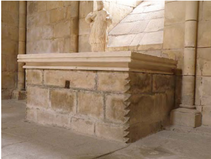
Fig. 240.- Las Huelgas. Iglesia abacial. Altar original de la capilla lateral septentrional
