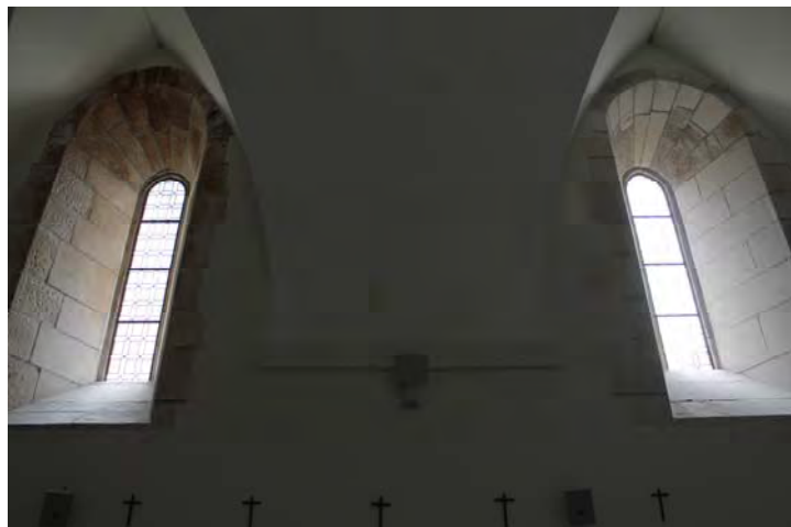
Fig. 703.- Las Huelgas. Cocina. Muro meridional
