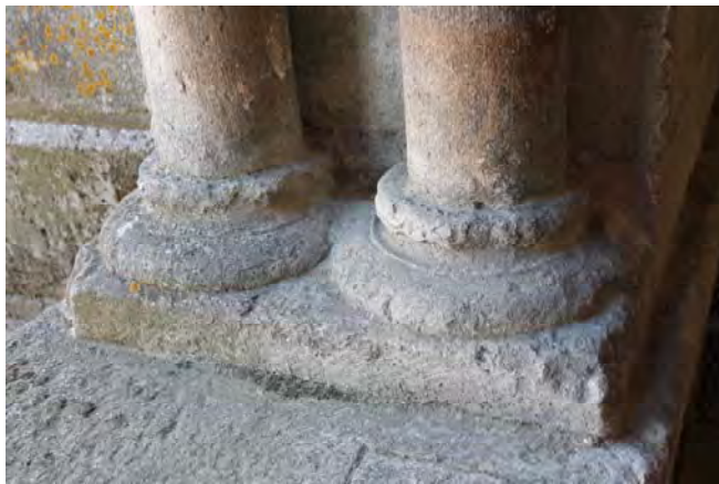
Fig. 807.- Las Huelgas. Pórtico de los Caballeros. Basas sin lengüetas de una de las columnas pareadas
