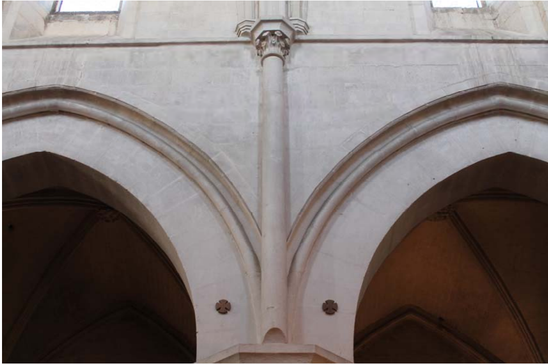
Fig. 308.- Las Huelgas. Iglesia abacial. Columnas superpuestas a los pilares octogonales, que se extienden hasta el nivel del claristorio
