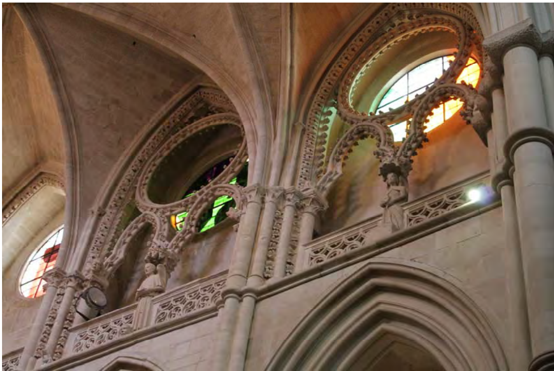
Fig. 428.- Cuenca. Catedral. Claristorio de la nave central, con su falso triforio
