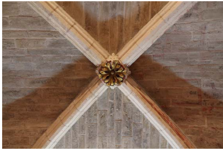
Fig. 376.- Las Huelgas. Iglesia abacial. Clave de bóveda del tramo oriental de la nave sur
