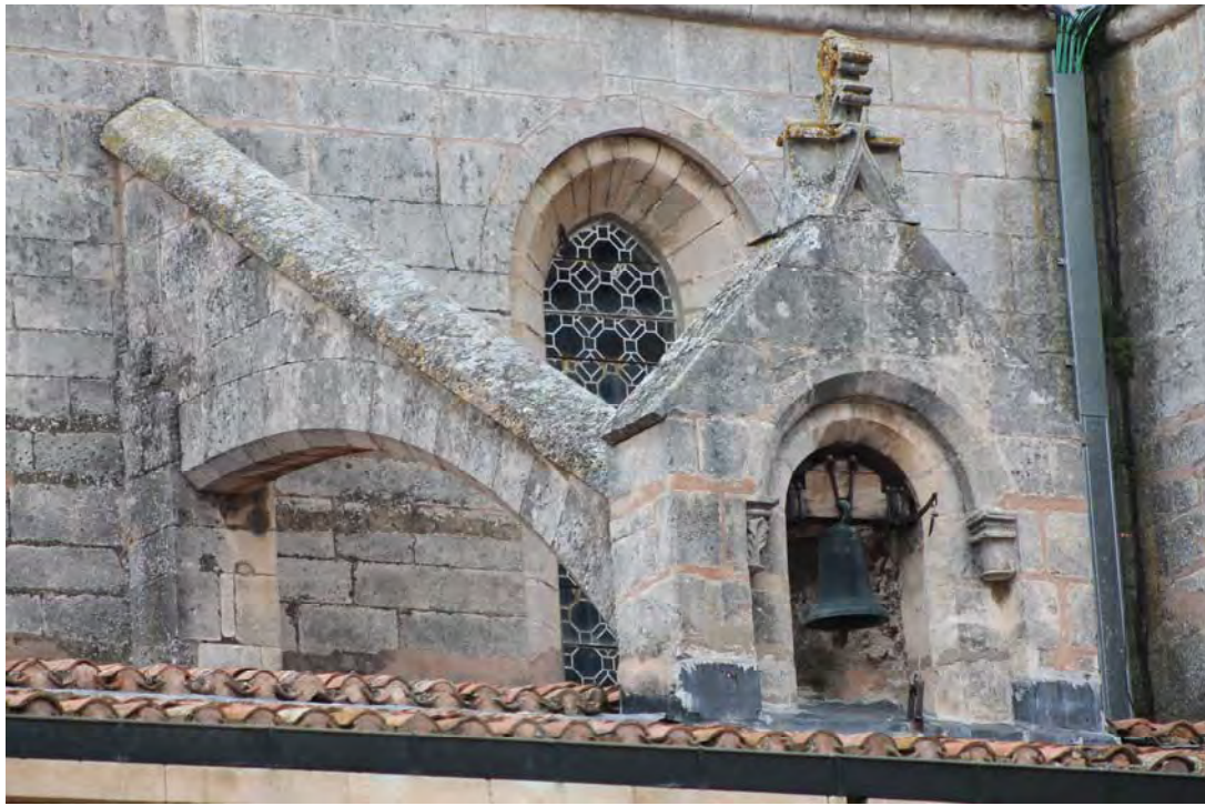
Fig. 321.- Las Huelgas. Iglesia abacial. Arbotante meridional
