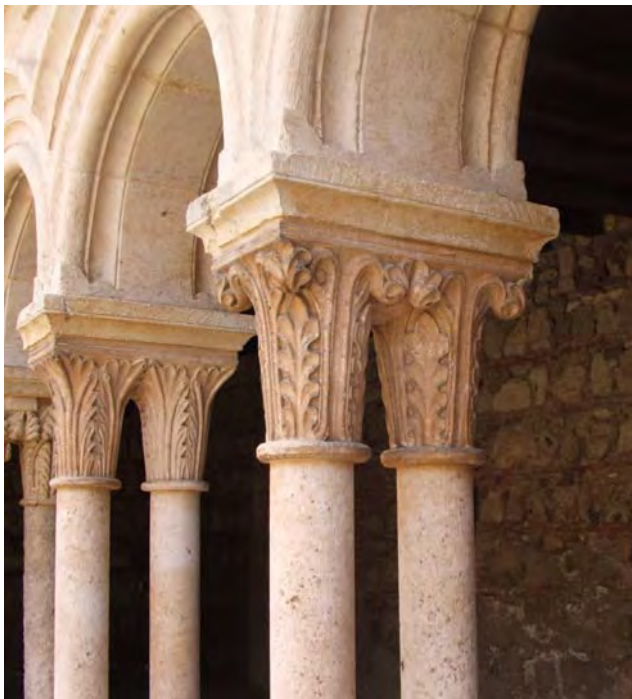
Fig. 98.- Las Huelgas. Claustro de Las Claustrillas. Las dos columnas y capiteles dobles de la galería sur rehechos durante las restauraciones del siglo XX
