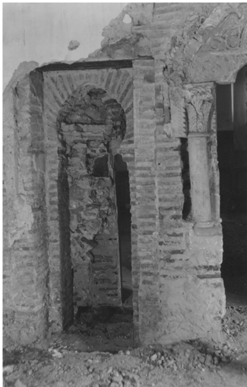
Fig. 153.- Las Huelgas. Capilla de la Asunción. Paramento externo del muro sur desde la estancia contigua, durante los trabajos de restauración (© IPCE, Fototeca del Patrimonio Artístico, Archivo Moreno)
