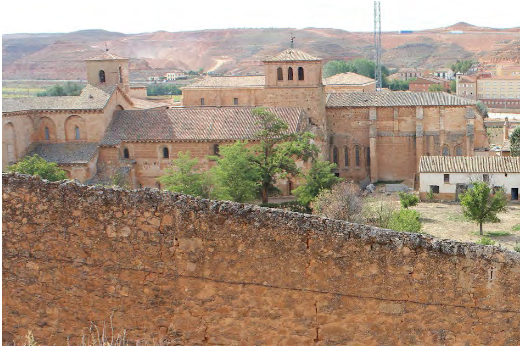
Fig. 515.- Monasterio de Santa María de Huerta. Vista general desde el este, donde se puede apreciar los dos tipos de contrafuertes del refectorio
