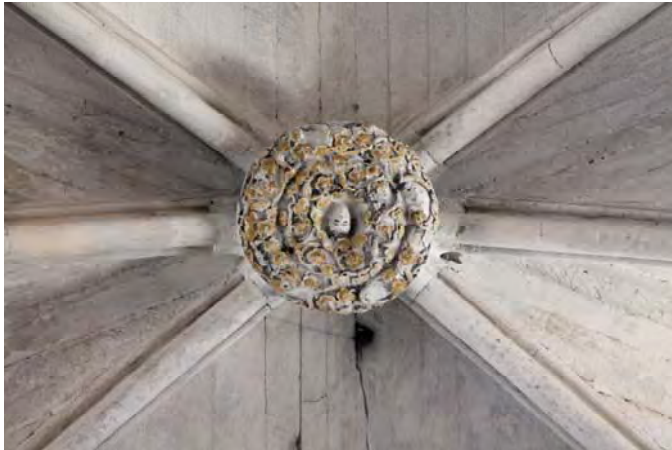
Fig. 184.- Las Huelgas. Iglesia abacial. Clave de la bóveda del tramo oriental del presbiterio
