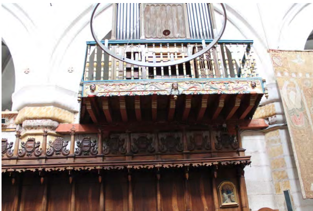
Fig. 566.- Las Huelgas. Iglesia abacial. Viga existente entre dos de los pilares octogonales, encajada en los mechinales de éstos, que sirve para sostener la tribuna del órgano
