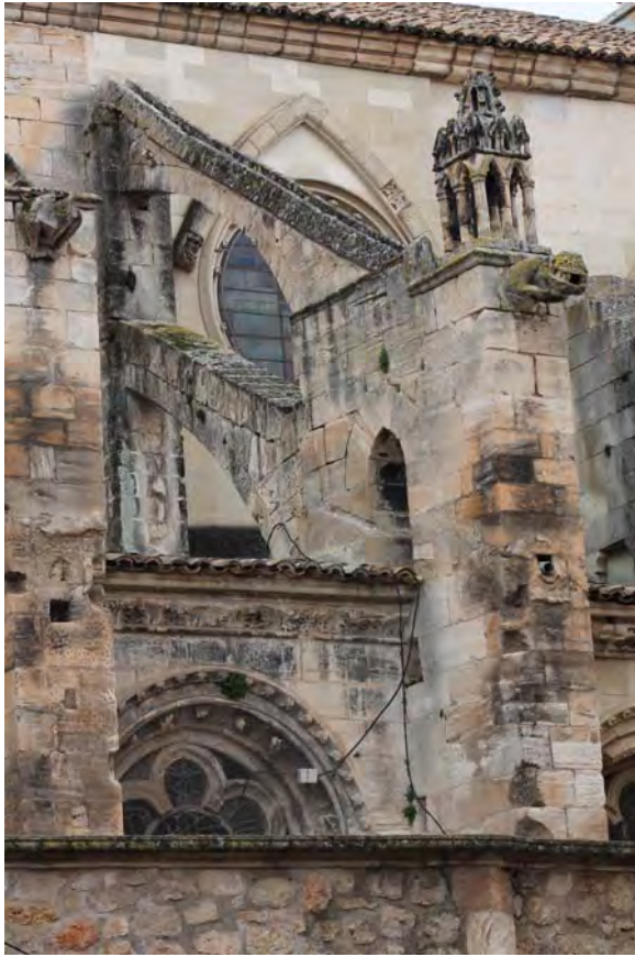
Fig. 327.- Cuenca. Catedral. Arbotante doble del cuerpo de naves
