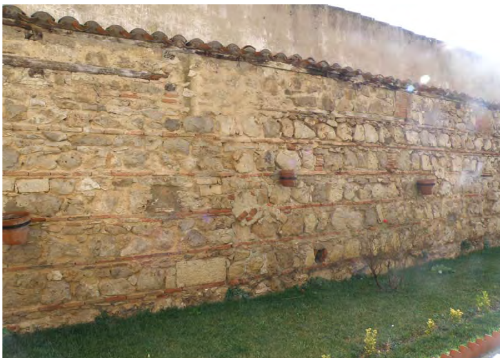
Fig. 35.- Las Huelgas. Claustro de Las Claustrillas. Paramento externo de la panda occidental. Detalle del aparejo, formado por mampostería y verdugadas de ladrillo
