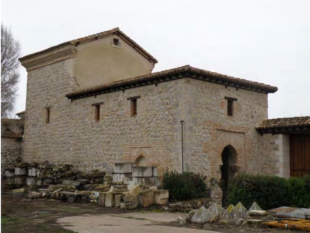
Fig. 873.- Las Huelgas. Capilla de Santiago. Muro septentrional
