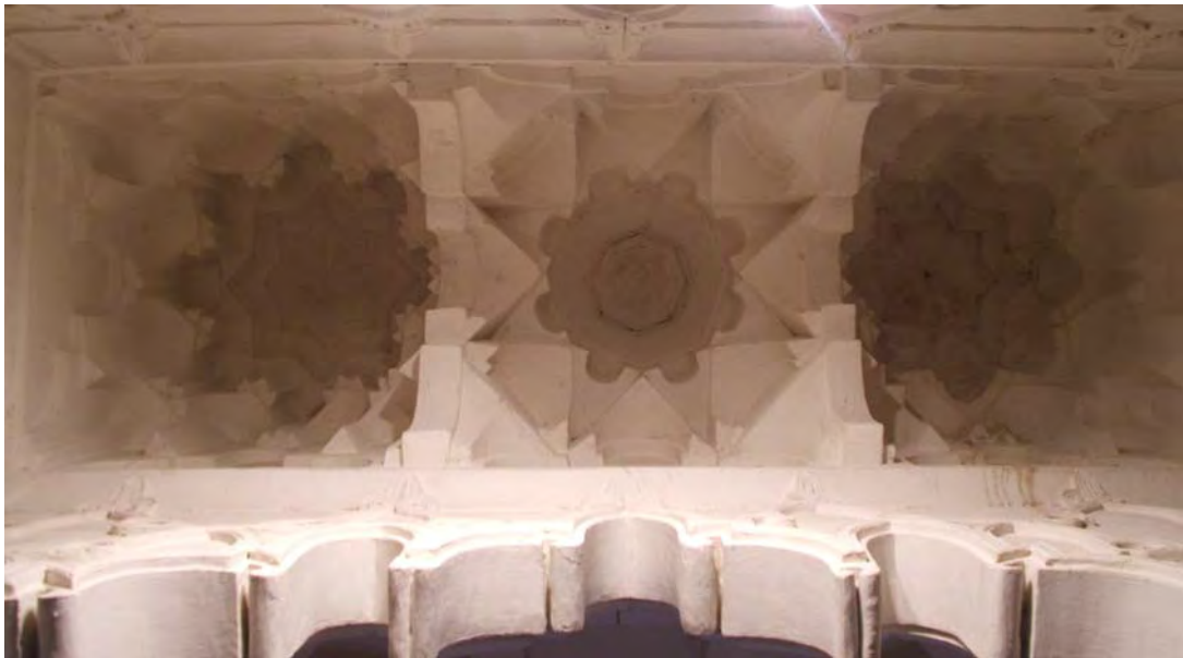
Fig. 137.- Las Huelgas. Capilla de la Asunción. Las tres cupulitas de mocárabes que cubren el vestíbulo occidental de la capilla, la central de menor altura que las laterales
