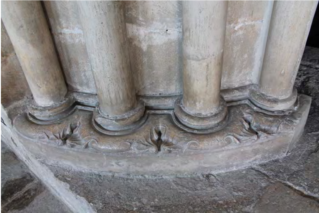
Fig. 678.- Las Huelgas. Sala capitular. Basas trabajadas del pilar adosado al extremo septentrional de la fachada
