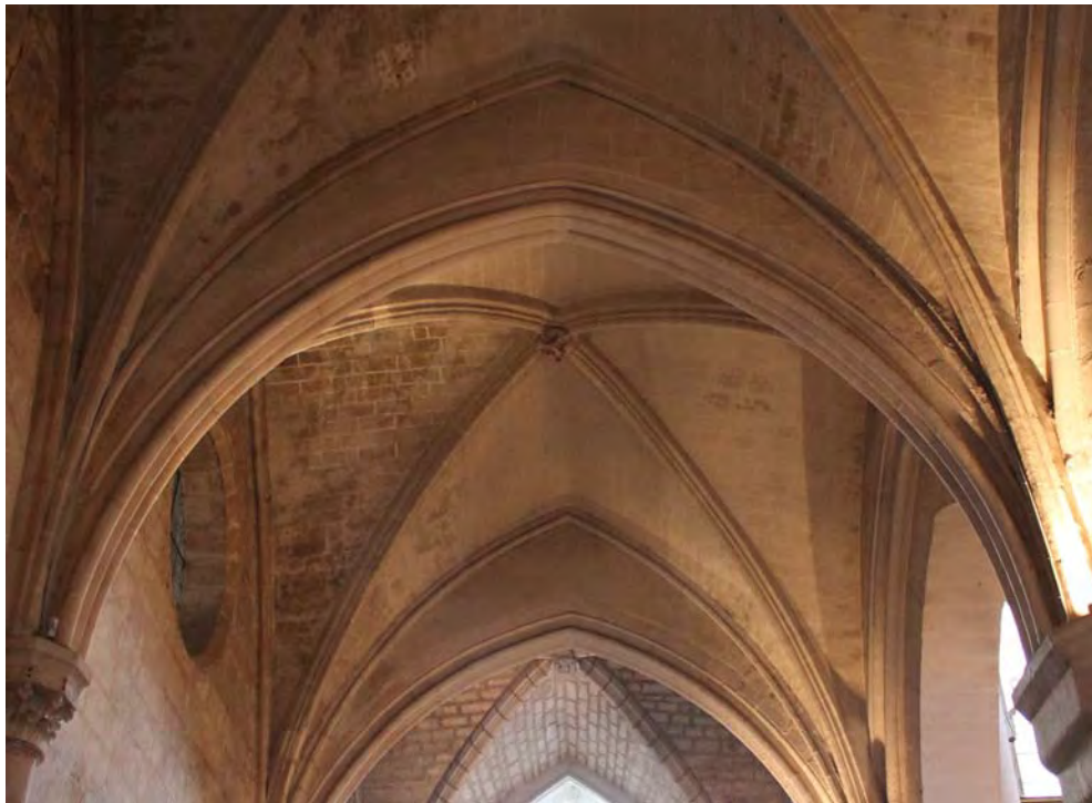
Fig. 390.- Las Huelgas. Iglesia abacial. Paños alzados sobre los arcos perpiaños para permitir la sobreelevación de las bóvedas de los tramos occidentales de la nave meridional
