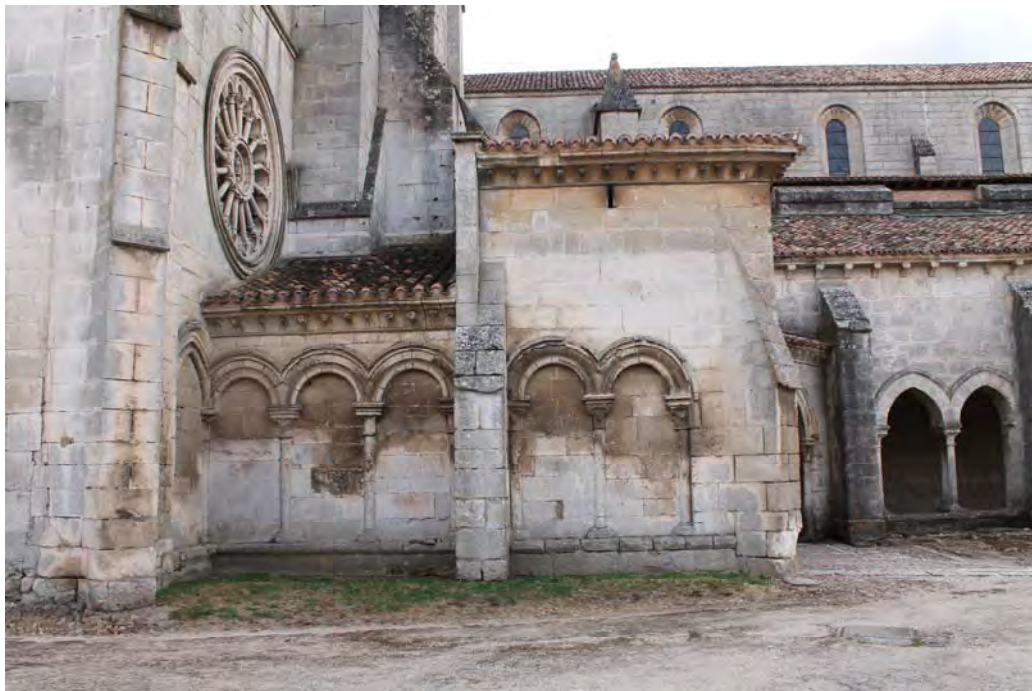
Fig. 827.- Las Huelgas. Vestíbulo. Flanco septentrional de los dos cuerpos arquitectónicos que conforman su sector occidental
