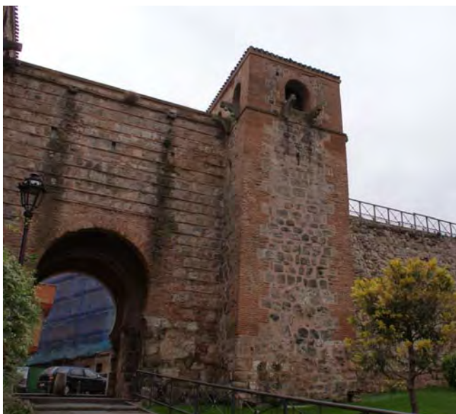
Fig. 82.- Burgos. Puerta de San Esteban de la cerca muraria de la ciudad, con aparejo de mampostería y verdugadas de ladrillo
