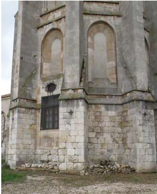
Fig. 218.- Las Huelgas. Iglesia abacial. Vista del paño central del ábside, perforado por los nuevos vanos barrocos a manera de transparente
