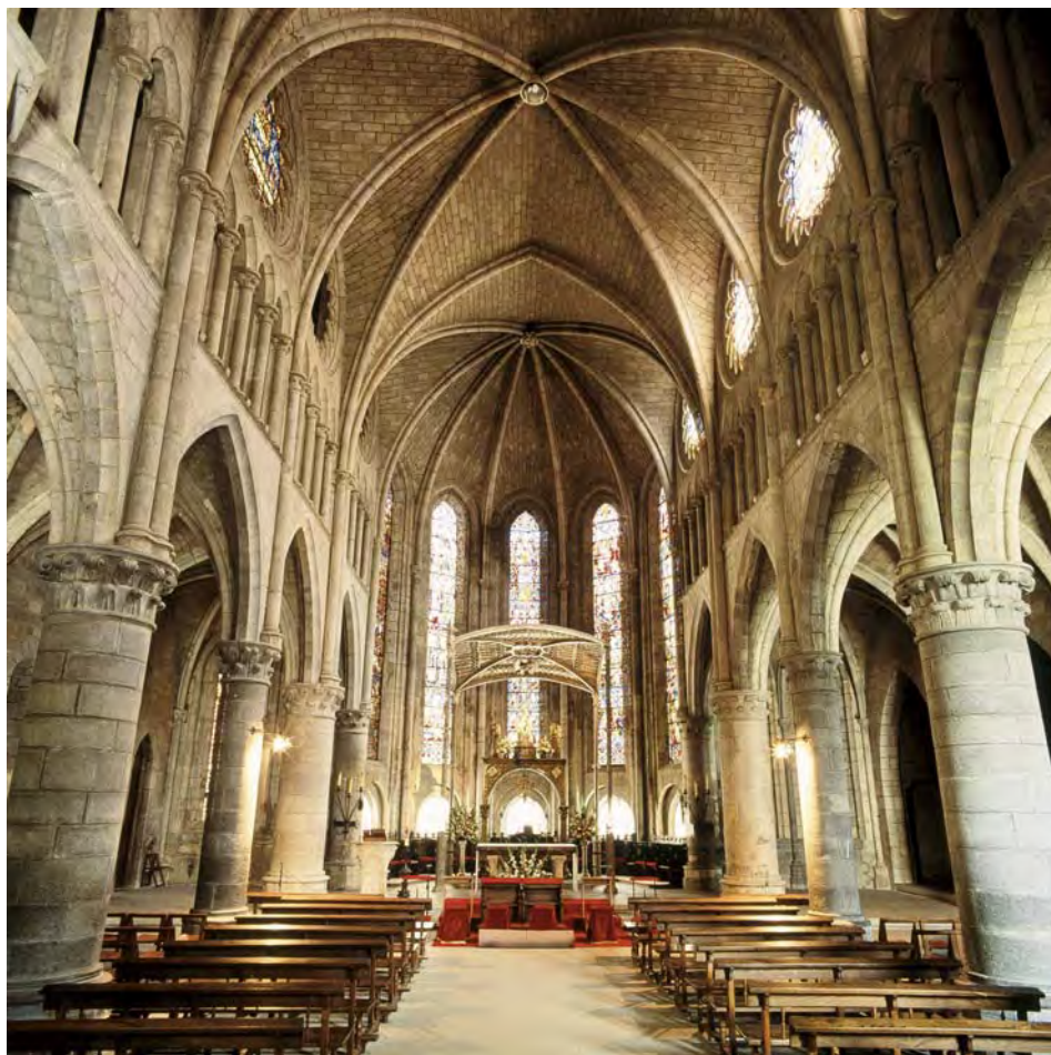
Fig. 494.- Roncesvalles. Colegiata de Santa María, cubierta con bóvedas sexpartitas
