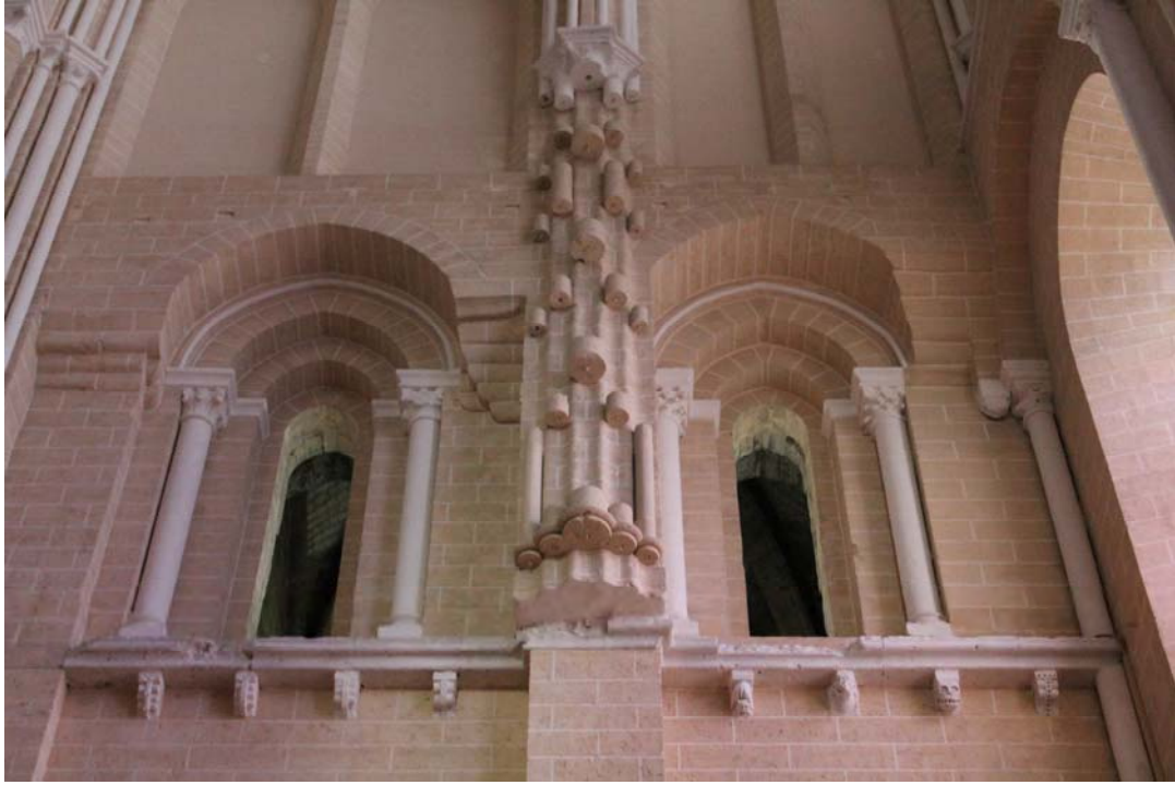
Fig. 475.- Chartres. Catedral. Pilares inacabados con columnas en délit de los muros del extremo occidental del templo
