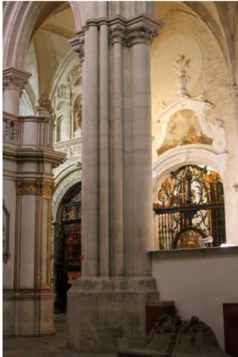
Fig. 536.- Cuenca. Catedral. Uno de los pilares fasciculados de la arcada meridional del cuerpo de naves
