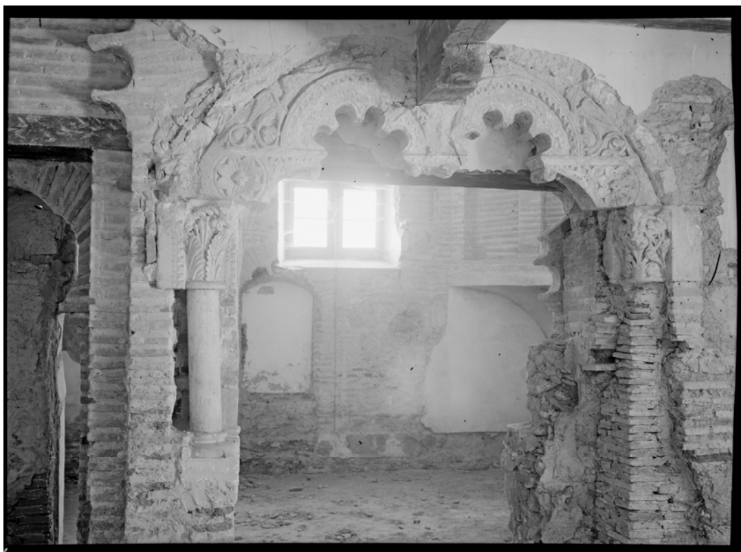
Fig. 151.- Las Huelgas. Capilla de la Asunción. Fotografía antigua tomada desde la estancia contigua a la capilla durante los trabajos de restauración de la década de 1940 (© IPCE, Fototeca del Patrimonio Artístico, Archivo Moreno)
