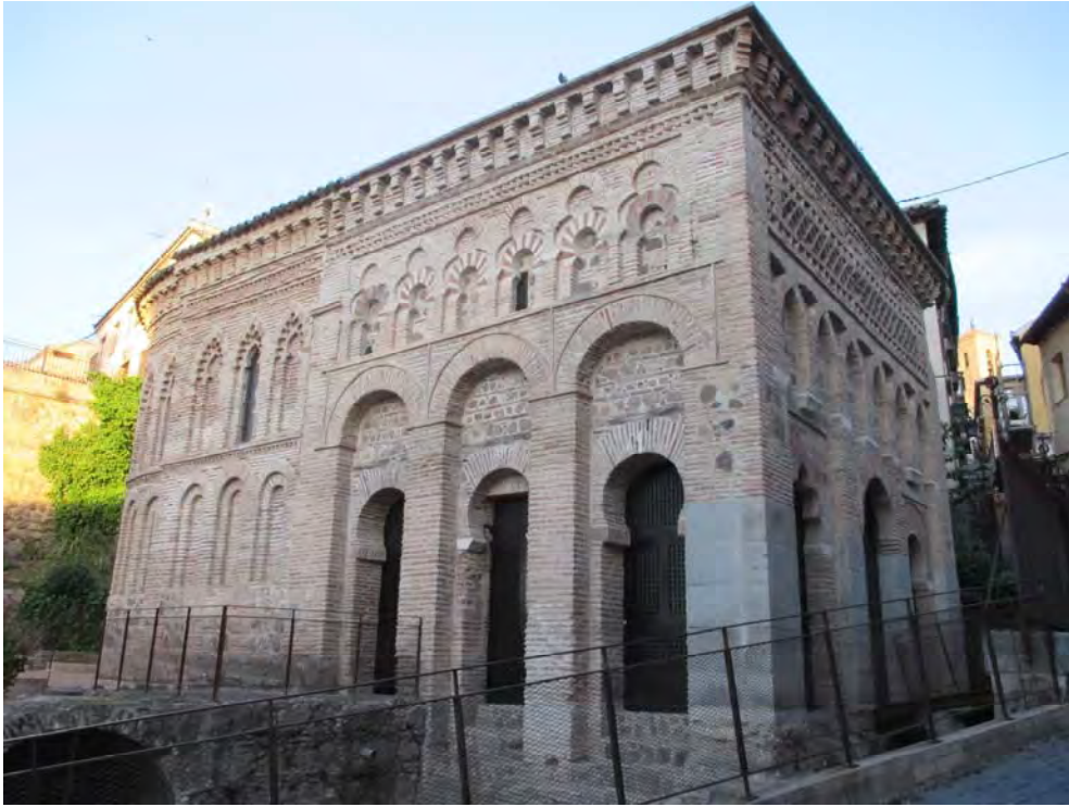
Fig. 83.- Toledo. Mezquita de Bab-al-Mardum, cuyos muros emplean el típico aparejo de cajas de mampostería delimitadas por verdugadas de ladrillo
