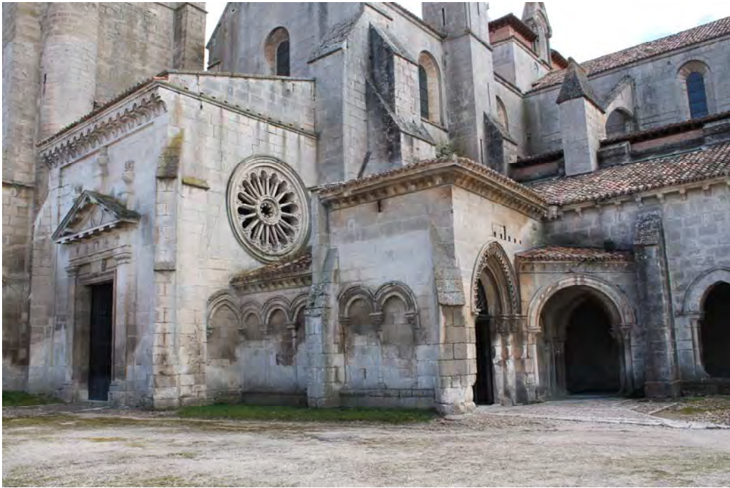
Fig. 821.- Las Huelgas. Vestíbulo, visto desde el noroeste
