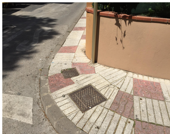
Imatge 15 : VORERES AMB DIMENSIONS INFERIORS A 1,50M Font : Pròpia
