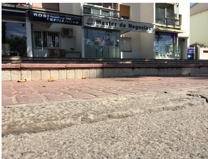
Imatge 42 : ACTUACIÓ SOBRE 1,20M QUE DONEN A CALÇADA A L'AVINGUDA CASTELL D'ARO. Font : pròpia
