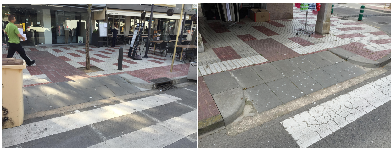
Imatges 17 i 18 : INCOMPLIMENT DISSENY DE GUALS A LA VINGUDA SAGARÓ (AVSA05E) I CARRER MIRAMAR (CMI01P). Font : pròpia
