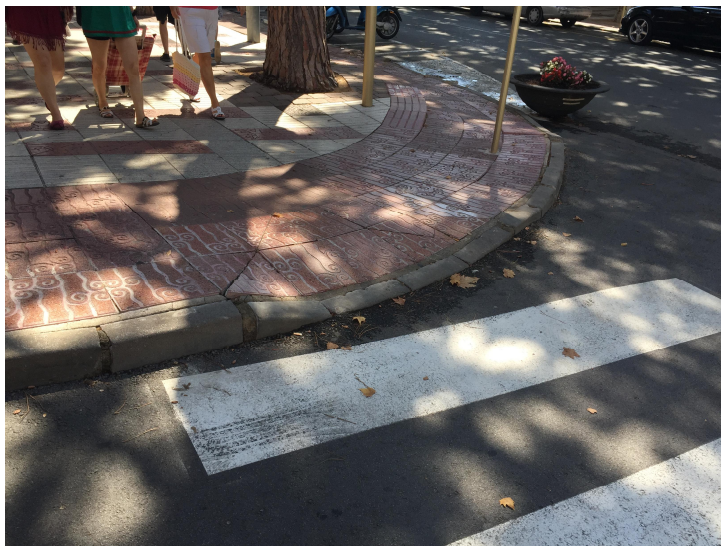
Imatge 16 : INCOMPLIMENT DE TIPOLOGIA DE GUAL A LA VINGUDA CASTELL D'ARO (AVCA04D) Font : Pròpia
