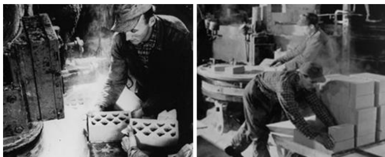
FIG. 69 i 70: Imatges històriques de la producció de Kalksandsteine un cop iniciat el procés industrial.
