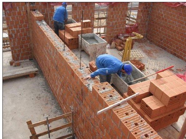
FIG.15 : Les parets interiors, ja siguin resistents o no, es realitzen també en termoargila.
