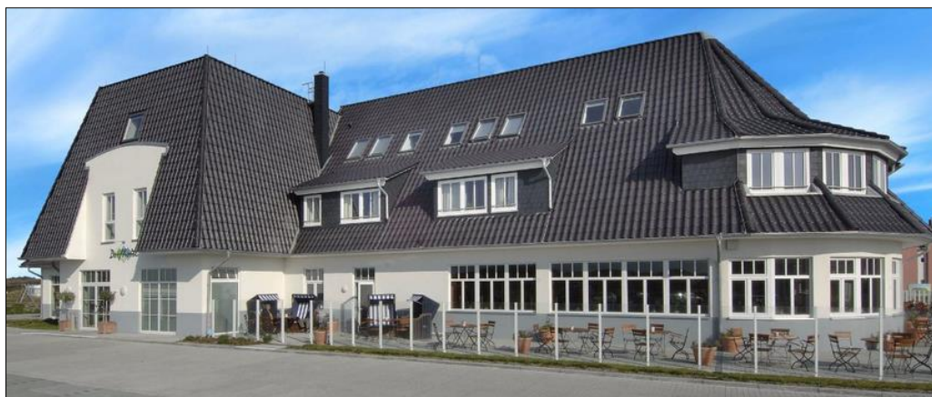
FIG. 72: Hotel construït amb façana de Kalksandstein.
