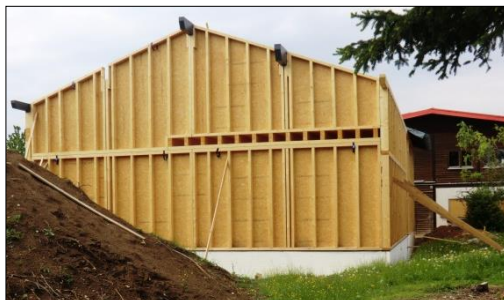
FIG.100: Vista de la façana lateral d'un habitatge unifamiliar, on s'observen els marcs de fusta prefabricats on encara no s'hi ha posat l'aïllament tèrmic, a Altheim/Alb.
