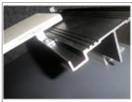
FIG.62 i 63 : Detall d'ancoratge fixat a la subestructura.
