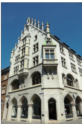
FIG. 117: Imatge d'un dels edificis històrics de la ciutat d'Ulm, realitzat amb pedra natural . Font: Fotografia pròpia
