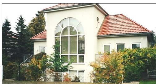
FIG. 122: L'habitatge unifamiliar anterior ha estat acabat i pintat, i no s'aprecia que ha estat construïda amb els sistema de peces de poliestirè. Font: Styro Stone
