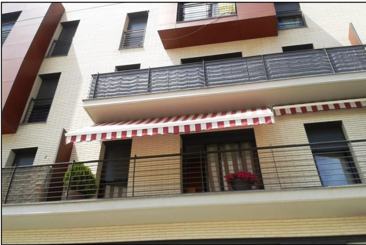
FIG.43: Detall de façana de maó silici-calcari d'edifici residencial situat a la població de Tordera.
