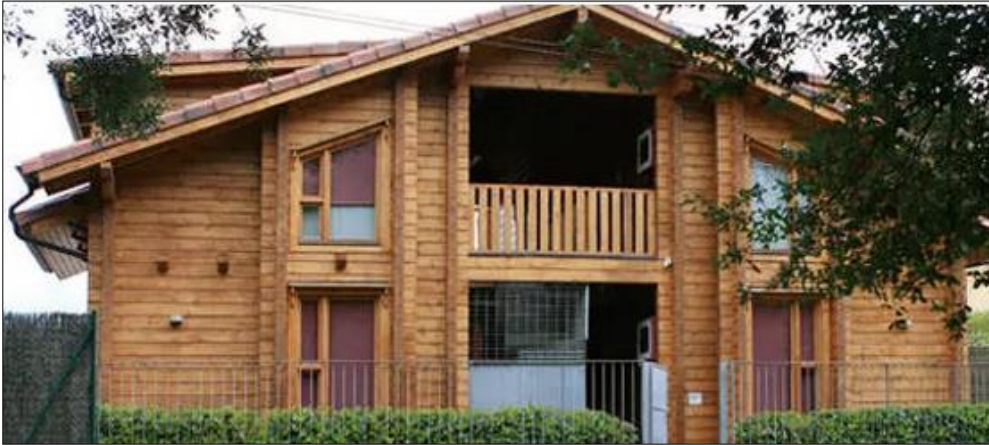
FIG.46: Hotel construït amb façana de fusta, situat al baix Montseny.
