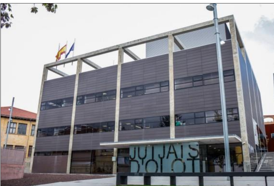
FIG.9: Imatge de la façana principal dels jutjats d'Olot, amb el sistema de façana ventilada i revestiment ceràmic, en aquest cas de color fosc.
