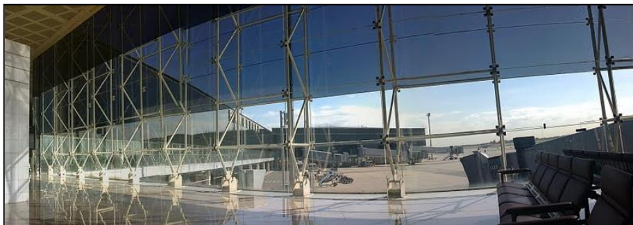
FIG.73: Façana de mur cortina amb el sistema “spider”, característic de la terminal 2 de l'aeroport de Barcelona. Font: Panoramio
