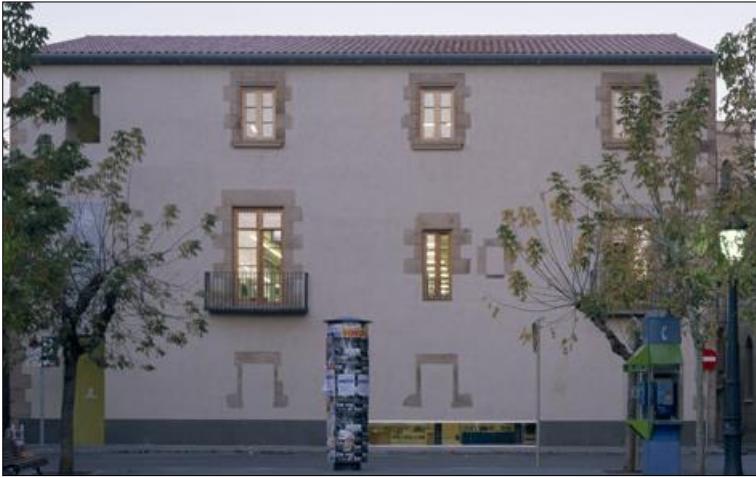
FIG.34: Façana de la Biblioteca Can Pedrals. Font: RGA Arauitectes
