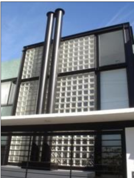
FIG.85: Façana construïda amb estructura metàl·lica i tancament amb blocs de pavès.
