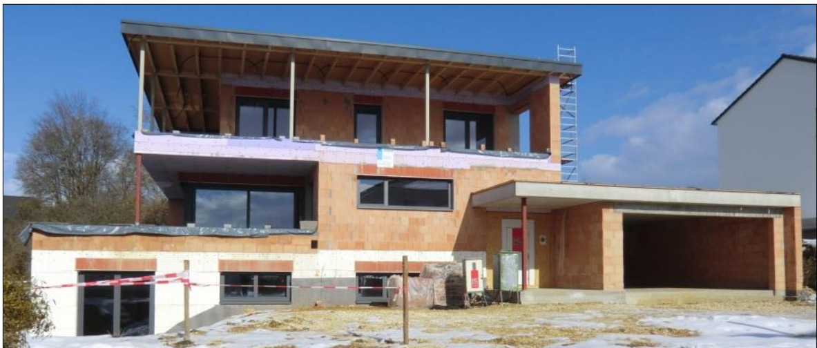
FIG. 26: Casa unifamiliar construïda amb estructura metàl·lica i i parets de tancament de bloc de termoargila a la zona d'Alb Donau Kreis.
