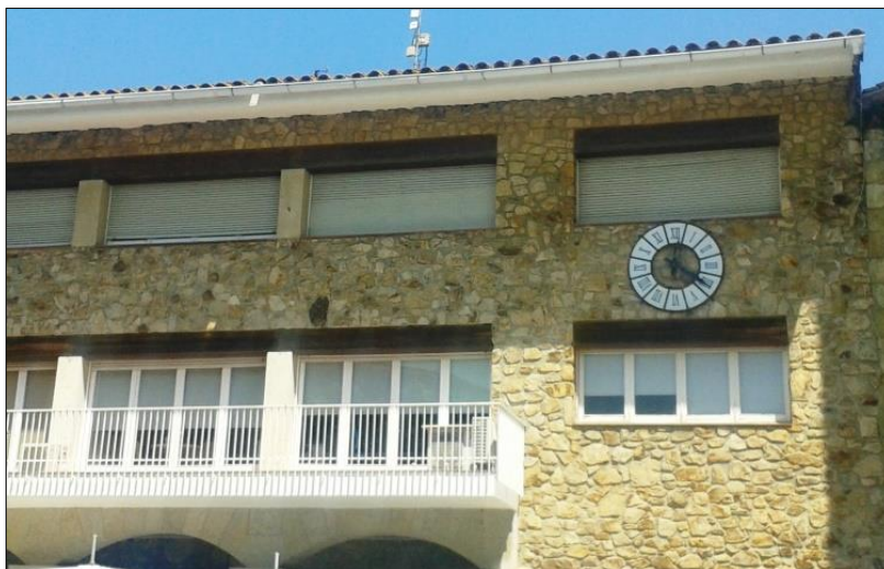
FIG.54: Fotografia d'una casa revestida amb pedra natural en la seva totalitat. És adherida amb morter.
