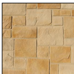
FIG. 11: Detall de revestiment de pedra artificial.
