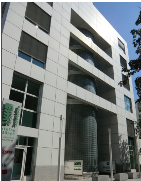
FIG. 145: Edifici d'ús administratiu a Augsburg realitzat amb façana ventilada i l'escala principal envoltada de forma circular amb blocs de vidre quadrats de tipus transparent.
