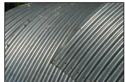
FIG. 31: Imatge de planxes metàl·liques ondulades.
