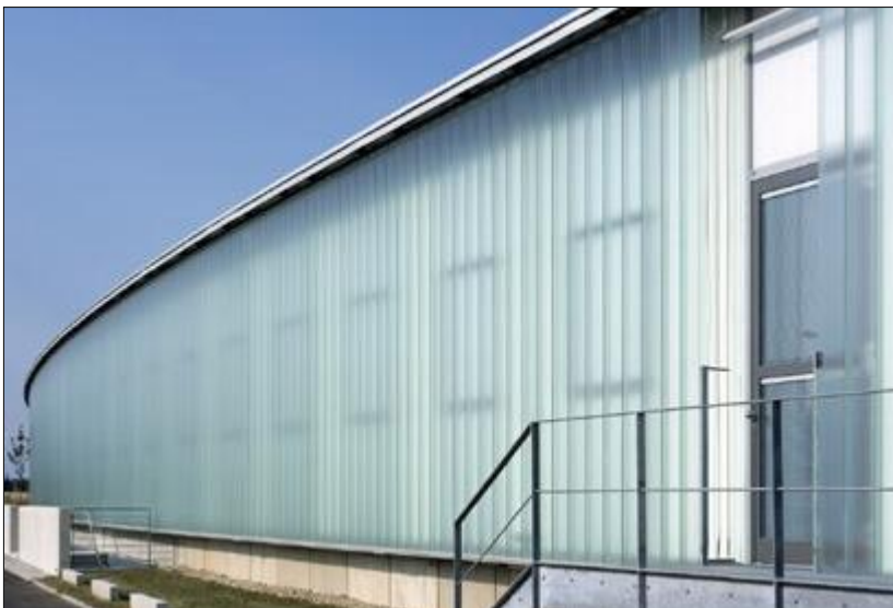
FIG. 139: Centre esportiu Am Utzweg, a Unterhaching, amb la façana construïda amb U-Glass.
