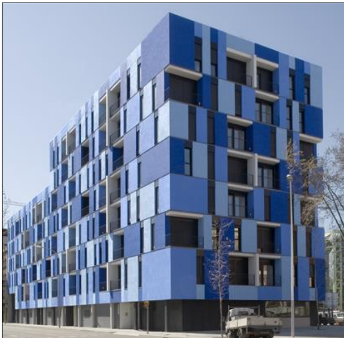
FIG.74: Façana d'un edifici d'ús residencial del projecte 22 @ de Barcelona, amb revestiment de plaques de resines sintètiques en diferents tonalitats de blau.
