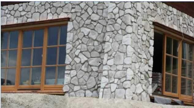
FIG. 10: Detall d'una façana revestida amb pedra artificial a Berchtesgaden (Baviera); el seu aspecte és casi idèntic a la pedra natural. Font: Gewena Stone Manufaktur
