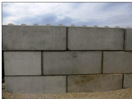
FIG. 62: Mur executat amb bloc de formigó del sistema "Lego".
