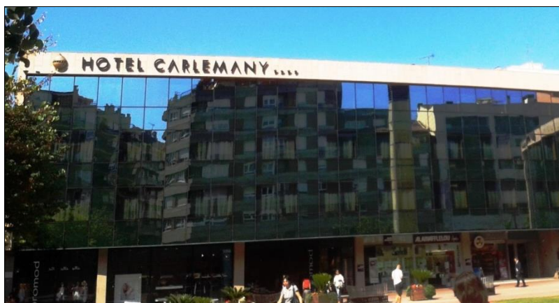
FIG.71: Fotografia de la façana de l'hotel Carlemany, situada al centre de Girona, amb el sistema mur cortina.
