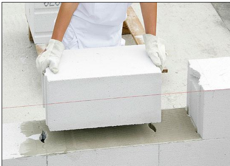
FIG.83: Construcció d'una paret amb blocs de porenbeton.
