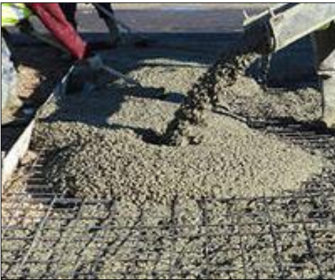
FIG.20 : Imatge de l'abocament del formigó en estat fresc.
