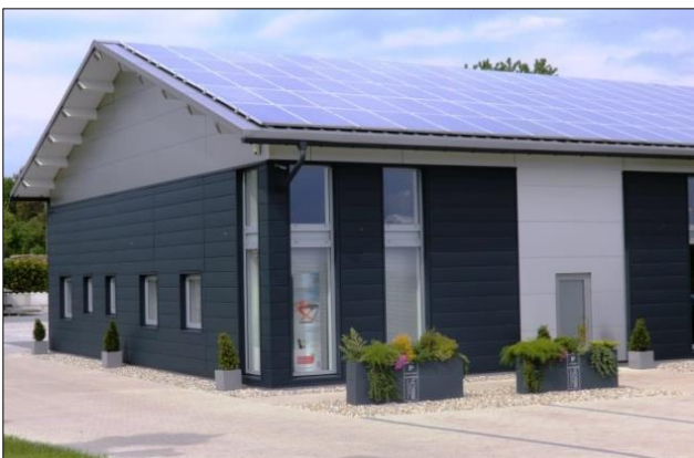
FIG. 114: Façana de botiga a Altheim/Ab construïda amb panells sandvitx de diferents colors. Font: Fotografia pròpia
