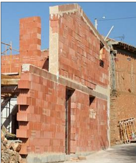
FIG.14 : Habitatge unifamiliar amb parets resistents de termoargila.
