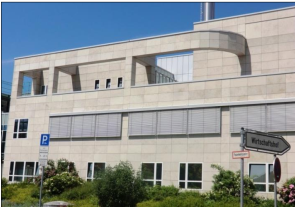
FIG. 42: Donauklinik (Clínica Donau) amb façana ventilada revestida de pedra natural, amb totes les peces de la mateixa mida a excepció dels pilars superiors. Font: Fotografia pròpia
