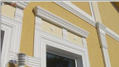
FIG. 22: Detall de façana amb revestiment d'estuc.
