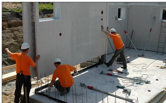
FIG. 48: Imatge de la col·locació d'un panell prefabricat de formigó de doble pell a l'obra.
