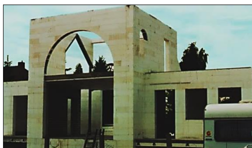
FIG. 121: Construcció d'un habitatge unifamiliar amb peces de Styroporsteine Font: Styro Stone
