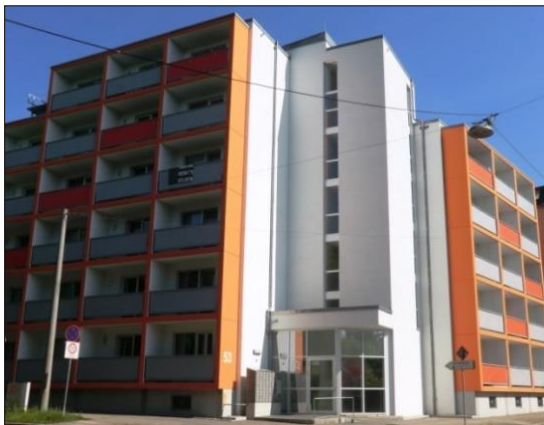
FIG. 41: Edifici residencial d'estudiants de Baviera, amb estructura de formigó armat, el qual s'ha pintat posteriorment.
