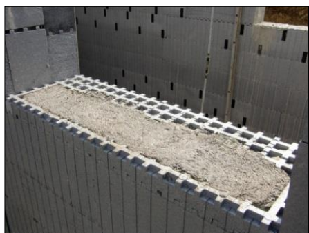
FIG. 119: Imatge de la construcció d'una paret amb el sistema de Styroporsteine. Font: Styropor Steine
