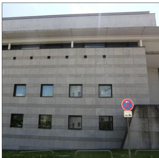
FIG. 44: Hotel amb façana ventilada revestida de pedres naturals de dues mides diferents combinades entre si. Font: Fotografia pròpia
