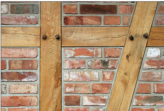
FIG. 1: Detall de la composició d'una Fachwerkfassade. Font: Spolia Backsteine
