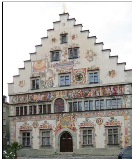
FIG. 18: Fotografia de la façana de l'ajuntament de Lindau, on sobre una capa de Putzmörtel, s'han realitzat diversos motius amb pintura.
