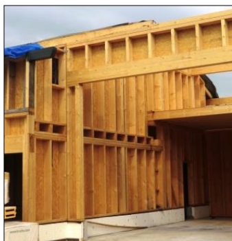
FIG.101: Imatge de l'obertura per a l'entrada al garatge d'un habitatge unifamiliar construït amb el sistema Holztafelbau, a Altheim/Alb.
