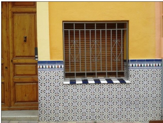
FIG.3: Detall de façana amb rajola vitrificada en la seva part inferior.
