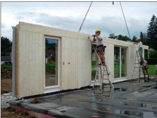
FIG.54: Fotografia d'una paret de fusta prefabricada construïda amb taulers de fusta prefabricats situant-la a l'obra.
