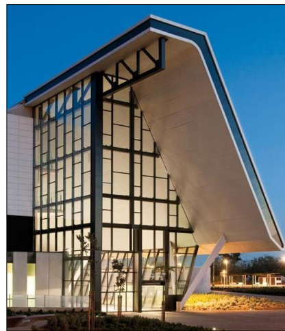
FIG.58 (dreta) : Hospital Universitari Sant Joan de Reus, on l'estructura metàl·lica que forma part de la façana es combina amb un mur cortina de vidre. Font: Lamp
