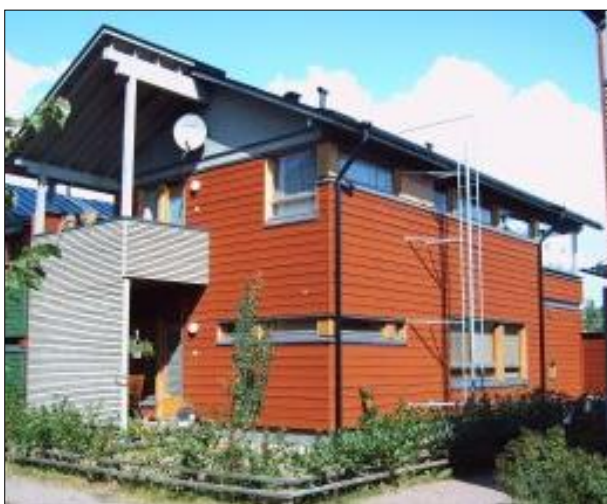
FIG. 4: Habitatge unifamiliar amb façana ventilada i revestiment de peces ceràmiques.
