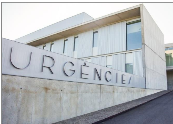
FIG. 21: Façana feta amb mur de formigó armat acabat vist i amb funció estructural del nou hospital d'Olot i Comarcal de la Garrotxa.
