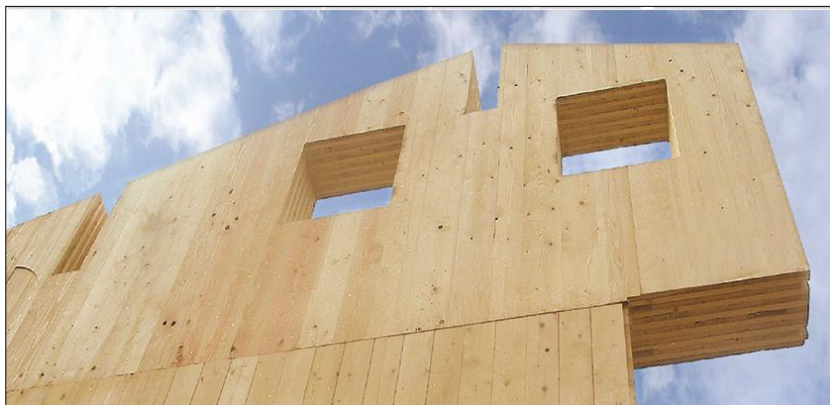
FIG.102: Imatge d'un tram de façana construït amb el sistema Massivholzbau.
