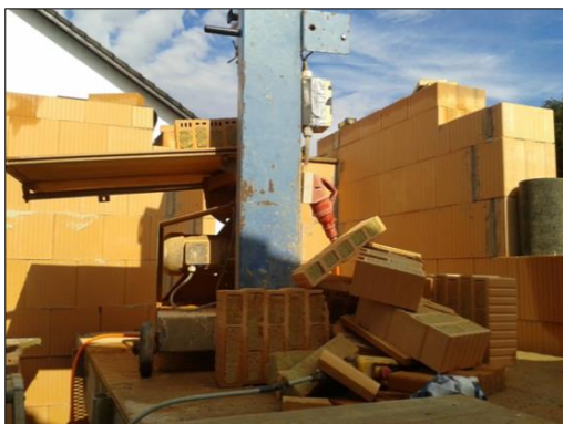
FIG. 35: Construcció d'una casa unifamiliar amb estructura metàl·lica i tancament amb bloc ceràmic amb aïllament incorporat a la zona d'Alb Donau Kreis.
