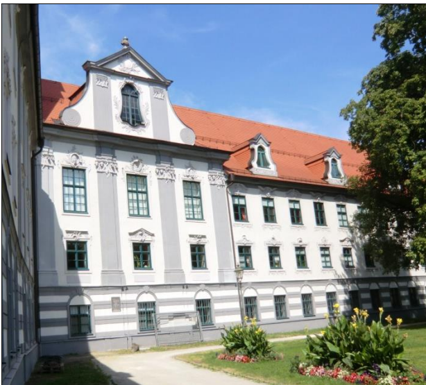
FIG. 24: Edifici de la Schwaben Regierung (Autoritat de seguretat de la zona de Baviera) a Augsburg, amb la façana decorada amb estuc i detalls Font: Fotografia pròpia
