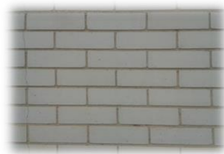
FIG.40 : Detall d'una façana construïda amb maó silici-calcarí. La seva aparença és igual a la de l'obra vista amb ceràmica porosa.
