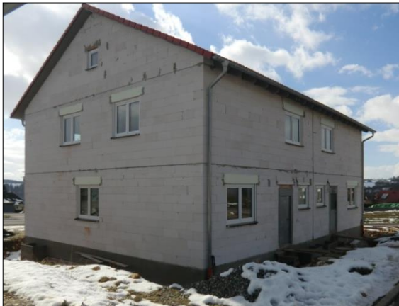
FIG.84: Cases aparellades construïdes amb blocs de Porenbeton paret a la zona de Sinnabron. Font: Fotografia pròpia
