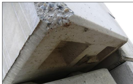
FIG. 61: Detall de les obertures de la part inferior del bloc.
