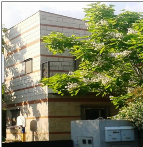
FIG.34: Façana amb bloc de formigó vist situat a la zona del baix Montseny. Font: Fotografia pròpia
