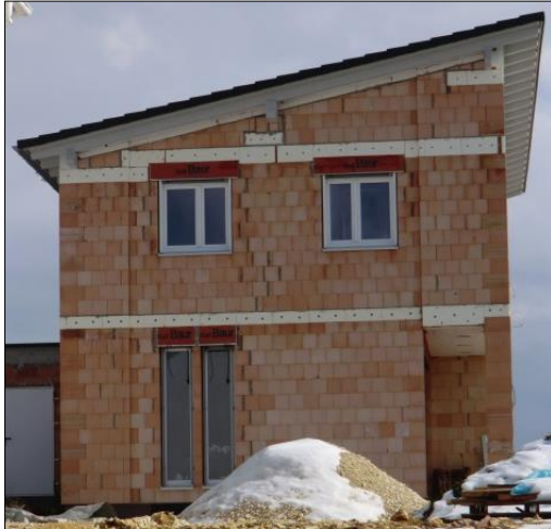
FIG. 25: Casa unifamiliar construïda amb parets de càrrega de bloc de termoargila a la zona de Baden Württemberg.
