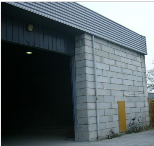
FIG. 66: Nau industrial construïda amb el sistema de blocs de formigó "Lego"
