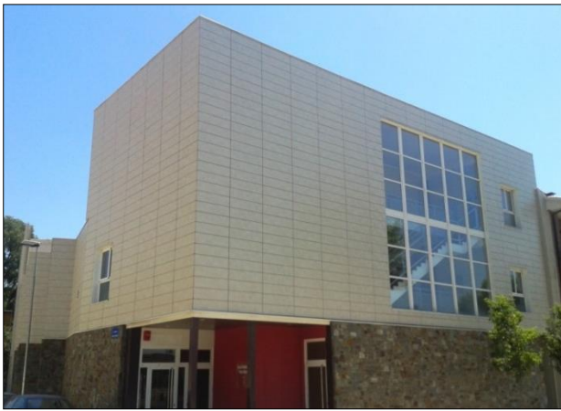
FIG.64: Façana del teatre municipal Pare Casals, a la localitat de Sant Esteve de Palautordera. Combina un revestiment de pedra natural a planta baixa, i una façana ventilada amb acabat de pedra natural a les plantes superiors.
