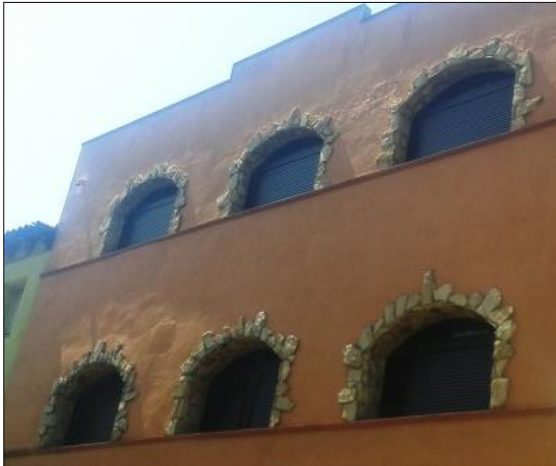
FIG.53: Imatge duna façana amb els dentells de les finestres de pedra natural, d'un edifici entre mitgeres a Tordera. La seva fixació és amb morter.
