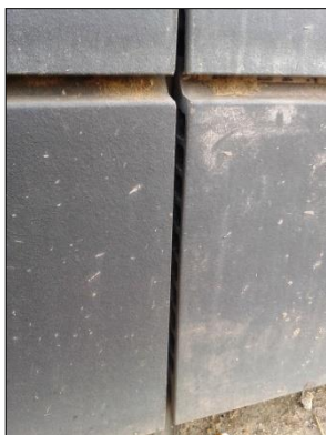
FIG.7: Detall d'encaix de revestiment ceràmic per a façana ventilada.
