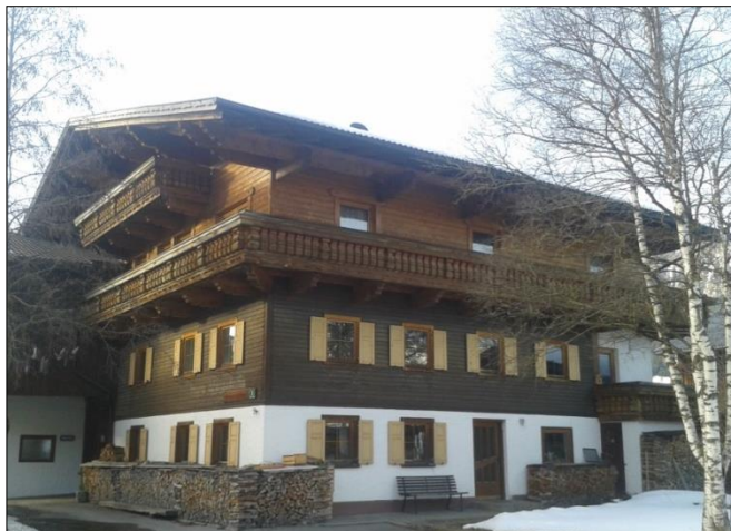
FIG. 97: Façana de fusta massissa amb la part baixa revestida, típica de les cases de la zona dels Alps alemanys (Bad Hindelang).
