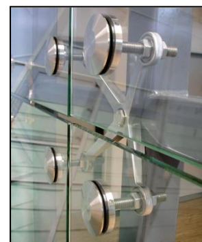
FIG. 131: Detall del sistema de fixació del mur cortina estructural . Font: FPD Systems
