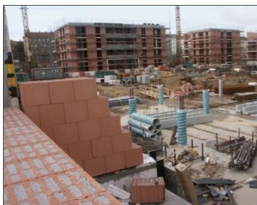
FIG. 34: Construcció d'un bloc d'habitatges plurifamiliars amb estructura de formigó armat i tancament amb bloc ceràmic amb aïllament incorporat.
