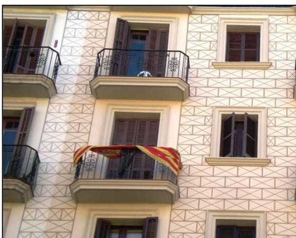
FIG.16: Façana construïda amb pedra artificial formada per dos tipus de pedra, un de més allargat i gran i un altre de forma més quadrada i petita. Font: Piedra Artificial
