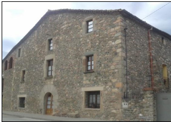
FIG.67: Fotografia d'una masia amb murs de maçoneria, situada a la vall del Montseny. Font: Fotografia pròpia
