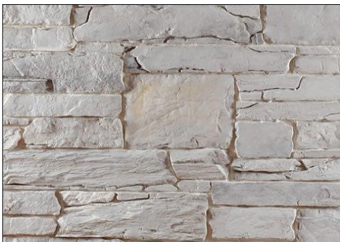
FIG. 7: Detall del revestiment d'una paret amb pedra artificial aferrada amb morter.
