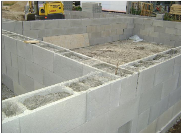
FIG. 58: Construcció d'una paret amb bloc de formigó i armat.
