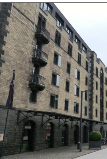
FIG. 15: Edifici amb façana Klinker de dos colors a Colònia. Font: Fotografia pròpia
