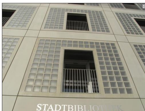
FIG. 146: Detall de la façana de la biblioteca Stadtbibliothek de Stuttgart, construïda amb blocs de vidre al voltant de cada balcó.
