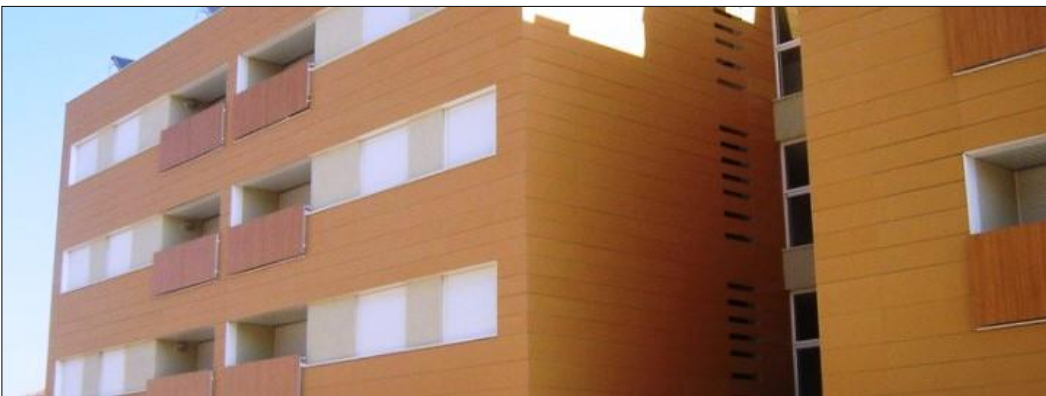
FIG.8: Fotografia d'un edifici residencial de Montblanc, amb revestiment ceràmic amb el sistema de façana ventilada.
