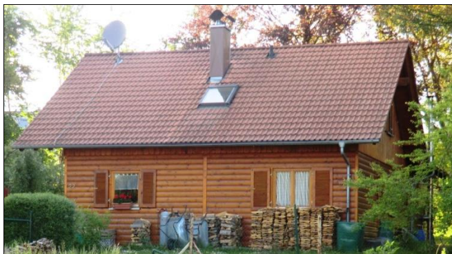
FIG.89 : Casa unifamiliar realitzada amb façana de troncs de petites dimensions, situada a Altheim/Alb. Font: Fotografia pròpia
