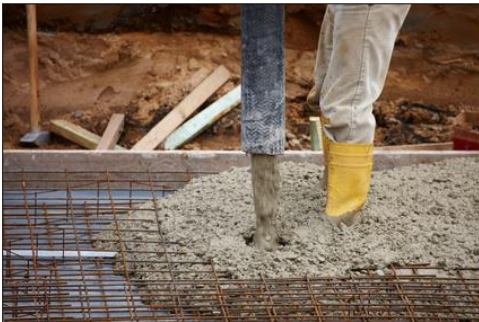
FIG. 38: Formigonat d'un forjat amb l'armadura ja col·locada.
