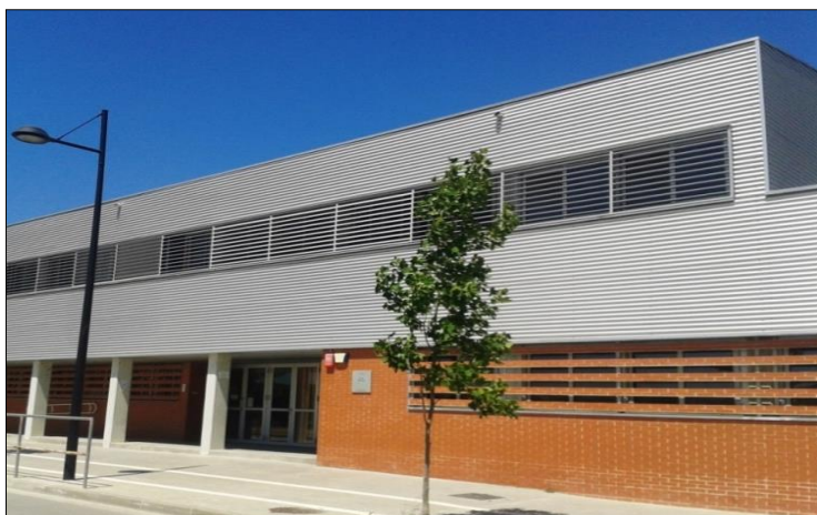
FIG.48: Ampliació de l'escola de primària Vallmanya a Sant Esteve de Palautordera, amb façana revestida amb xapa metàl·lica ondulada.
