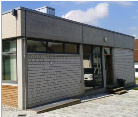
FIG. 73: Imatge d'una nau industrial, on una cara s'ha construït amb Kalksandstein.
