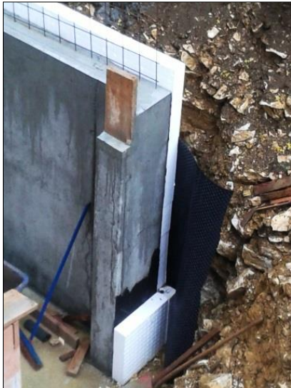
FIG. 45: Imatge de mur de formigó armat estructural, amb aïllament tèrmic per l'exterior.
