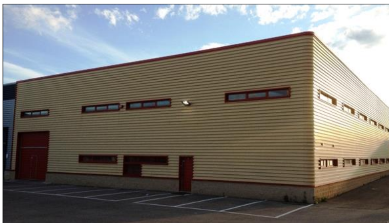
FIG.63: Nau de la Brigada Municipal de Cubelles. En aquesta façana el panell sandvitx sembla un simple revestiment amb xapa metàl·lica ondulada. Font: Copegam
