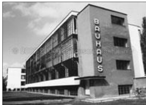
FIG. 130: Imatge de l'edifici Bauhaus. Font: Bauhaus Architektur.
