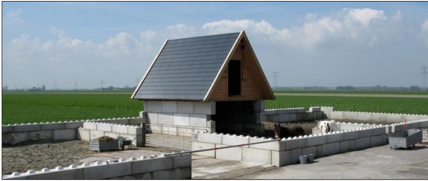
FIG. 65: Construcció d'una caseta amb blocs de formigó del sistema "Lego".
