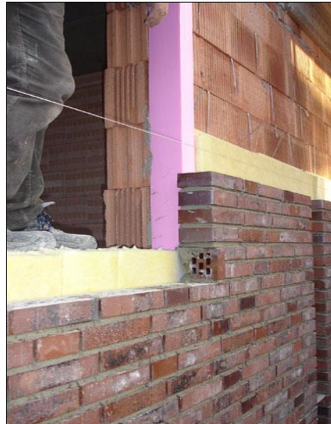
FIG. 18: Imatge on es pot veure la construcció d'una façana amb acabat de Klinker i paret resistent de bloc ceràmic, aïllament tèrmic i tancament amb Klinker.
