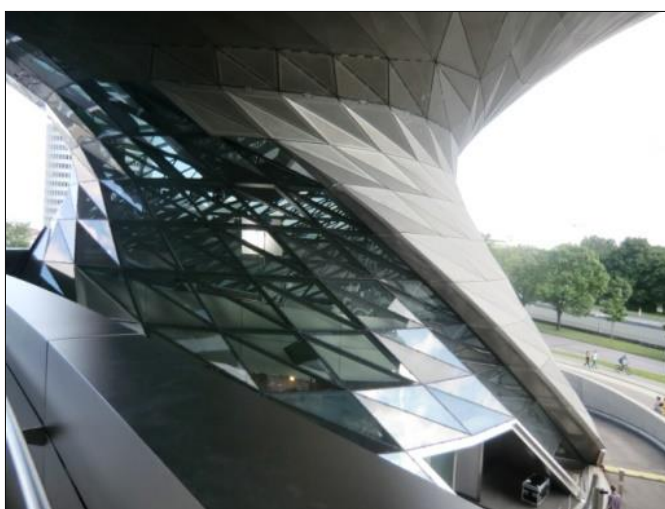
FIG. 36: Revestiment metàl·lic amb formes que s'adapten al gir de la façana del museu BMW Welt a Munich. Font: Fotografia pròpia
