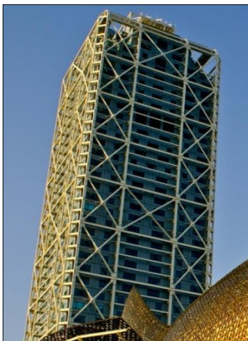
FIG.57: Hotel Arts de Barcelona, on l'estructura metàl·lica de l'edifici forma part de la façana. Font: Amat Immobiliaris
