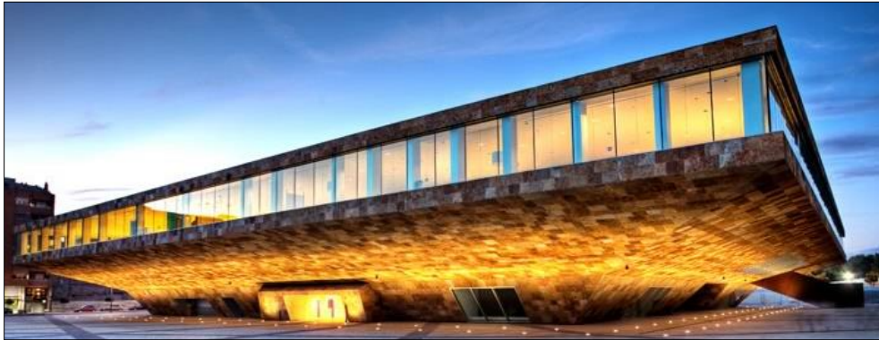
FIG.72: Façana del teatre de Lleida, amb revestiment de pedra i obertures en forma de mur cortina amb el sistema cinta finestra. Font: Teatre de la Llotja de Lleida
