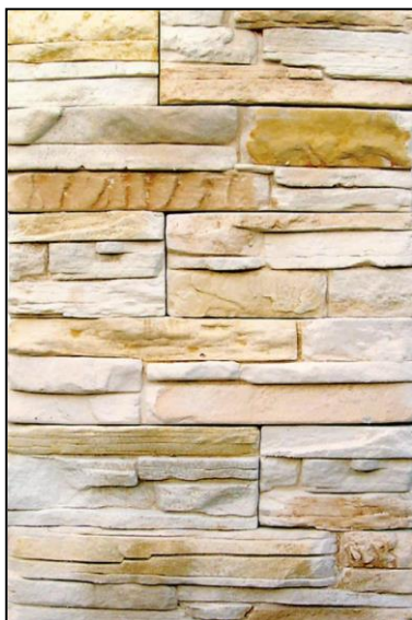
FIG. 12: Detall de revestiment de pedra artificial.
