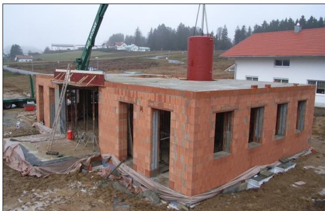
FIG. 33: Casa unifamiliar construïda amb parets resistents de bloc de termoargila amb aïllament incorporat.
