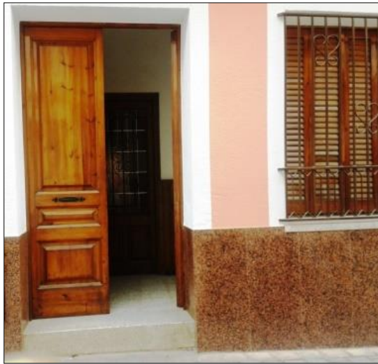
FIG.56: Detall d'un aplacat de pedra natural que decora la façana des del costat del carrer fins l'ampit de la finestra.
