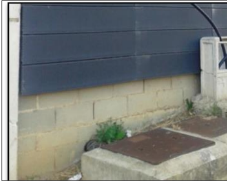
FIG.36: Façana amb tancament bloc de formigó per a façana ventilada.
