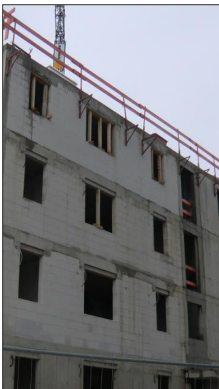
FIG.85 i 86: Edifici d'habitatges plurifamiliar realitzat amb estructura de formigó armat i parets de tancament de Porenbeton, a la zona residencial d'Ulm.
