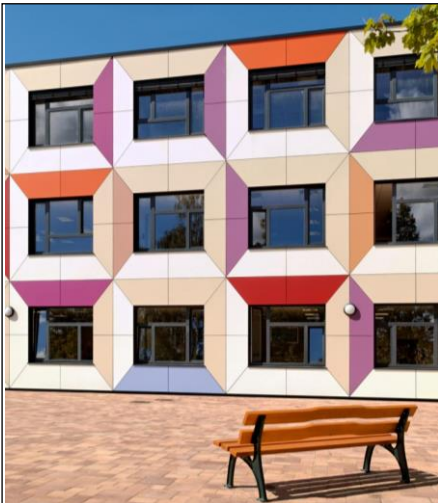
FIG. 48: Imatge de la façana de l'institut Glienicke Gymnasium, revestida amb panells laminats a alta pressió, que li donen cert volum sortint al voltant de les finestres.
