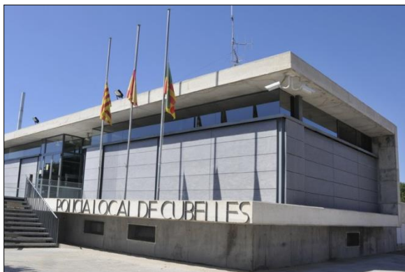
FIG.22 : Façana de formigó armat no estructural de la comissaria de la policia local de Cubelles. Font: Cubelles
