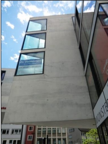
FIG. 43: Edifici comercial amb voladís realitzat amb murs de formigó no estructural a la zona peatonal i comercial d'Ulm. Font: Fotografia pròpia
