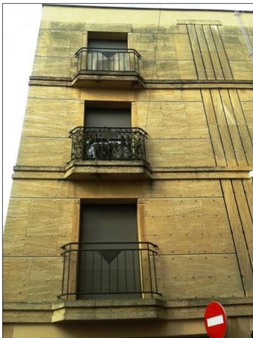
FIG.55: Fotografia d'un habitatge plurifamiliar amb aplacat de pedra fixat mecànicament amb fixacions vistes, situat a Palautordera.
