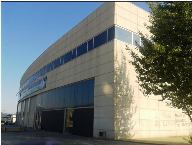
FIG. 28: Nau industrial realitzada amb panells de formigó prefabricat al Polígon Industrial Santa Maria Park a tocar de Sant Celoni. Font: Fotografia pròpia
