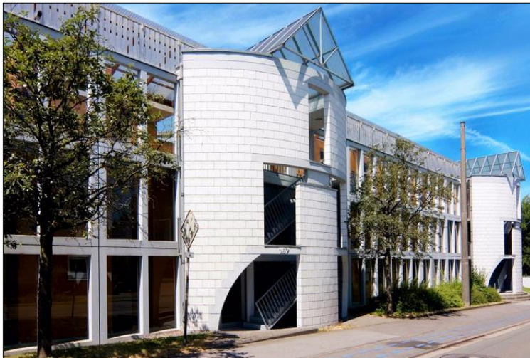
FIG. 74: Edifici d'habitatges plurifamiliars, on l'entrada s'ha fet amb façana de kalksandstein.
