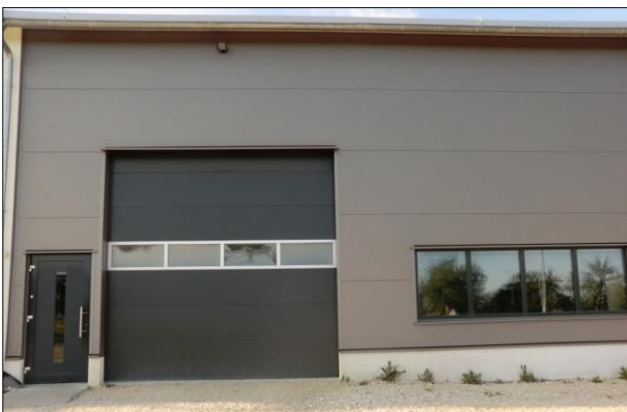
FIG. 113: Nau industrial amb façana de panell sandvitx. Font: Fotografia pròpia
