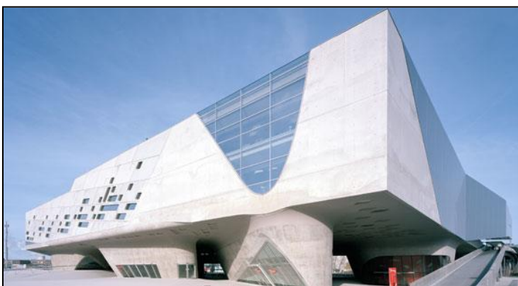
FIG. 42: Phaeno Science Center a Wolfsburg, un museu dedicat a la ciència, realitzat amb un volum de formigó armat, amb diferents finestres integrades a mode asimètric, i zones amb murs cortina integrats al volum, que permeten una gran entrada de llum natural.
