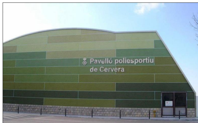
FIG.29: Imatge de la façana principal del Pavelló poliesportiu de Cervera, revestida amb la tècnica de l'estucat amb diferents tonalitats de color verd, i amb juntes imitant les plaques d'un revestiment discontinu.
