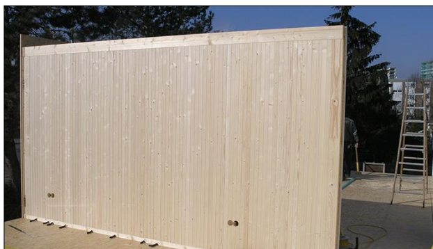
FIG.98: Vista interior de paret construïda amb el sistema de Brettstapelbau.
