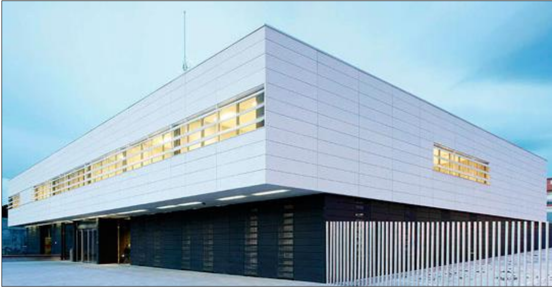
FIG.75: Façana de la comissaria dels Mossos d'Esquadra de Cambrils, construïda amb façana ventilada i revestida amb plaques de ciment reforçades amb fibres de cel·lulosa.
