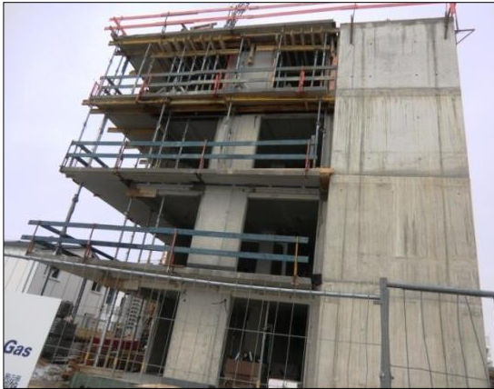
FIG. 40: Construcció d'un edifici plurifamiliar amb estructura de formigó a la nova zona residencial d'Ulm.
