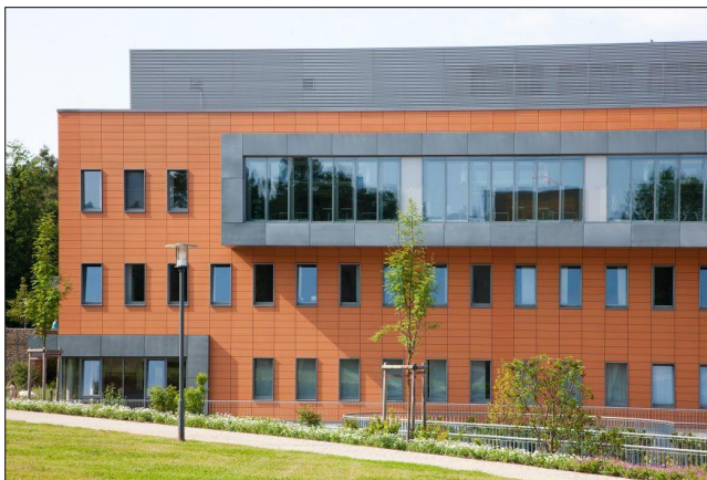
FIG. 2: Edifici d'oficines amb façana ventilada revestida de peces ceràmiques.
