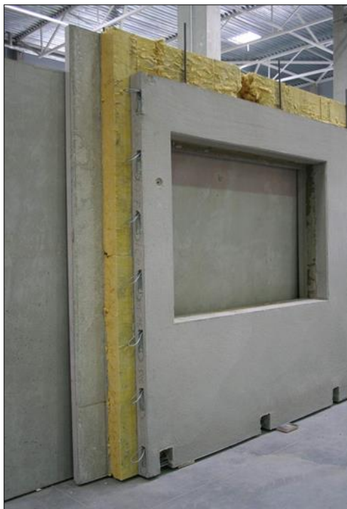
FIG.26: Panell de formigó prefabricat tipus sandvitx, on es diferencien el panell interior i exterior, i el gruix considerable d'aïllament. També inclou l'obertura de la finestra. Font: Weckenmann
