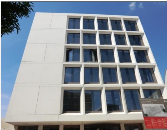
FIG. 50: Edifici de la caixa d'estalvis Sparkasse Ulm, amb la façana formada per peces prefabricades de formigó.
