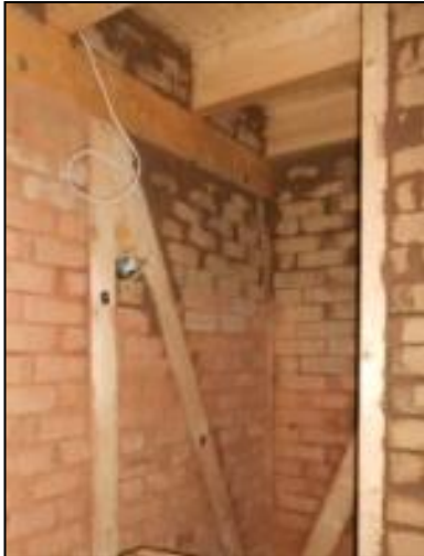
FIG. 6: Paret interior de la Fachwerkhaus sense revestir, on es pot observar l'estructura de fusta, i les peces d'argila que omplen els espais de la paret. Font: Kalk Lehmputz
