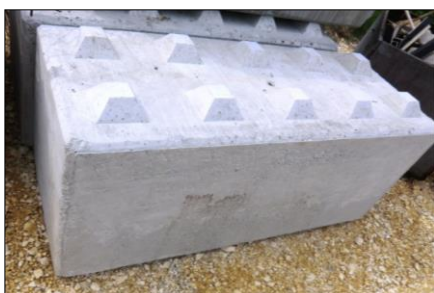
FIG. 60: Bloc de formigó en massa amb forma de peça de "Lego".
