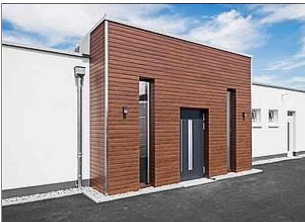
FIG. 49: Imatge d'una casa unifamiliar a Schondra, on el cos sortint on es troba l'entrada principal s'ha revestit amb peces de compost de fusta i polímer, on a simple vista sembla fusta natural.
