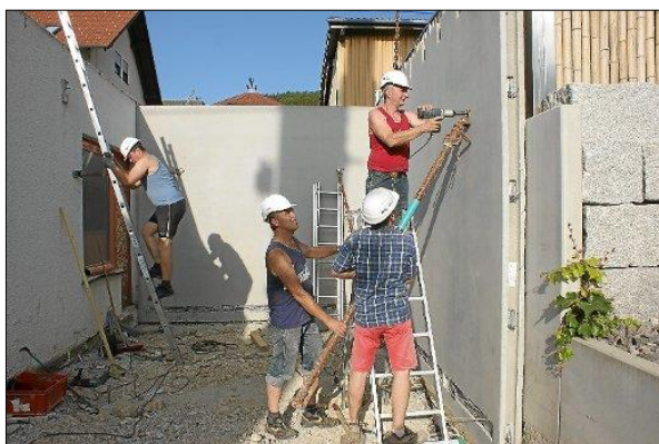
FIG. 47: Imatge de la fixació d'un panell prefabricat de formigó armat simple.
