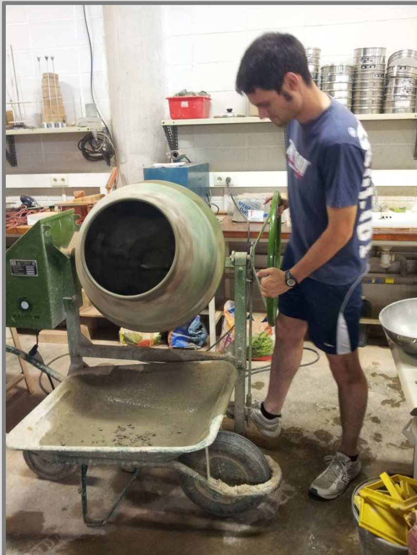
Imatge 74: Pastat de formigó mitjançant formigonera. Autor: Guillem Martí / Font: Pròpia
