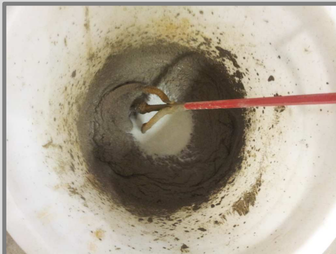
Imatge 15: Addició de vidre en pols en la fabricació de formigó. Autor: Guillem Martí / Font: Pròpia
