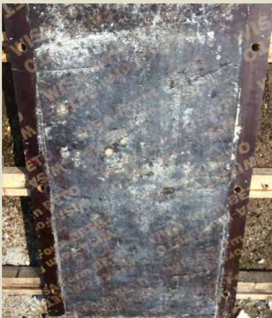
Imatge 2.6: Desencofrat motlle de planxa. Consistència fluida (+20l aigua) (MF2A3). Foto: Albert Coromina / Font: Pròpia
