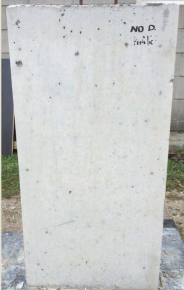
Imatge 2.15: Desencofrat motlle mixta. Lateral encofrat tauler fenòlic (MM1A3).
