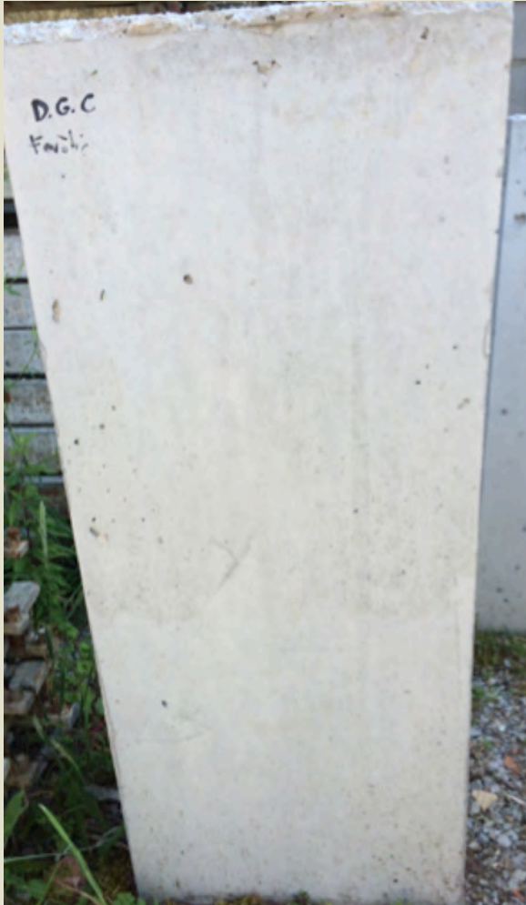
Imatge 1.8: Desencofrat motlle de tauler fenòlic (MF1A3).
