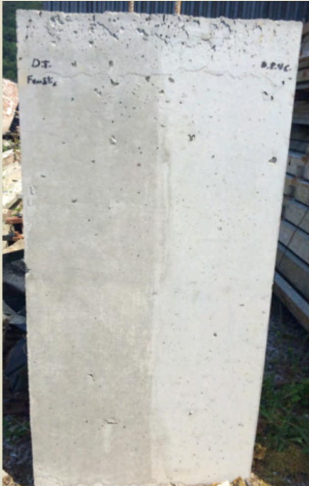
Imatge 2.7: Desencofrat motlle de tauler fenòlic (MF2A3).
