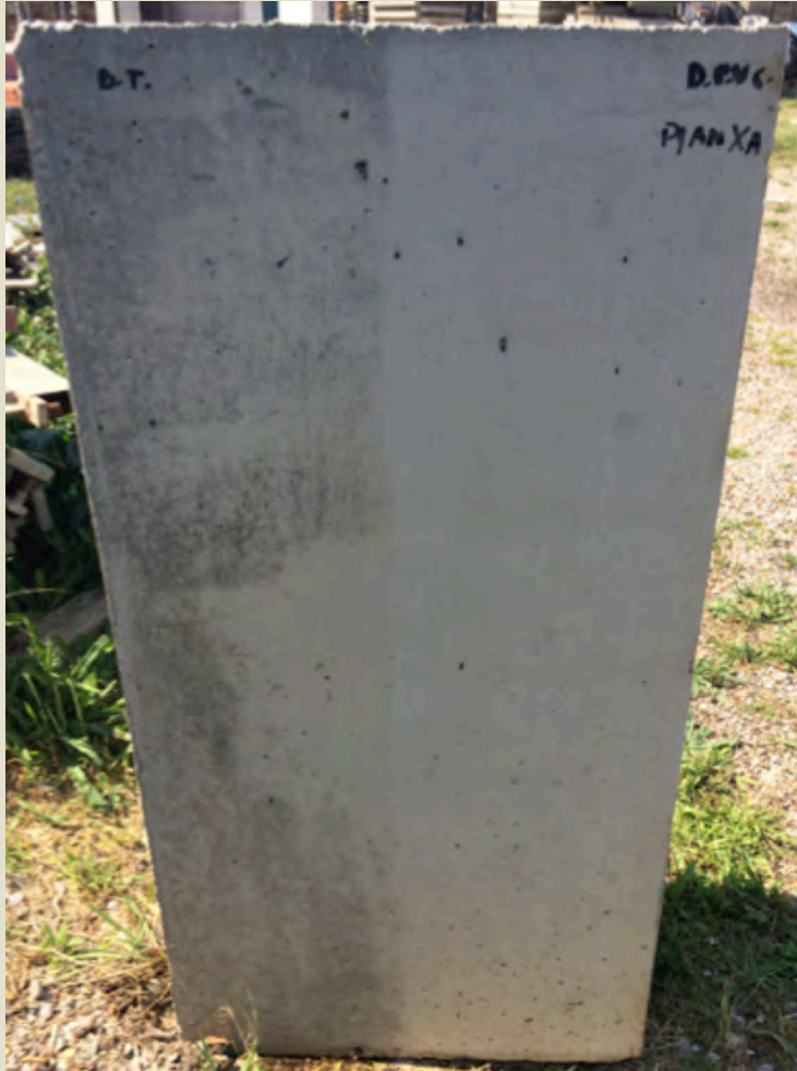
Imatge 2.3: Desencofrat motlle de planxa (MP2A3).
