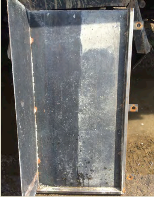
Imatge 1.1: Desencofrat motlle de planxa (MP1A3).
