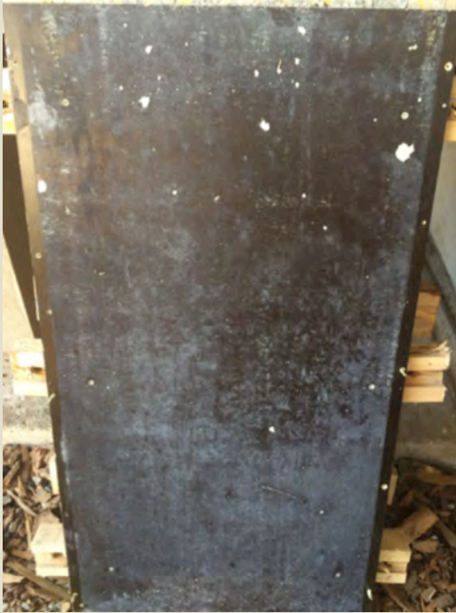
Imatge 2.13: Desencofrat motlle mixta. Lateral tauler de fenòlic (MM1A3). Consistència tova. Foto: Albert Coromina / Font: Pròpia
