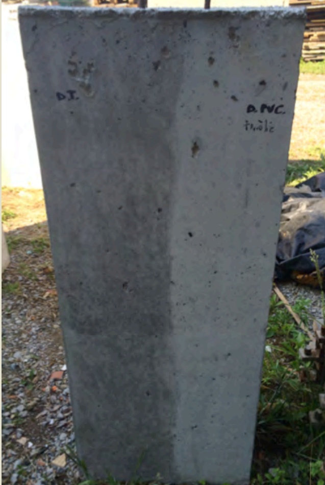
Imatge 1.7: Desencofrat motlle de tauler fenòlic (MF1A3).
