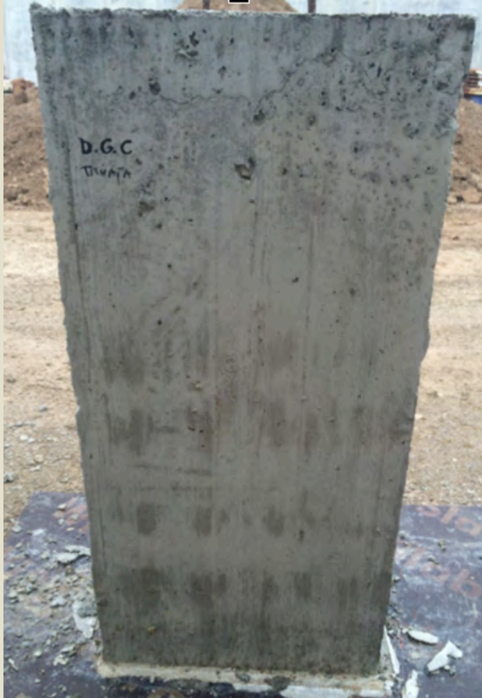
Imatge 1.12: Desencofrat motlle de tauler fusta de pi (MT1A3).
