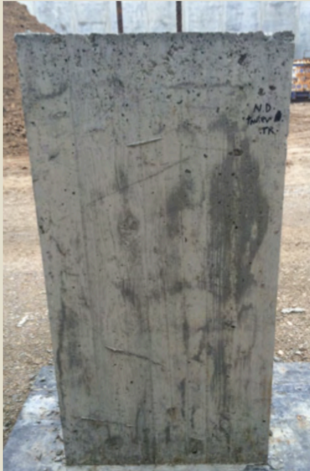
Imatge 2.16: Desencofrat motlle mixta. Lateral encofrat tauler fusta de pi (MM1A3).
