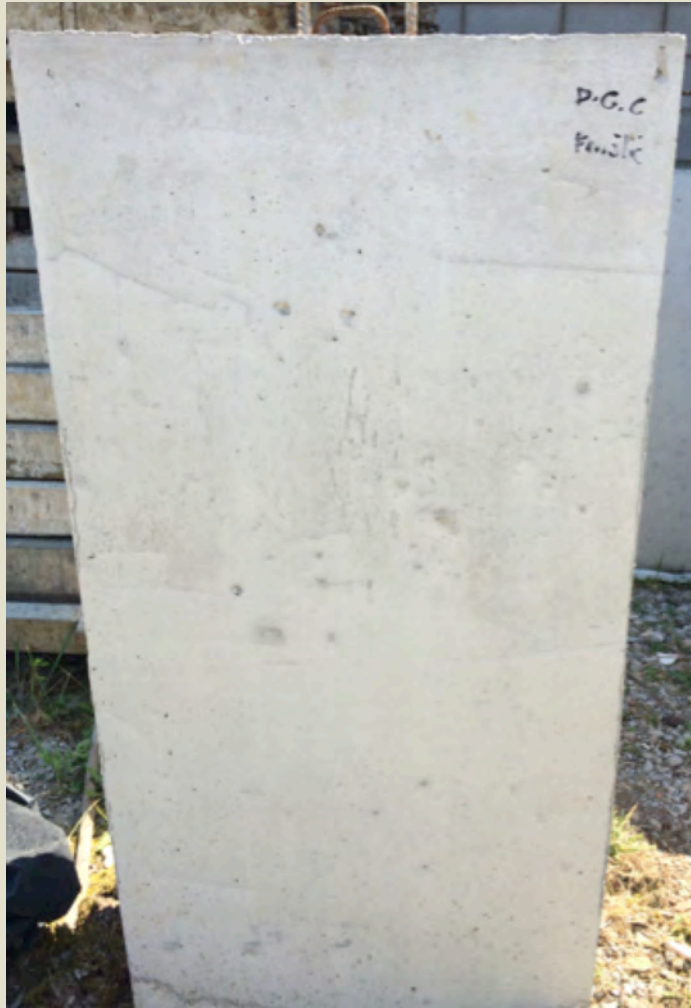
Imatge 2.8: Desencofrat motlle de tauler fenòlic (MF2A3).
