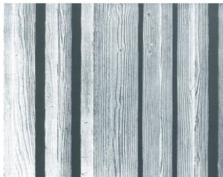
Figura 5. 10 – Textura de l'acabat dels panells de tancament prefabricats
