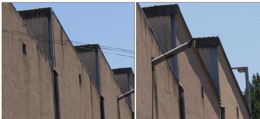
Figura 41. Acabat lateral de les dents de serra en la façana oest de la nau industrial. Ordenades d'esquerra a dreta: Tres dents més properes a la façana nord de la nau, dos dents més allunyades de la façana nord de la nau
