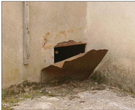
Figura 9. Obertura de la planxa metàl·lica
