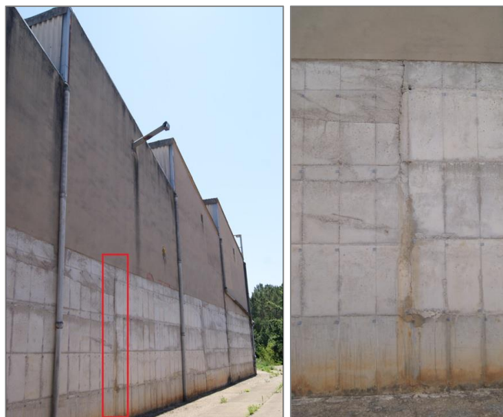
Figura 27. Esquerda C en la façana oest de la nau industrial
