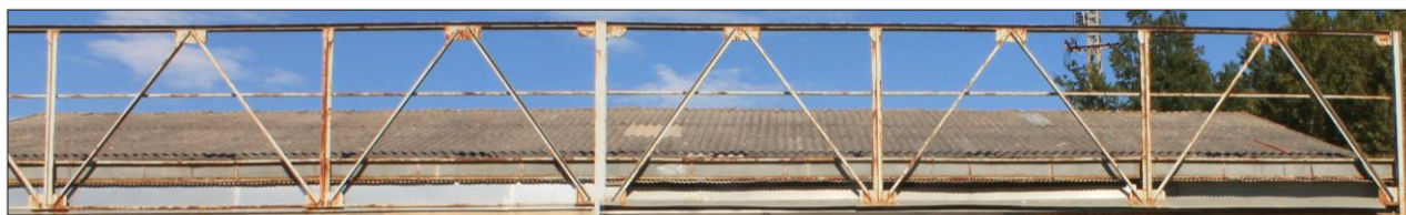
Figura 40. Part de l'encavallada Warren de la façana sud-est
