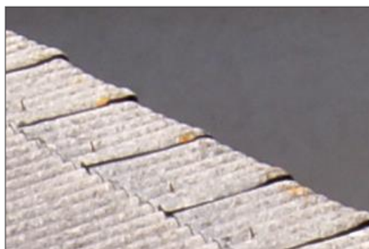
Figura 47. Presència de fongs en l'ala ondulada dels cavallets de la nau industrial
