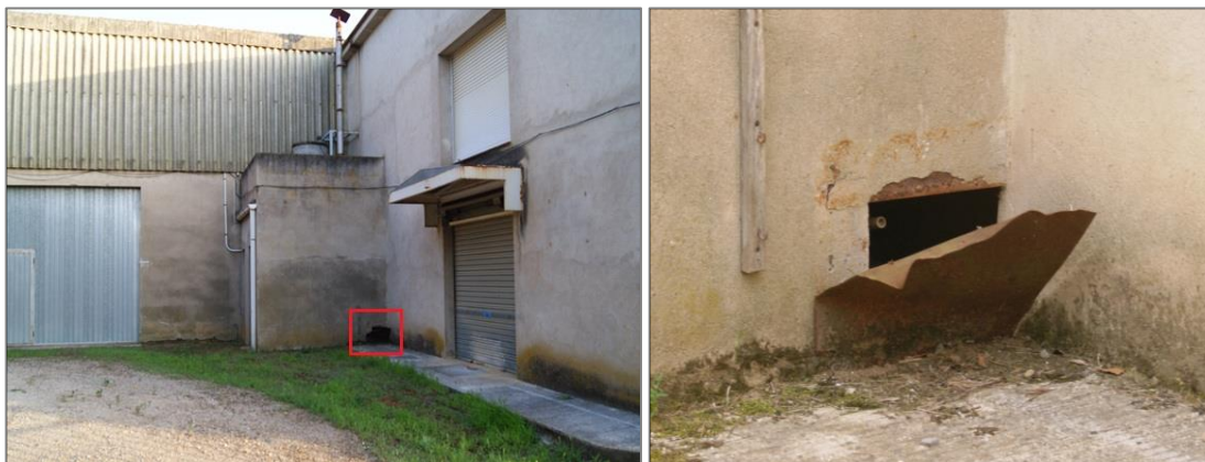
Figura 37. Obertura de la planxa en el tancament nord de la construcció complementària a l'edifici 1
