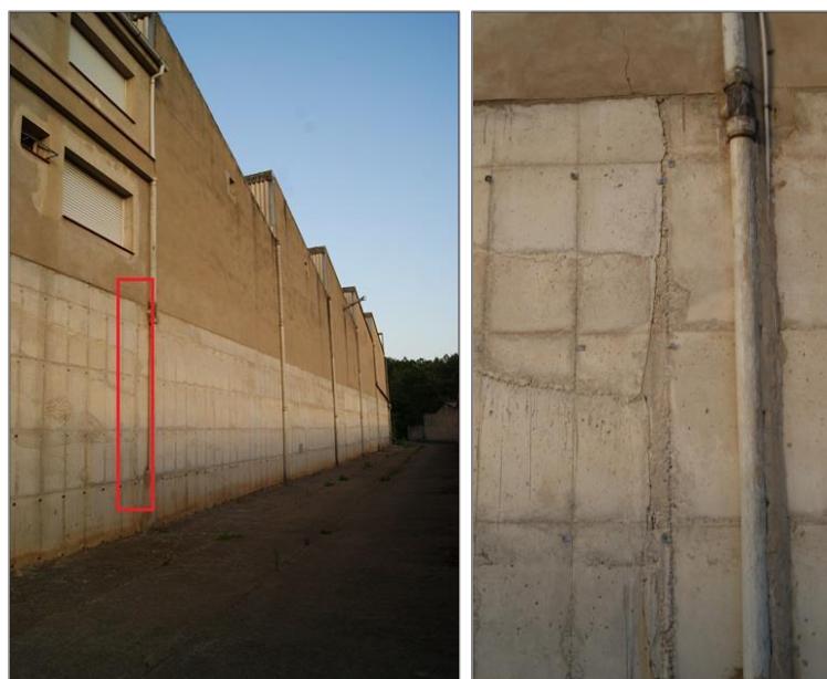
Figura 26. Esquerda B en la façana oest de l'edifici 1
