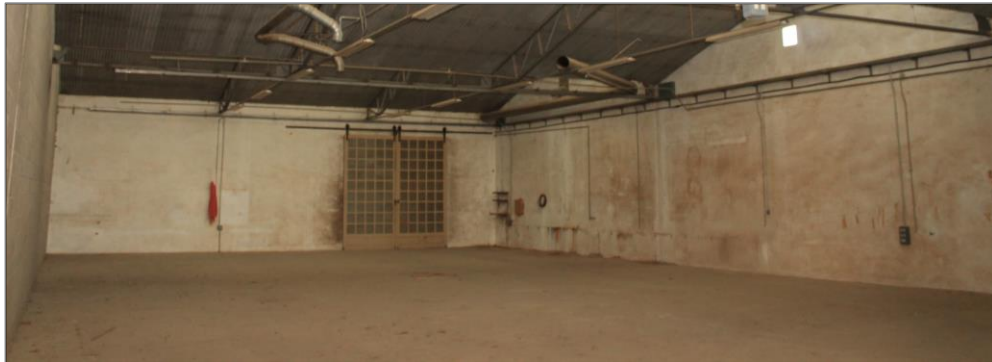
Figura 19. Paviment interior de la nau industrial
