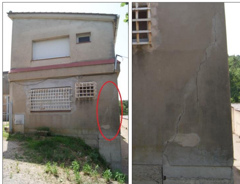
Figura 25. Esquerda A en la façana nord de l'edifici 1
