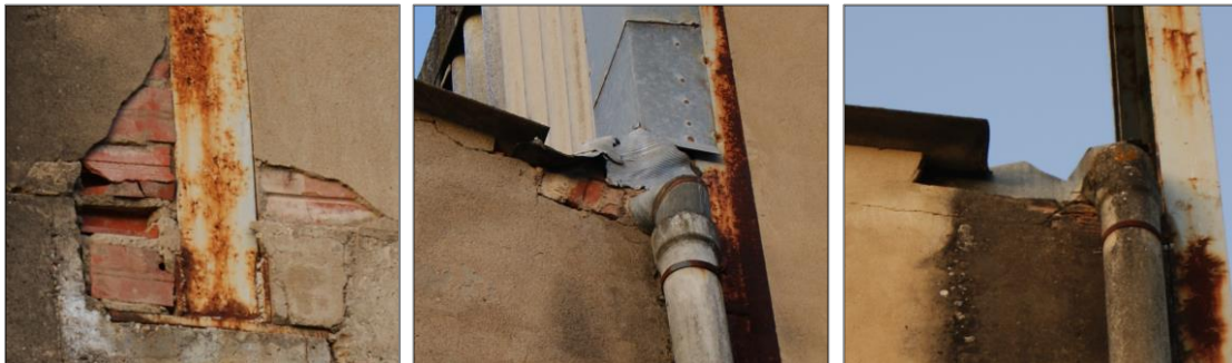
Figura 2. Representació gràfica de les ruptures. Ordenades alfabèticament d'esquerre a dreta (ruptura A, ruptura B i ruptura C)
